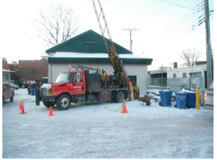
PHOTO 14 Foreuse CME, modèle 55 utilisée lors des travaux
