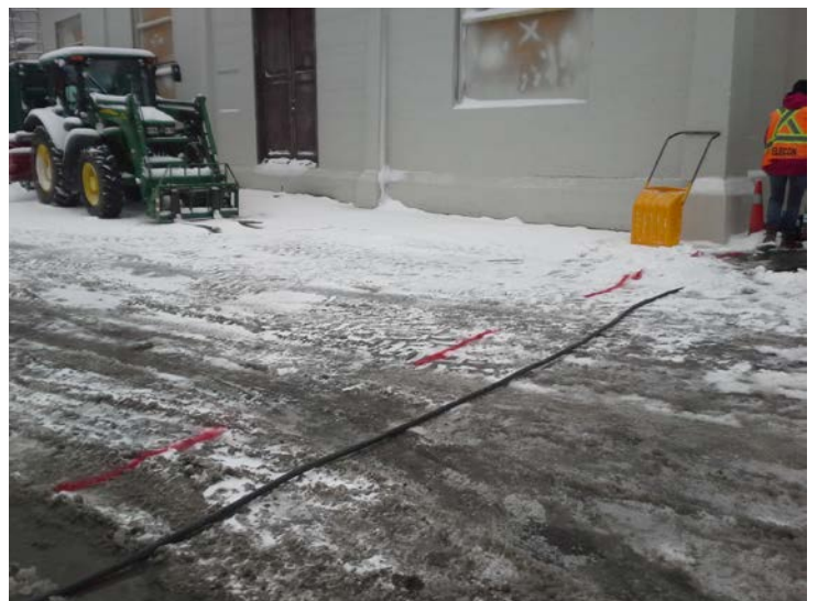
PHOTO 12 Localisation des infrastructures souterraines réalisée par la compagnie Promark-Telecon le 22 novembre 2016
