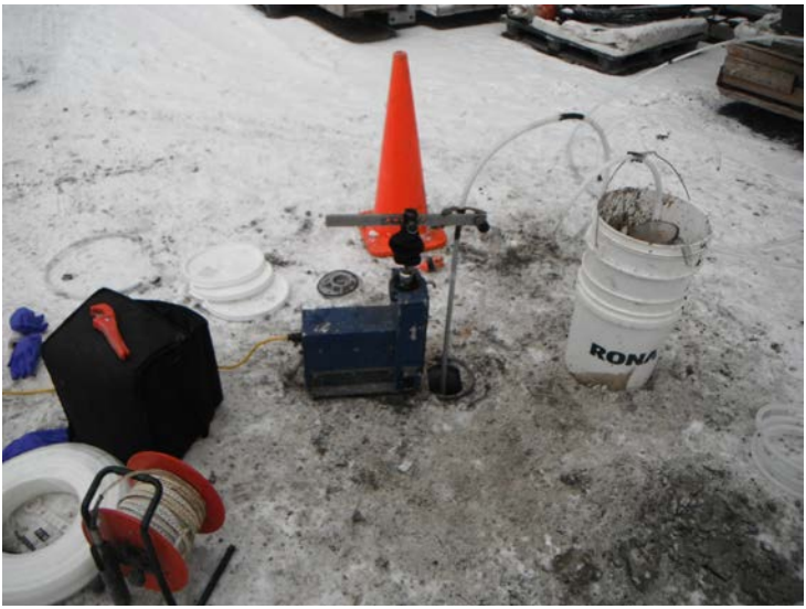
PHOTO 15 Pompe à piston utilisée pour le développement des puits d'observation
