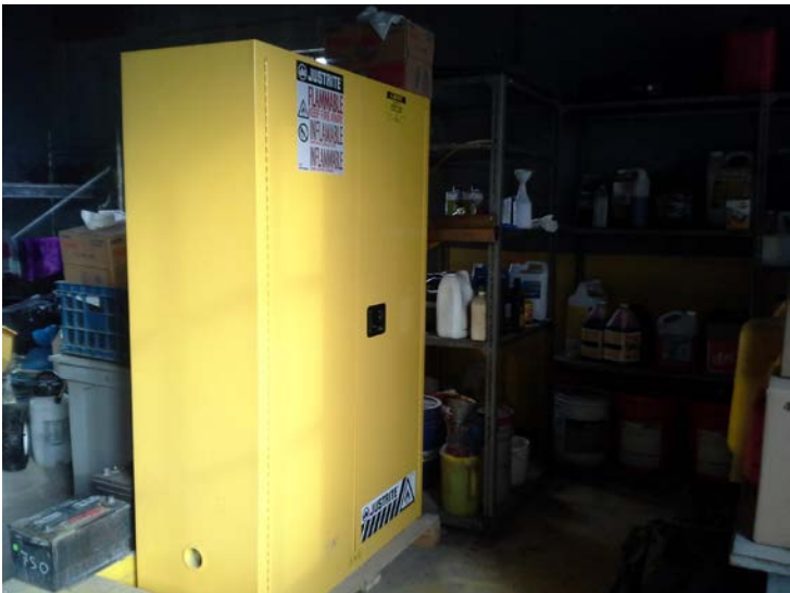
PHOTO 9 Entreposage de matières dangereuses
