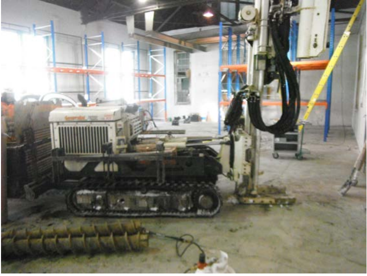
PHOTO 13 Foreuse Geoprobe 7822 DT utilisée lors des travaux
