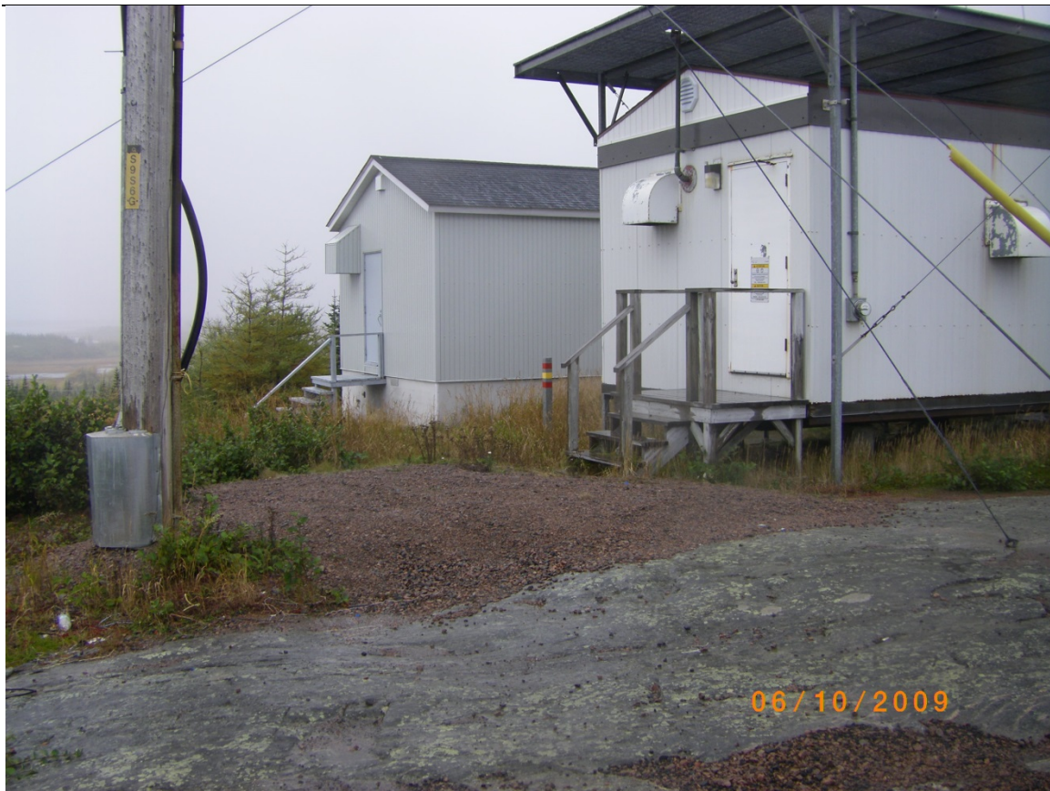
Photo 6 : Poteau électrique et présence de roc en surface.
