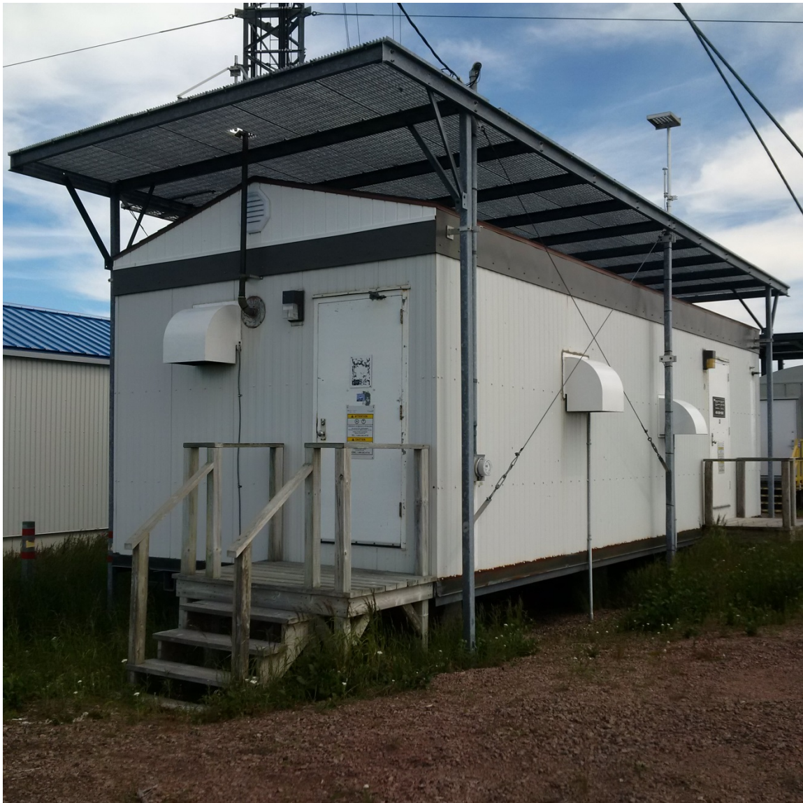
Photo 3 : Abri de la GCC existante
