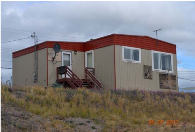
Arviat et Baker Lake : Design typique d'une maison.
