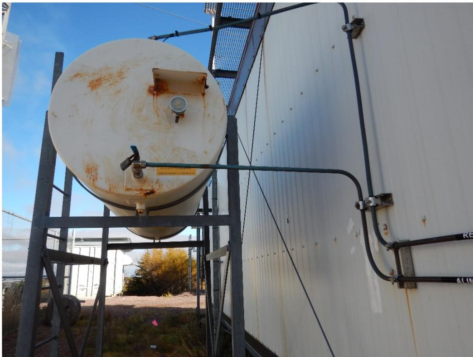
Photo 2: Réservoir hors sol de diesel situé au nord de la roulotte de la GCC (vue vers l'est)
