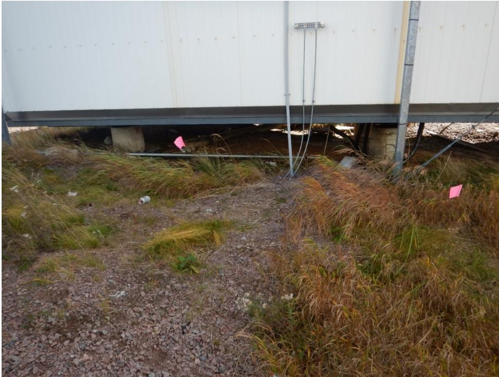
*Photo 5 : Câbles électriques enterrés entre le bâtiment de Telus et la roulotte de la GCC (vue de la façade nord de la roulotte de la GCC)*
