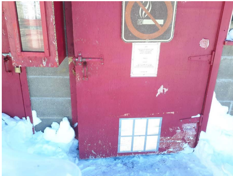
Photo 2- Peinture rouge sur porte en bois contient moins de 1000 mg/kg de plomb.
