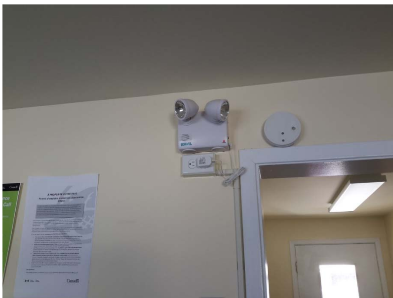
Photo 4 – Présence de lumières de sortie de secours dont les batteries contiennent du plomb
