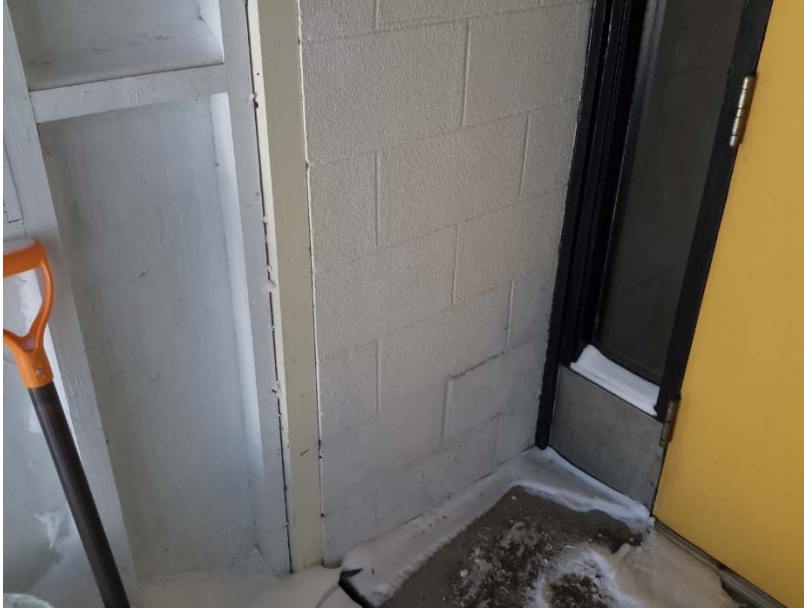
Photo 9 – Présence d'amiante chrysotile dans l'enduit texturé appliqué sur les blocs de béton des murs extérieurs.
