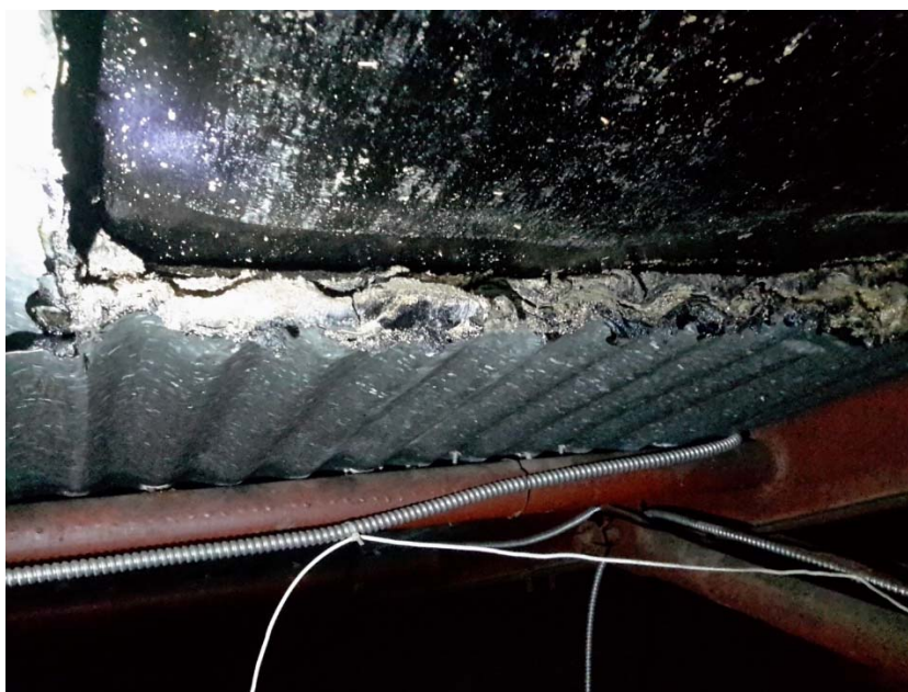
Photo 6 – Le goudron noir présent sous la tôle du plafond contient de l'amiante
