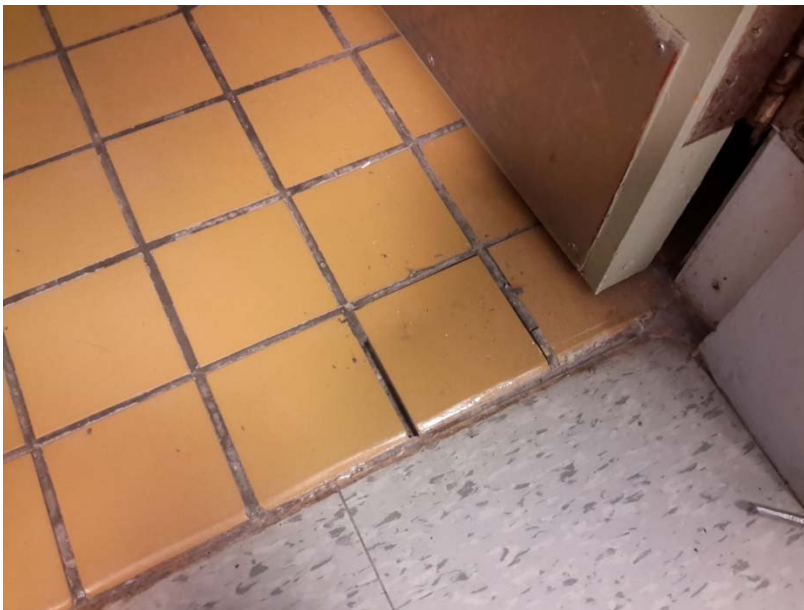
Photo 6 – Présence de céramique contenant de la silice.
