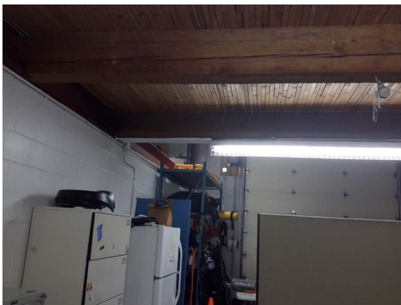
Photo 4 – Présence de fluorescent contenant du mercure.
