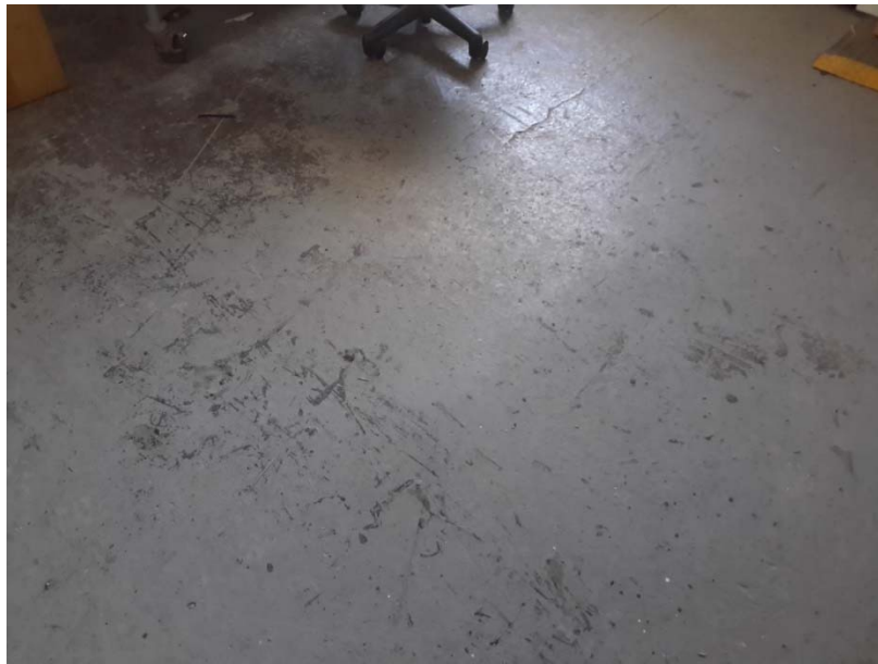
Photo 8 – Présence de plancher en béton coulé contenant de la silice.
