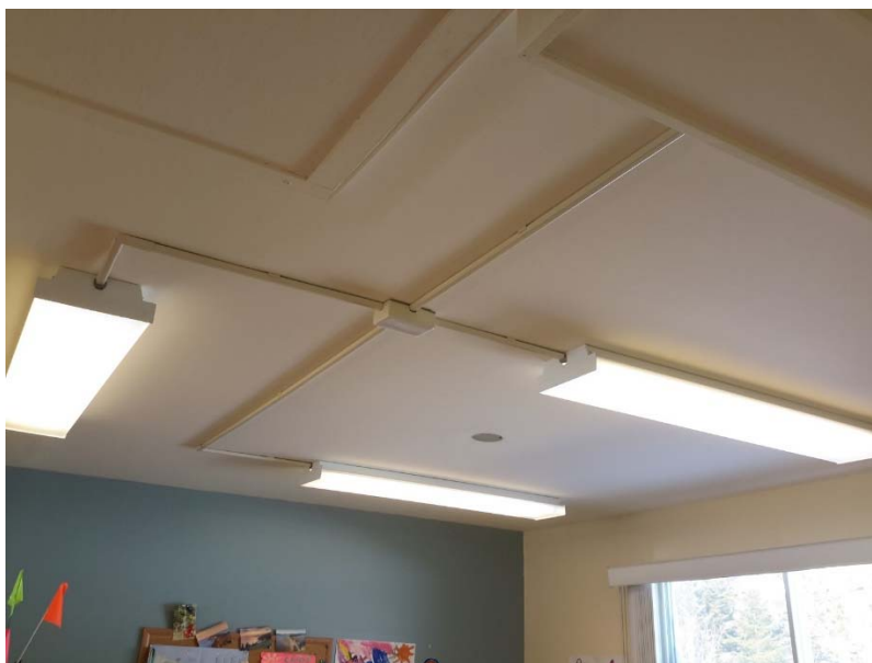
Photo 3 – Présence de fluorescents contenant du mercure. Compte tenu de l'âge du bâtiment les ballastes sont considérés comme contenir des BPC
