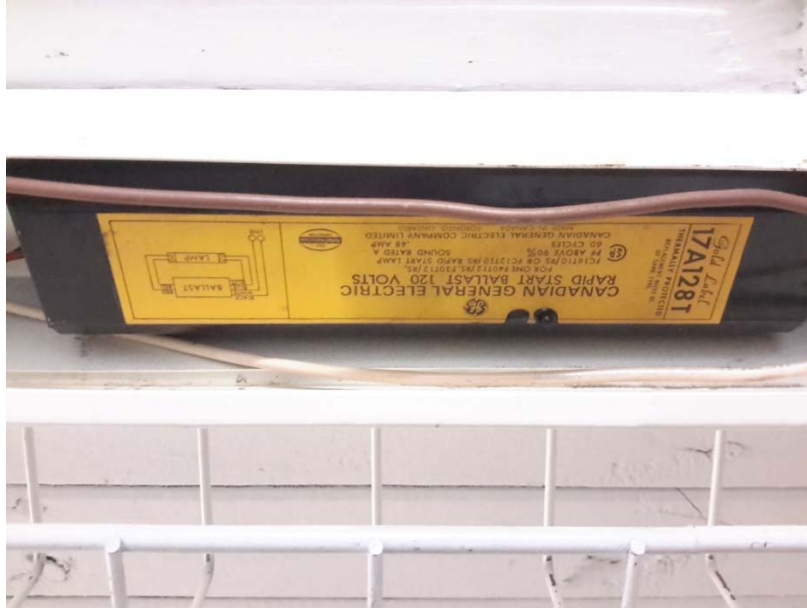
Photo 3 – Selon l'année de construction du bâtiment, les ballastes sont susceptibles de contenir des BPC.
