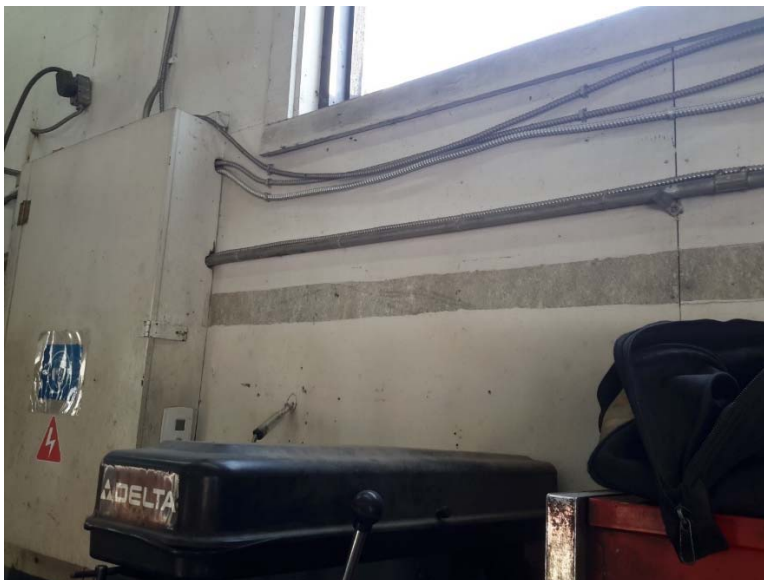
Photo 5 – Présence de panneaux de fibrociment contenant de l'amiante sur les murs
