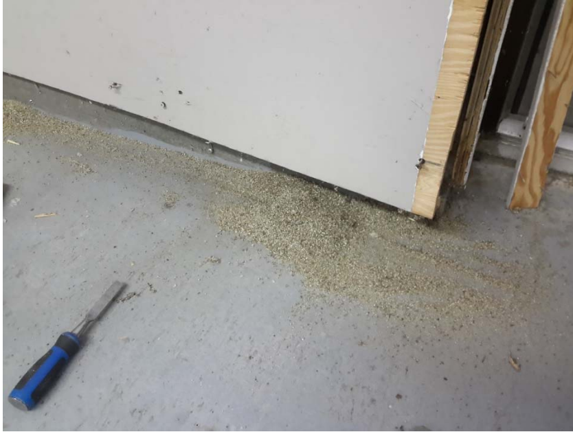
Photo 9 – Présence d’amiante trémolite dans la vermiculite située dans les murs extérieurs au rez-de-chaussée.
