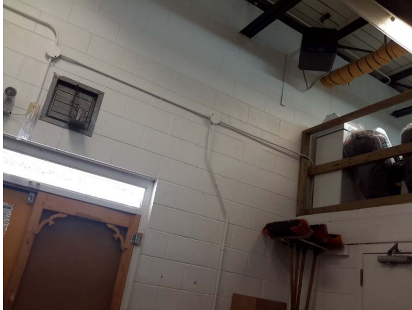
Photo 7 – Présence de bloc de béton contenant de la silice.
