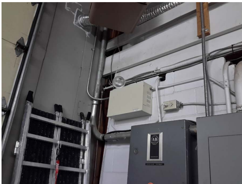
Photo 2 – Présence de lumières de sortie de secours dont les batteries contiennent du plomb.
