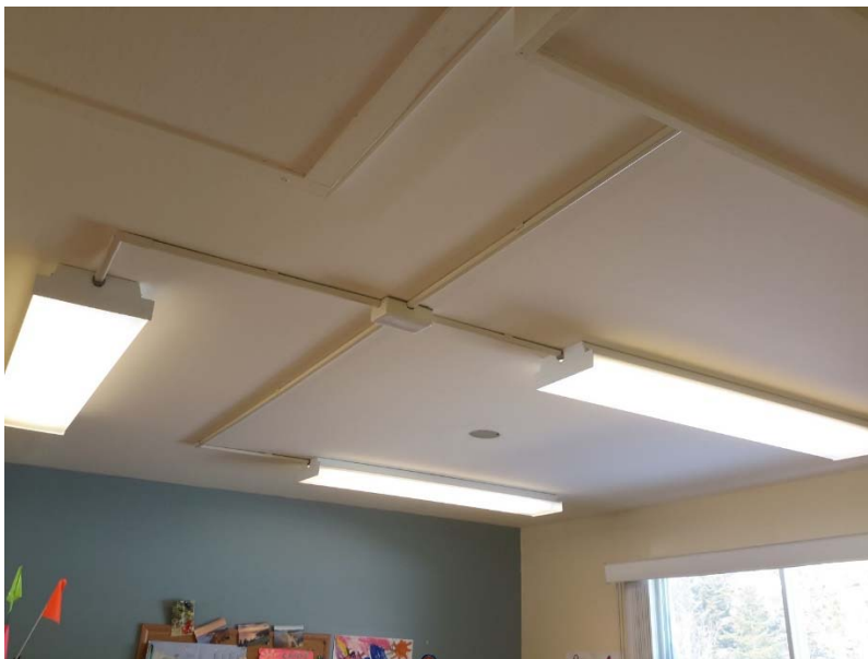
Photo 3 – Présence de fluorescents contenant du mercure. Compte tenu de l'âge du bâtiment les ballastes sont considérés comme contenir des BPC
