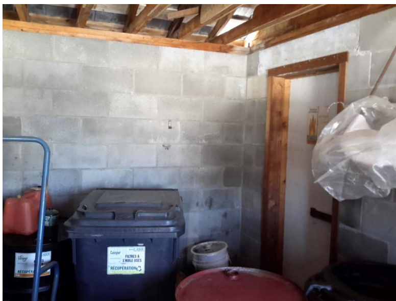
Photo 3 – Présence de bloc de béton contenant de la silice.
