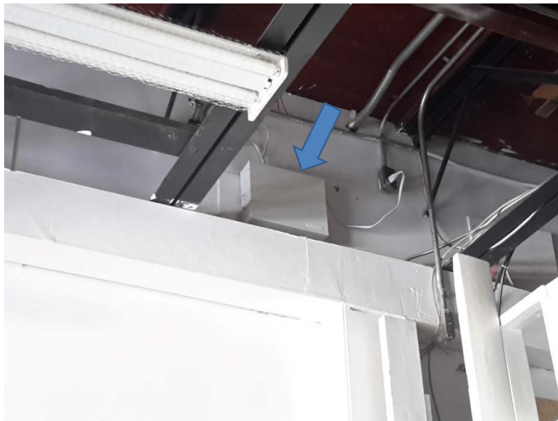
Photo 4 – Présence de lumières d'urgence dont les batteries sont susceptibles de contenir du plomb.
