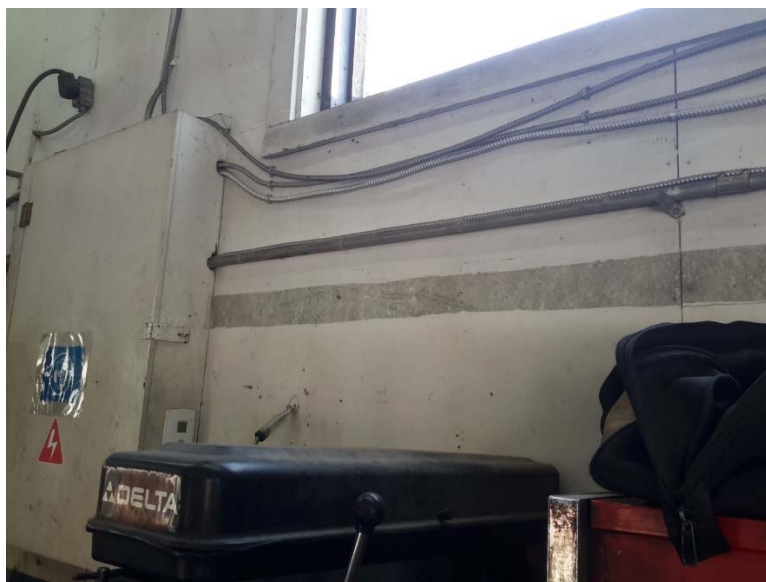
Photo 5 – Présence de panneaux de fibrociment contenant de l'amiante sur les murs
