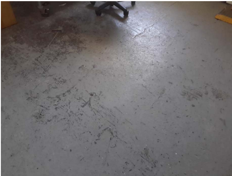
Photo 8 – Présence de plancher en béton coulé contenant de la silice.
