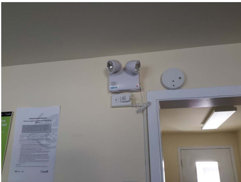
Photo 4 – Présence de lumières de sortie de secours dont les batteries contiennent du plomb
