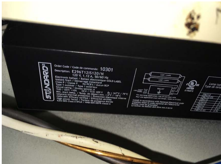
Photo 5 – Ballaste contenant du BPC.
