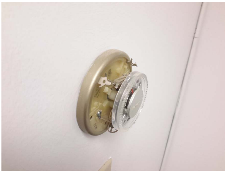
Photo 3 – Présence de thermostat contenant du mercure.
