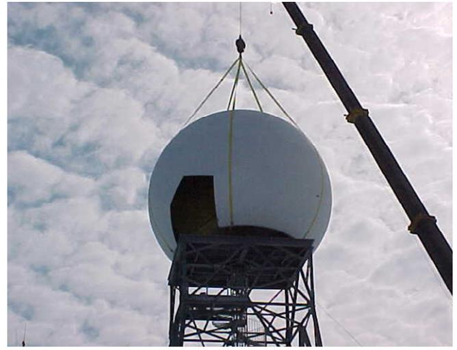
Installation du radôme. Le retrait d'un ou deux panneaux est le moyen le plus facile de le déplacer. Il y a poursuite de la décomposition du radôme lorsqu'il est déposé au niveau du sol.
