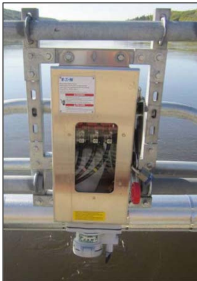
Figure 21 – Le lève-poutrelles est alimenté à partir des prises de 600V situées à intervalles le long de la rambarde sur le rebord en amont du tablier opérationnel du barrage. Le câble d'alimentation est branché au bas de ces prises.
