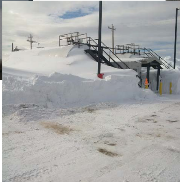
Bâtiment 371 Réservoirs de carburant
