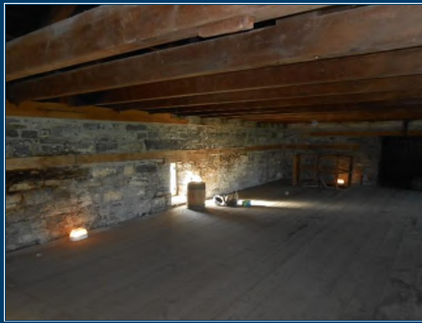
Photo 46: 2 e étage Plafond et structure de l'étage en bois Mortier de pierre au niveau des murs (TPSGC-LENNOX-MAG NORD-ETAGE-MORTIER PIERRE-1A, B, C, G, I) – ne contient pas d'amiante
