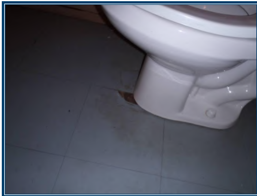
Photo 52: Rez-de-chaussée, toilette familiale Tuiles de vinyle bleu au plancher (TPSGC-LENNOX-CASERNE-TV-PL-2) – ne contiennent pas d’amiante
