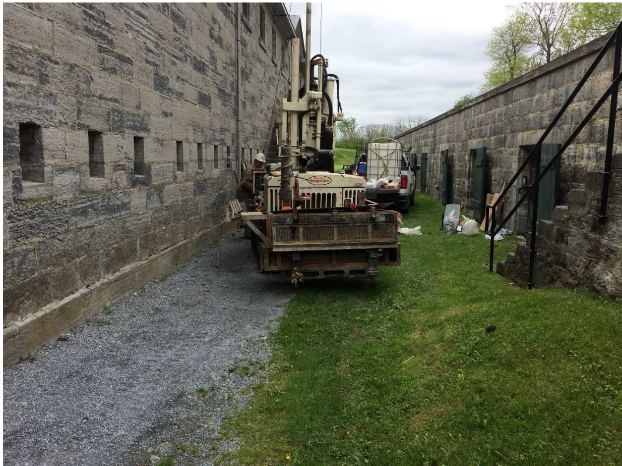
Figure 2.1 : Travaux de forage à l'emplacement du forage n° F-02, le 18 mai 2017
