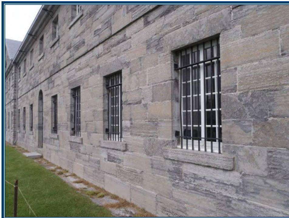
Photo 58: Vue de la façade avant de la caserne Mortier de pierre des murs (TPSGC-LENNOX-CASERNE-MUR-MORTIER INT-1A-I) – ne contient pas d’amiante
