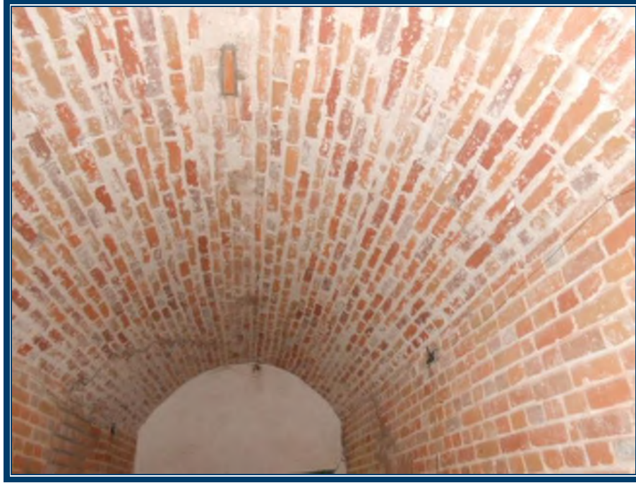
Photo 79: Murs et plafond en briques au rez-de-chaussée (arche), secteur prison Mortier de brique (TPSGC-LENNOX-CORPS-RDC-MORTIER-BRIQUE-1A-I) – ne contient pas d’amiante
