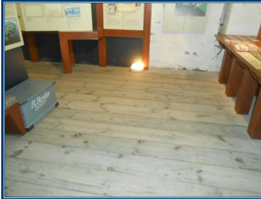
Photo 41: Rez-de-chaussée Plancher de bois
