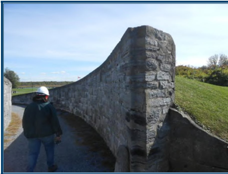
Photo 104: Vue générale du passage Redan Murs en pierres et mortier (TPSGC-LENNOX-PASSAGE REDAN-MORTIER-1A-I) – ne contient pas d’amiante
