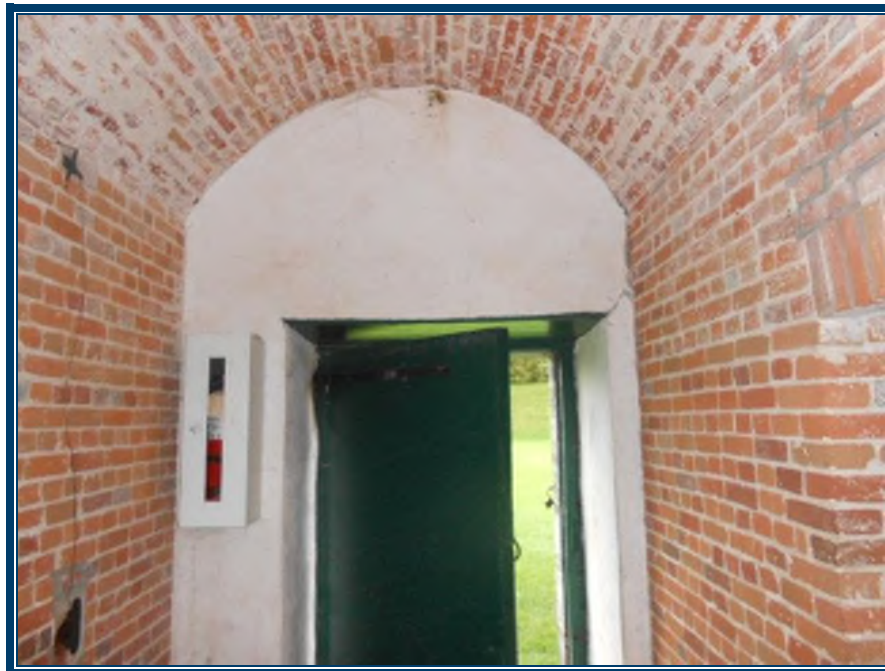
Photo 80: Murs en plâtre ciment sur briques au rez-de-chaussée, secteur prison Murs en plâtre ciment (TPSGC-LENNOX-CORPS-RDC-MUR-P/C-2G) – ne contiennent pas d’amiante Mortier de brique (TPSGC-LENNOX-CORPS-RDC-MORTIER-BRIQUE-1A-I) – ne contient pas d’amiante
