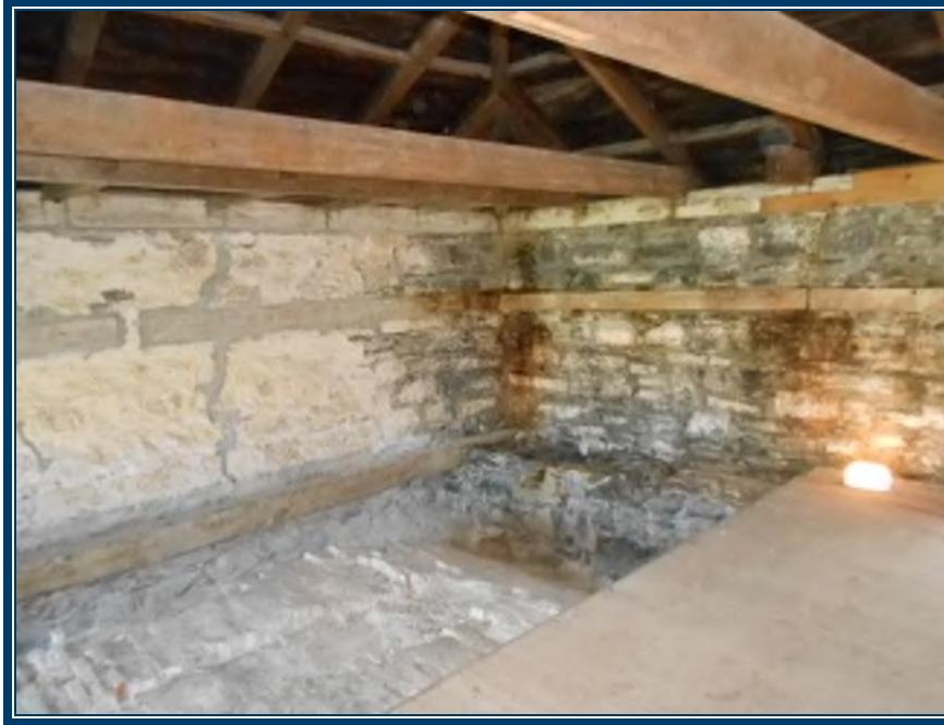
Photo 45: 2 e étage Plafond et structure de l'étage en bois Mortier de brique correspondant aux arches du rez-de-chaussée (TPSGC-LENNOX-MAG NORD-RDC-MORTIER BRIQUE-2E, F, G, H, I) – ne contient pas d'amiante Mortier de pierre au niveau des murs (TPSGC-LENNOX-MAG NORD-ETAGE-MORTIER PIERRE-1A, B, C, G, I) – ne contient pas d'amiante
