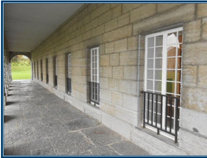
Photo 30: Vue de la façade avant du logis des officiers Mur en pierre et mortier (TPSGC-LENNOX-OFFICIERS-MUR-MORTIER-4A-I) – ne contient pas d’amiante
