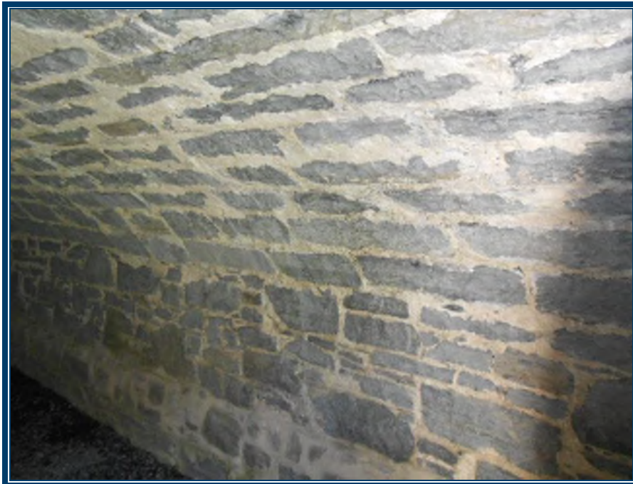
Photo 4: Murs et plafond (arche) des casemates (sauf cuisines) en pierre et mortier Mortier de pierre intérieur (TPSGC-LENNOX-CASEMATES N-MORTIER PIERRE INT-1A-I) – ne contient pas d’amiante
