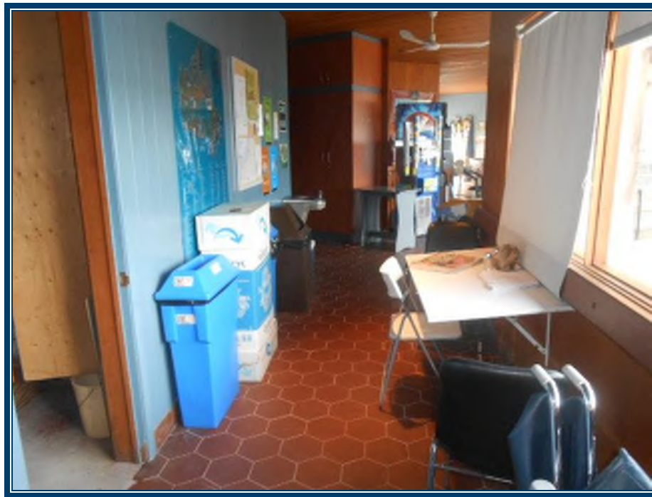
Photo 122: Vue de l'aire générale Murs en lattes de bois, dont certains sont peints bleu Plancher de céramique Plafond en lattes de bois
