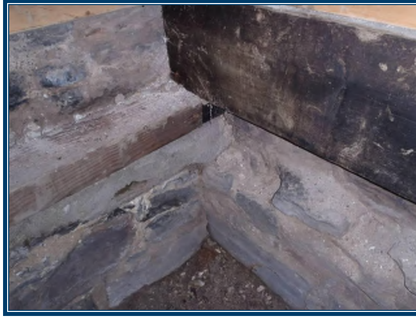
Photo 53: Vide sanitaire de la caserne Mortier de pierre (TPSGC-LENNOX-CASERNE-MUR-MORTIER INT-1A-I) – ne contient pas d’amiante
