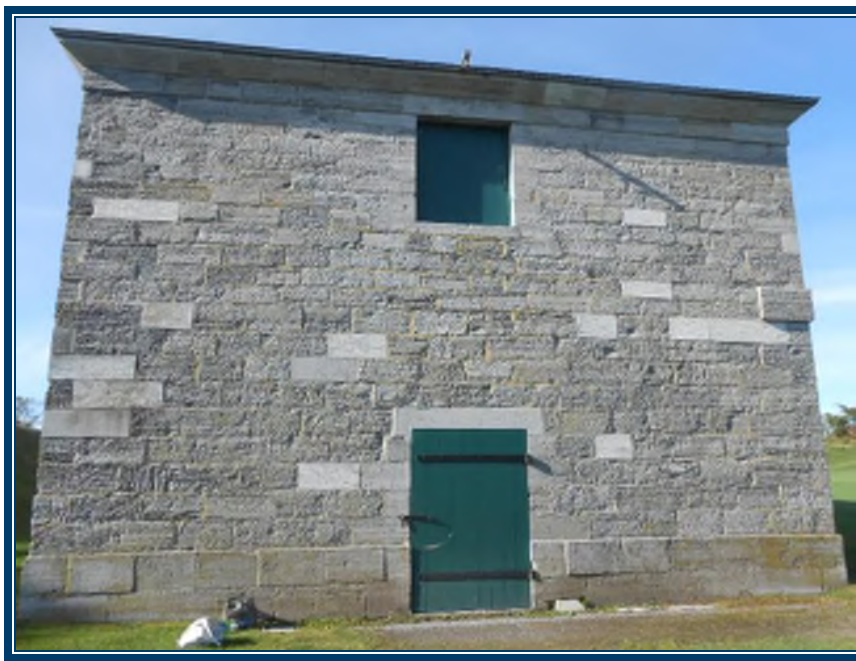
Photo 32: Vue générale de l’extérieur du bâtiment Mortier entre les pierres carrées (TPSGC-LENNOX-MAG SUD-EXT-MORTIER-2A-I) – ne contient pas d’amiante Peinture verte sur les portes du bâtiment et volets
