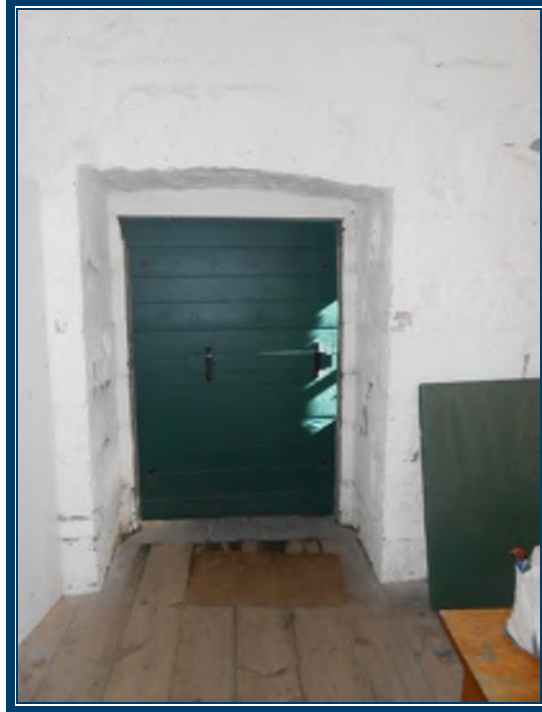
Photo 35: Rez-de-chaussée Murs au rez-de-chaussée en pierre recouvertes de plâtre ciment Plâtre ciment (TPSGC-LENNOX-MAG SUD-RDC-P/C-1A-I) – ne contient pas d’amiante Peinture verte sur la porte d’entrée du bâtiment
