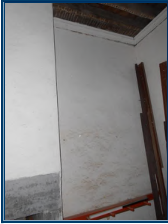
Photo 75: Murs en plâtre ciment sur briques dans le local 103 Murs en plâtre ciment (TPSGC-LENNOX-CORPS-RDC-MUR-P/C-2G) – ne contiennent pas d’amiante Mortier de brique (TPSGC-LENNOX-CORPS-RDC-MORTIER-BRIQUE-1A-I) – ne contient pas d’amiante
