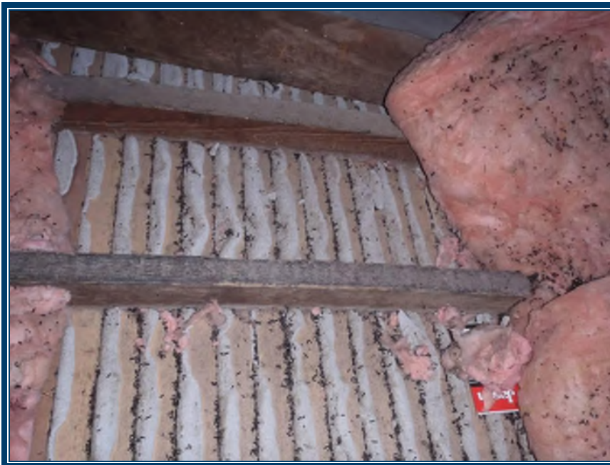
Photo 62: Grenier, vue du plafond de l'étage en plâtre ciment sur lattes de bois (TPSGC-LENNOX-CASERNE-ETAGE-PF-P/C-6A) – ne contient pas d'amiante Laine de verre au plancher du grenier – n'est pas susceptible de contenir de l'amiante
