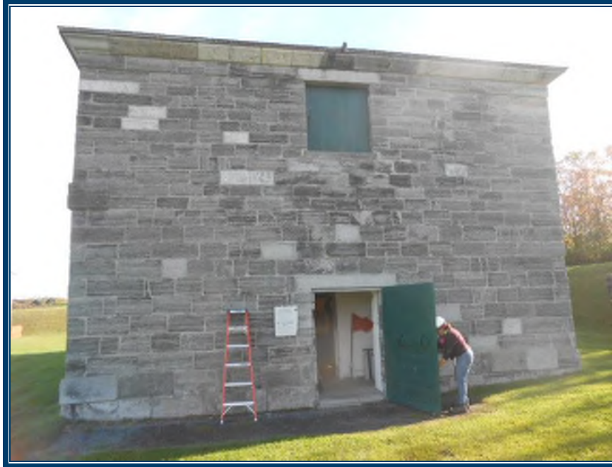
Photo 49: Vue générale de l'extérieur du bâtiment Mortier entre les pierres carrées (TPSGC-LENNOX-MAG NORD-EXT-MORTIER-5A-I) – ne contient pas d'amiante Peinture verte sur les portes du bâtiment et volets
