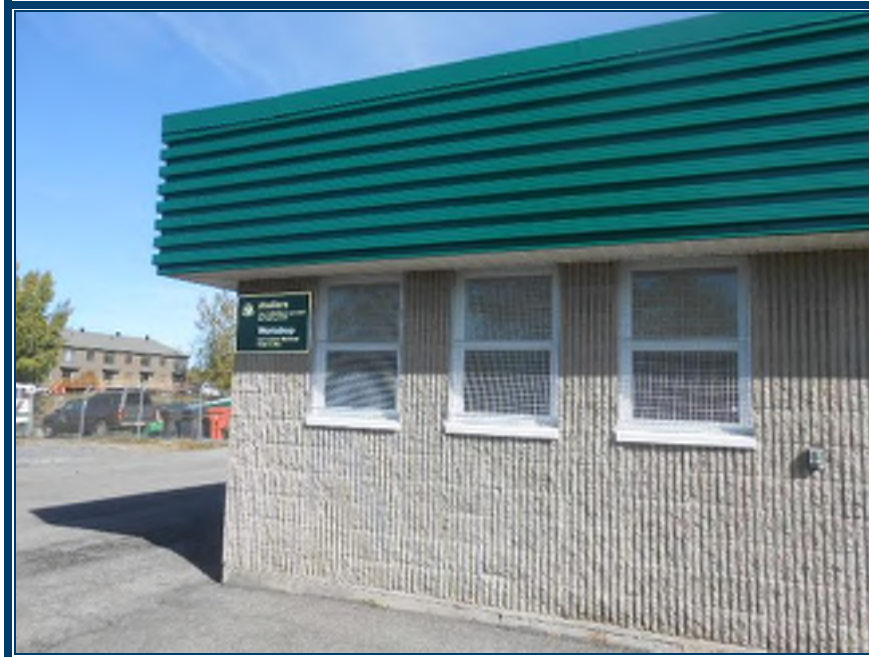
Photo 111: Vue de l'extérieur du bâtiment Murs en blocs nervurés Revêtement en aluminium au niveau de la retombée
