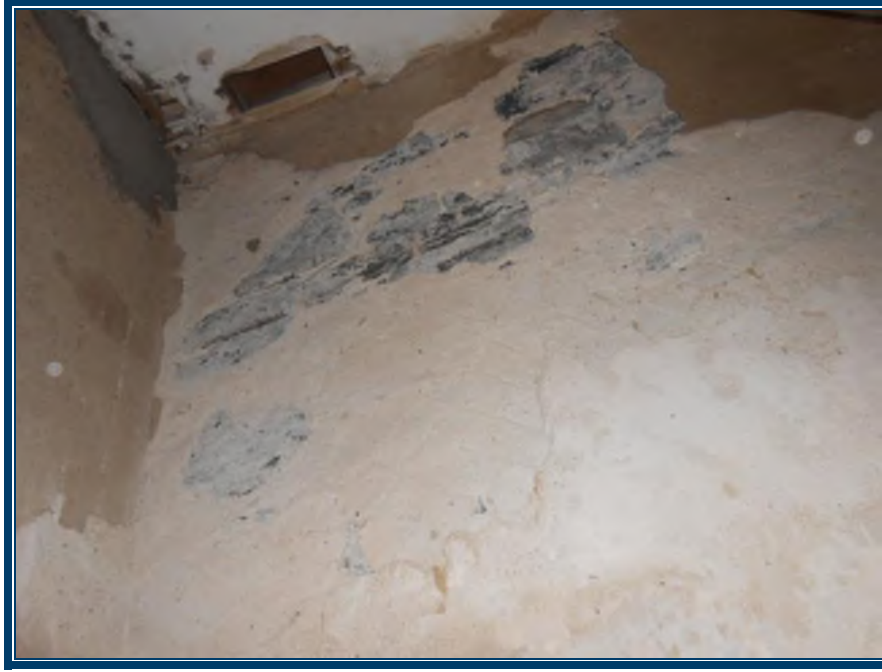
Photo 83: Murs et plafond en plâtre ciment au rez-de-chaussée, local 104 Plâtre ciment (TPSGC-LENNOX-CORPS-RDC-MUR-P/C-2G) – ne contient pas d’amiante Mortier de brique (TPSGC-LENNOX-CORPS-RDC-MORTIER-BRIQUE-1A-I) – ne contient pas d’amiante
