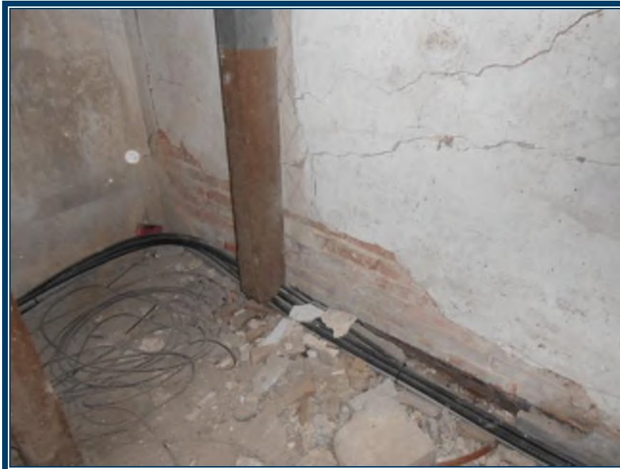
Photo 84: Murs en plâtre ciment au rez-de-chaussée, local 104 Plâtre ciment (TPSGC-LENNOX-CORPS-RDC-MUR-P/C-2G) – ne contient pas d’amiante Mortier de brique (TPSGC-LENNOX-CORPS-RDC-MORTIER-BRIQUE-1A-I) – ne contient pas d’amiante
