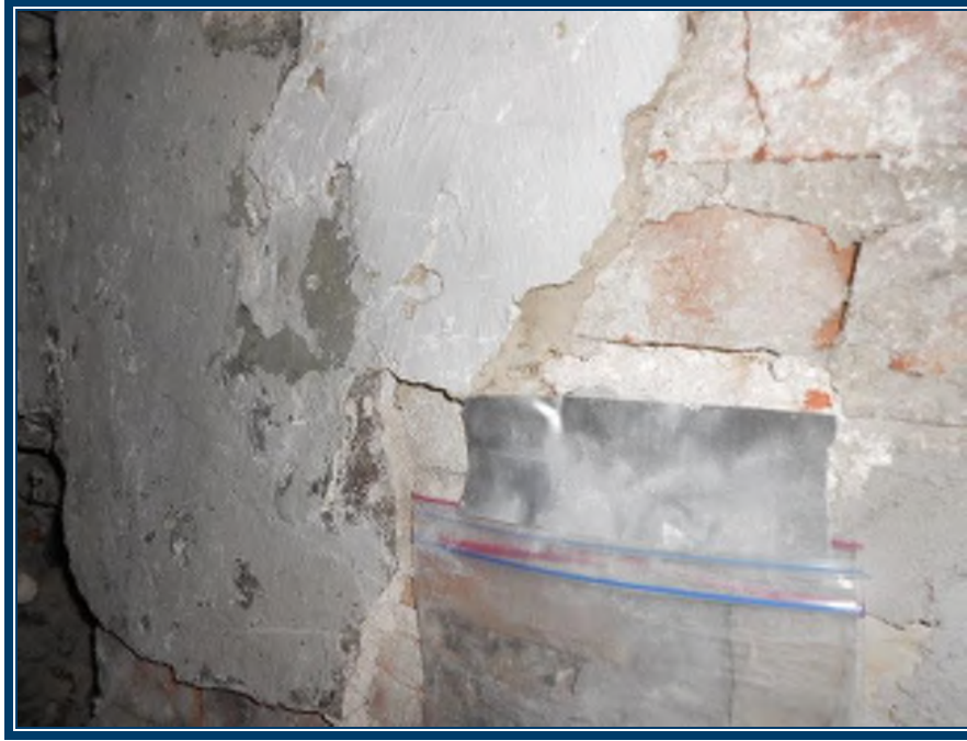
Photo 17: Étage, armoire près de la cheminée Mortier de brique (TPSGC-LENNOX-OFFICIERS-MUR-MORTIER BRIQUE-2A-I) – ne contient pas d’amiante
