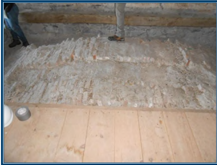
Photo 47: 2 e étage Plancher de bois Mortier de brique correspondant aux arches du rez-de-chaussée (TPSGC-LENNOX-MAG NORD-RDC- MORTIER BRIQUE-2E, F, G, H, I) – ne contient pas d’amiante
