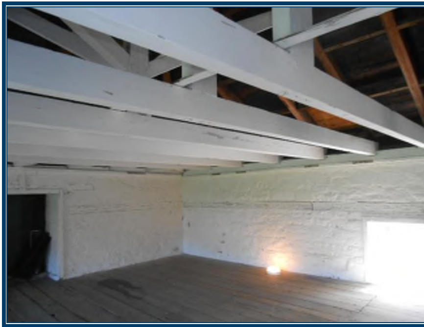
Photo 38: Étage Plâtre ciment appliqué sur pierre au niveau des murs Plâtre ciment (TPSGC-LENNOX-MAG SUD-ETAGE-P/C-3A-I) – ne contient pas d’amiante Mortier de pierre (réf. TPSGC-LENNOX-MAG NORD-EXT-MORTIER-5A-I) – ne contient pas d’amiante Plancher de bois Structure du plafond en bois
