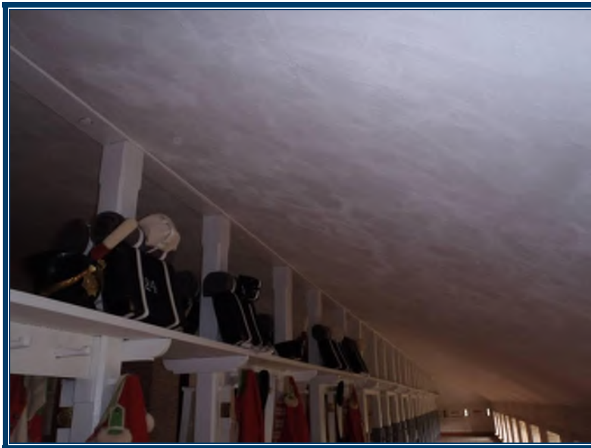
Photo 64: Étage, plafond en plâtre ciment sur lattes de bois (TPSGC-LENNOX-CASERNE-ETAGE-PF-P/C-6A-I) – ne contient pas d’amiante
