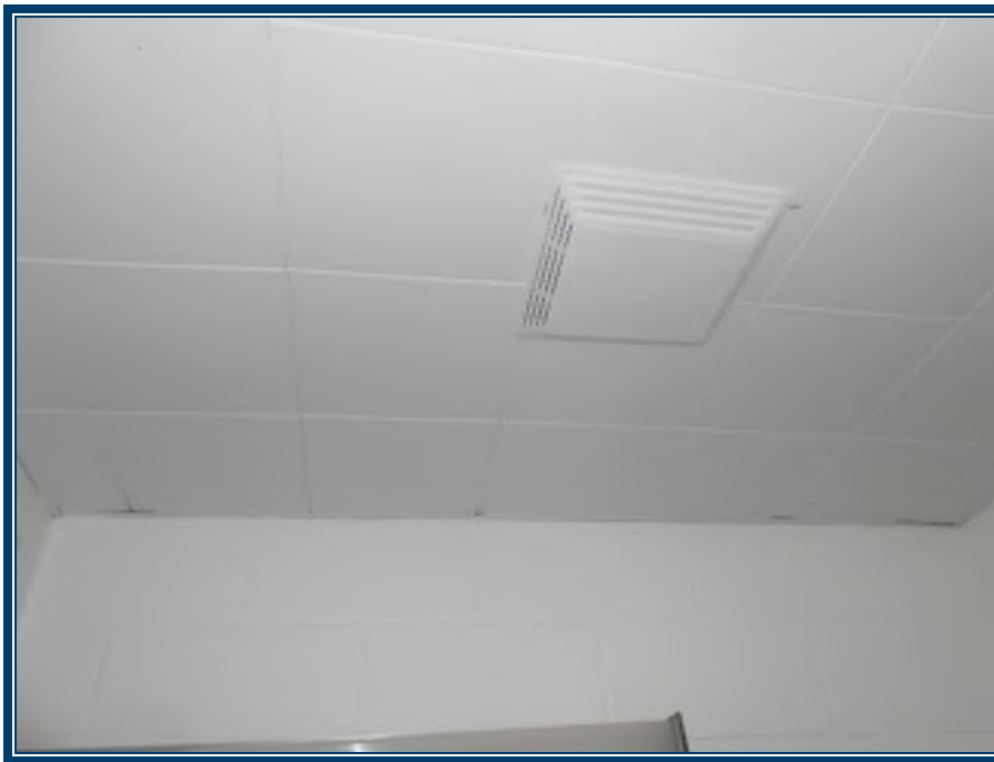
Photo 116: Toilett Tuiles acoustiques lisses collées au plafond (TPSGC-LENNOX-GARAGE AT-SDB-PF-TA-2) – ne contiennent pas d’amiante
