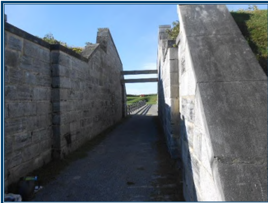
Photo 102: Vue générale du passage Sud
