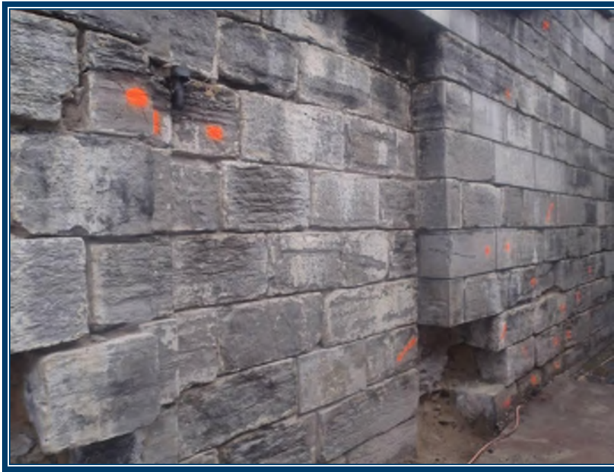
Photo 98: Vue des pierres naturelles carrées et du mortier extérieur gris présent au niveau des murs du passage et de la porte Nord Mortier extérieur gris (TPSGC-LENNOX-PORTE N-MUR-MORTIER-2A-I) – ne contient pas d'amiante
