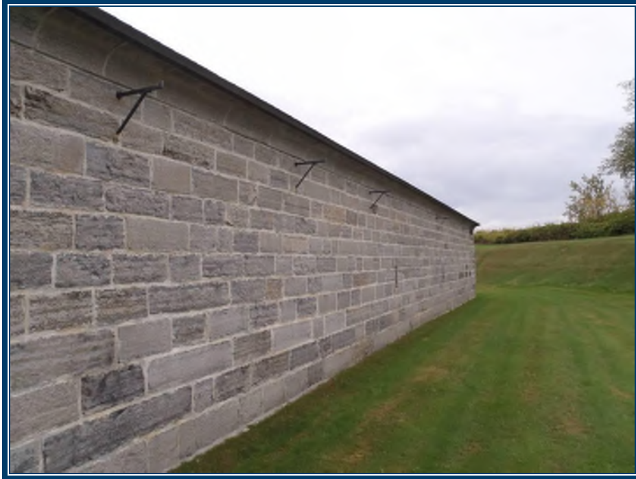
Photo 97: Vue de l'arrière du bâtiment Joints de mortier des murs extérieurs en pierre (TPSGC-LENNOX-POUDRIERE-MUR-MORTIER PIERRE-2A-I) – ne contient pas d'amiante
