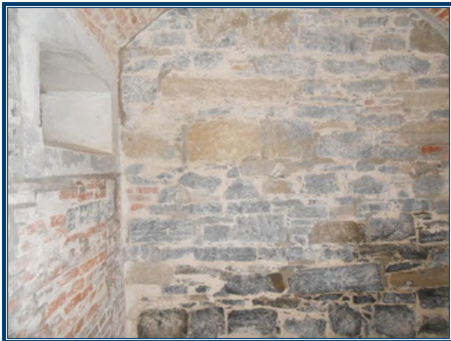
Photo 78 : Murs en briques et pierres au rez-de-chaussée, secteur prison Mortier de brique (TPSGC-LENNOX-CORPS-RDC-MORTIER-BRIQUE-1A-I) – ne contient pas d’amiante Mortier de pierre (TPSGC-LENNOX-CORPS-EXT-MORTIER-5A-I) - ne contient pas d’amiante
