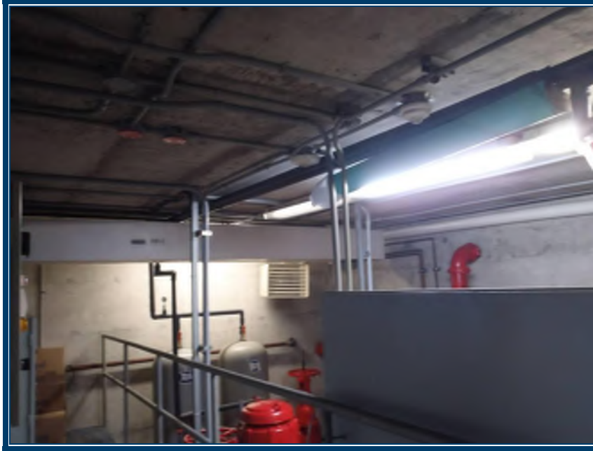
Photo 9: Salle électrique, vue générale de l'intérieur Plafond et murs en béton Tuyauterie non isolée ou isolée avec de la laine de verre/armaflex
