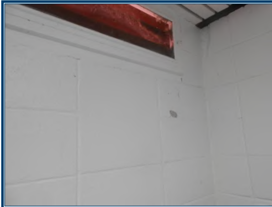
Photo 108: Murs de la toilette des femmes en blocs de béton et plafond en lattes métalliques Murs peints en blanc
