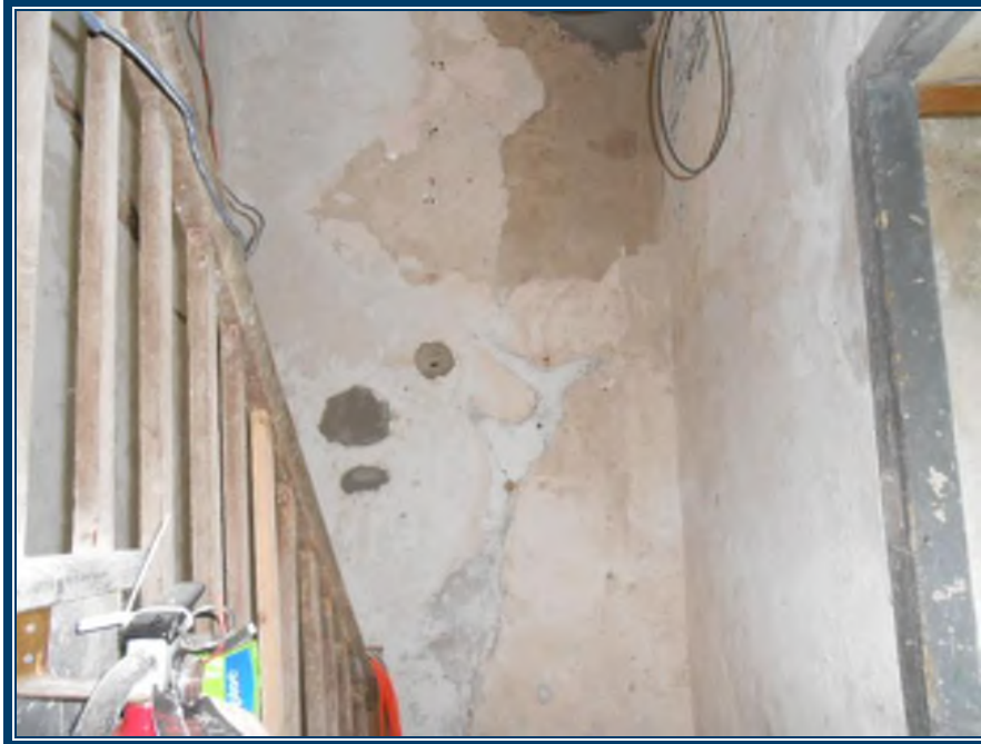
Photo 85: Murs en plâtre ciment au rez-de-chaussée, local 104 Plâtre ciment (TPSGC-LENNOX-CORPS-RDC-MUR-P/C-2G) – ne contient pas d’amiante Mortier de brique (TPSGC-LENNOX-CORPS-RDC-MORTIER-BRIQUE-1A-I) – ne contient pas d’amiante
