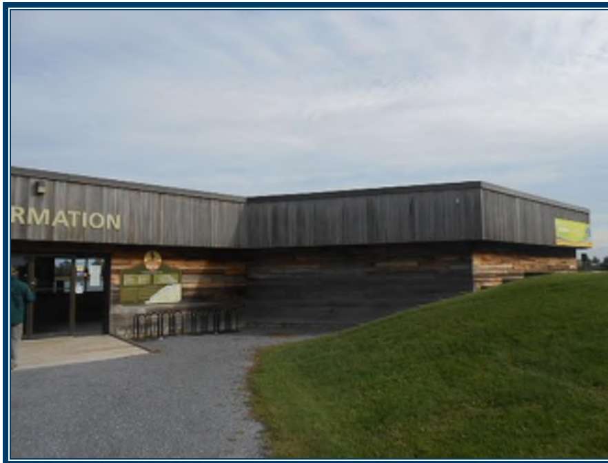
Photo 118: Vue générale de l'extérieur du bâtiment Les murs extérieurs sont tous composés de bois
