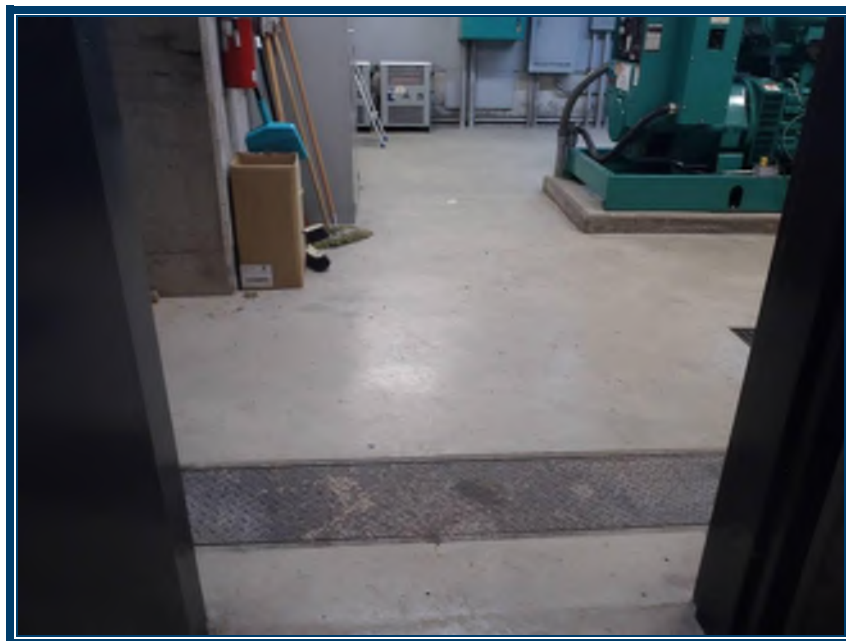
Photo 10: Salle électrique Plancher de béton
