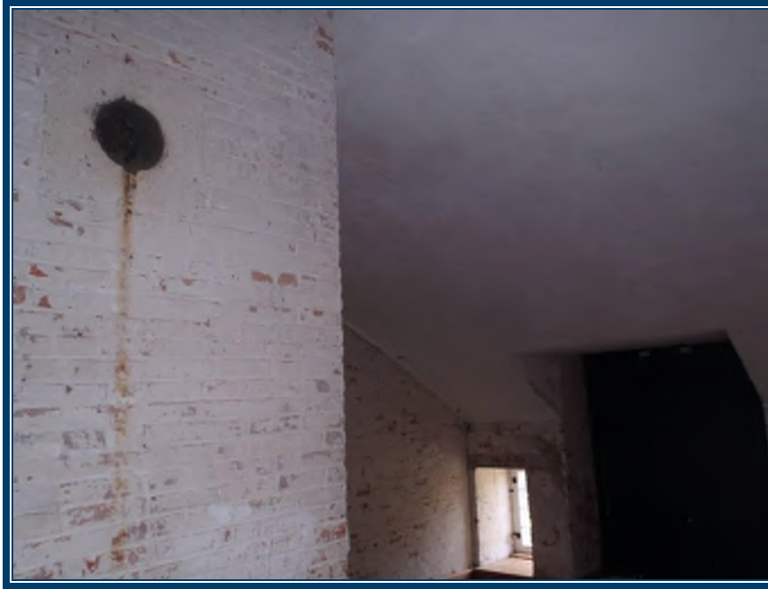
Photo 67: Étage, plafond en plâtre ciment sur lattes de bois dans le local 204 (TPSGC-LENNOX-CASERNE-ETAGE-PF-P/C-6A-I) – ne contient pas d’amiante Mortier de brique (TPSGC-LENNOX-CASERNE-RDC-MORTIER-BRIQUE-MUR-4E-I) – contient 0,1-1% d’amiante de type chrysotile dans la phase composé à joints
