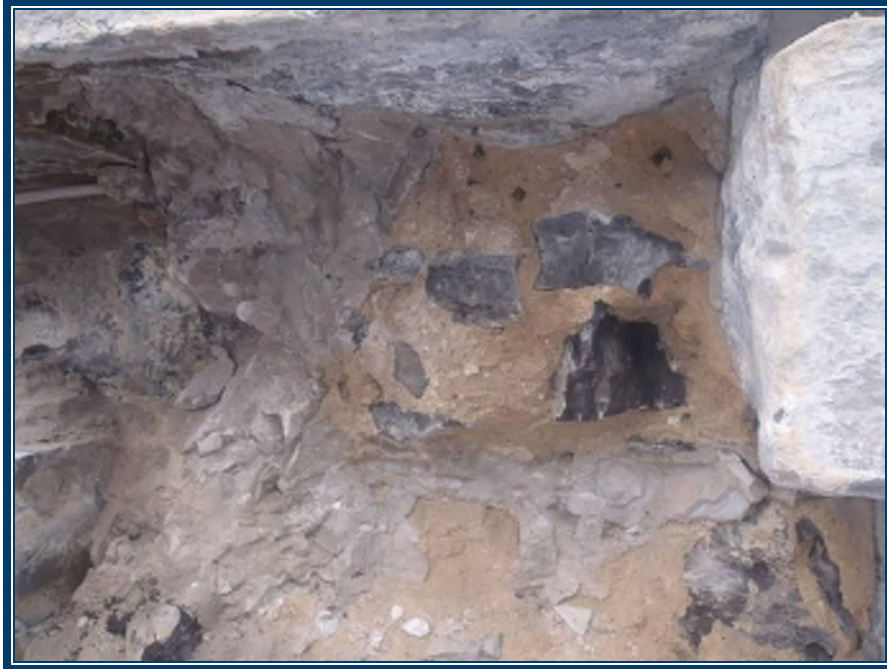
Photo 99: Mortier intérieur beige présent au niveau des murs du passage et de la porte Nord Mortier intérieur beige (TPSGC-LENNOX-PORTE N-MUR-MORTIER-1A-I) – ne contient pas d’amiante
