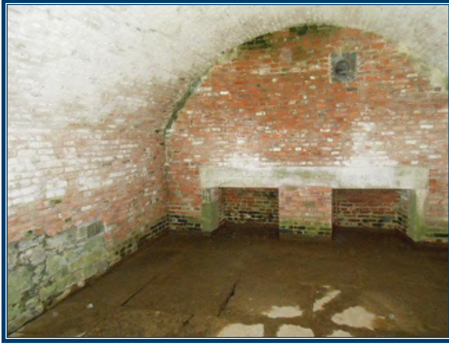
Photo 3: Murs et plafonds (arche) en briques et mortier dans le secteur des cuisines Mortier de brique (TPSGC-LENNOX-CASEMATES N-MORTIER CUISINE-3A-I) – ne contient pas d’amiante
