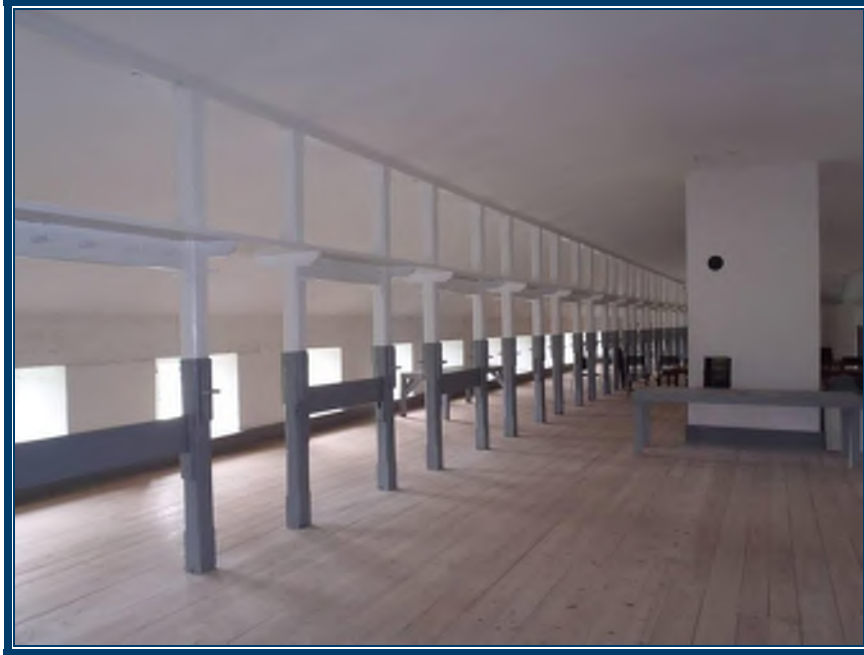
Photo 69: Étage, plafond en plâtre ciment sur lattes de bois (TPSGC-LENNOX-CASERNE-ETAGE-PF-P/C-6A-I) – ne contient pas d’amiante Mortier de brique des murs (TPSGC-LENNOX-CASERNE-RDC-MORTIER-BRIQUE-MUR-4E-I) – contient 0,1-1% d’amiante de type chrysotile dans la phase composé à joints Plâtre ciment sur les murs (TPSGC-LENNOX-CASERNE-ETAGE-MUR-P/C-7A-I) – ne contient pas d’amiante
