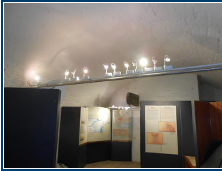
Photo 39: Rez-de-chaussée Murs et plafond (arche) en brique et plâtre ciment Mortier de brique (TPSGC-LENNOX-MAG NORD-RDC-MORTIER BRIQUE-2A, B, C, D) – ne contient pas d’amiante Peinture blanche au niveau des murs et du plafond
