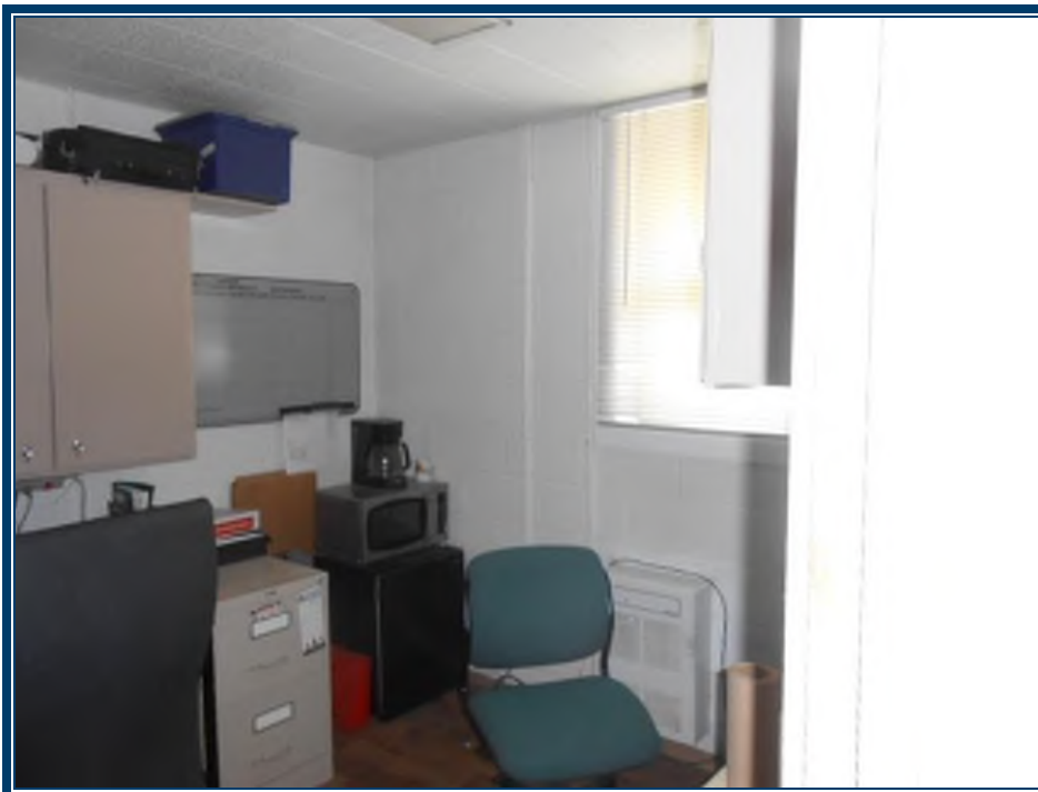
Photo 114: Salle de repos/bureau Murs en blocs de béton peints blancs et armoires peintes beige Tuiles acoustiques perforées collées au plafond (TPSGC-LENNOX-GARAGE AT-BUREAU-PF-TA-3) – ne contiennent pas d'amiante
