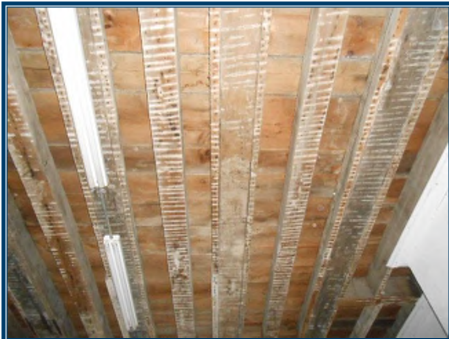
Photo 76: Plafond du local 103 en bois
