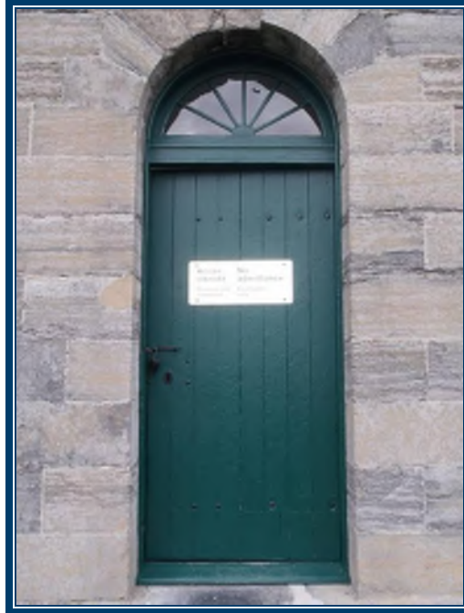
Photo 57: Portes extérieures du bâtiment peint en vert Mortier de pierre des murs (TPSGC-LENNOX-CASERNE-MUR-MORTIER INT-1A-I) – ne contient pas d’amiante
