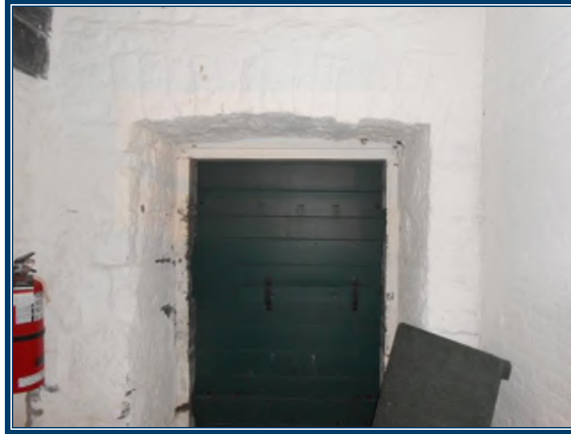
Photo 43: Rez-de-chaussée, vestibule d'entrée Mortier de brique (TPSGC-LENNOX-MAG NORD-RDC-MORTIER BRIQUE-2A, B, C, D) – ne contient pas d'amiante Mortier de pierre (TPSGC-LENNOX-MAG NORD-RDC-MORTIER PIERRE-1D, E, F, H) – ne contient pas d'amiante Plâtre ciment (TPSGC-LENNOX-MAG NORD-RDC-P/C-3A-I) – ne contient pas d'amiante Peinture verte sur la porte d'entrée du bâtiment
