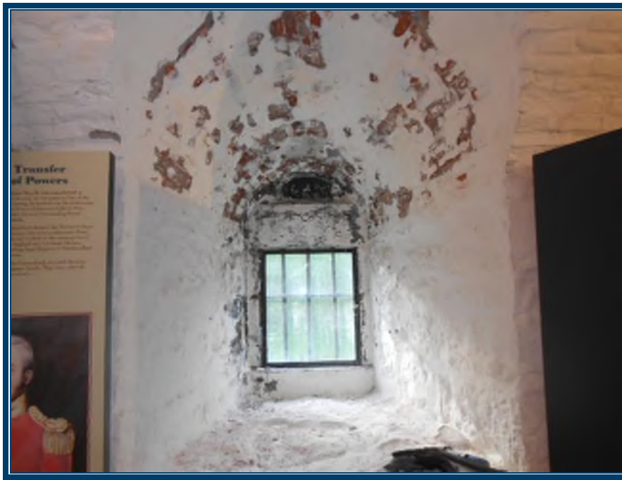
Photo 42: Rez-de-chaussée Mortier de brique (TPSGC-LENNOX-MAG NORD-RDC-MORTIER BRIQUE-2A, B, C, D) – ne contient pas d’amiante Mortier de pierre (TPSGC-LENNOX-MAG NORD-RDC-MORTIER PIERRE-1D, E, F, H) – ne contient pas d’amiante Plâtre ciment (TPSGC-LENNOX-MAG NORD-RDC-P/C-3A-I) – ne contient pas d’amiante
