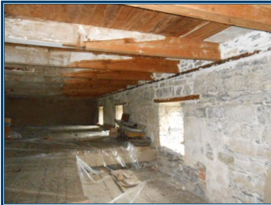
Photo 86: Étage Mortier de pierre (TPSGC-LENNOX-CORPS-EXT-MORTIER-5A-I) - ne contient pas d’amiante Plancher de bois, structure du plafond en bois
