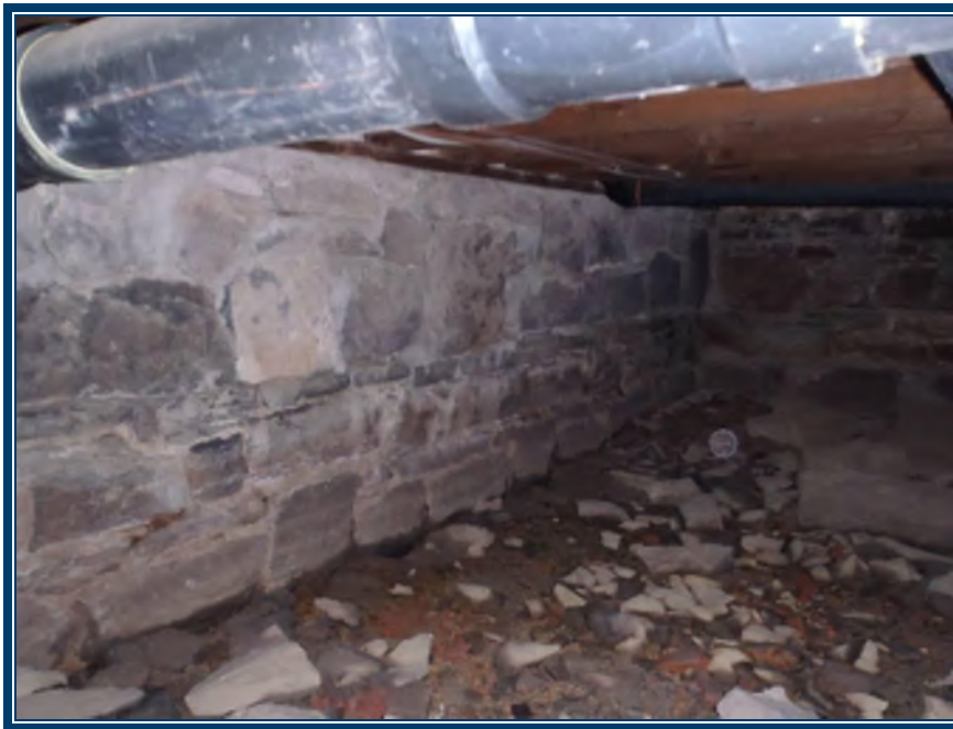
Photo 50: Vide sanitaire de la caserne Mortier de pierre (TPSGC-LENNOX-CASERNE-MUR-MORTIER INT-1A-I) – ne contient pas d'amiante
