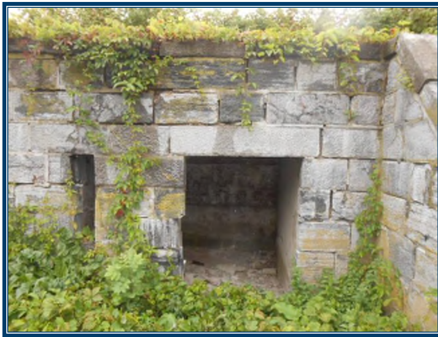
Photo 106: Vue extérieure des latrines Murs en pierres carrées et mortier (TPSGC-LENNOX-LATRINES-MORTIER EXT-1A) – ne contient pas d’amiante
