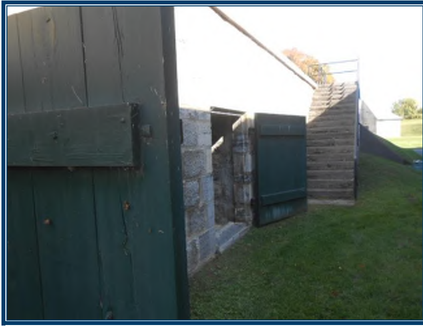
Photo 5: Vue extérieure des casemates Ouest Peinture verte sur les portes Murs extérieurs en pierres carrées et mortier (TPSGC-LENNOX-CASEMATES O-MORTIER EXT-2A-I) – ne contient pas d'amiante
