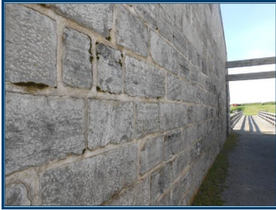
Photo 103: Vue des murs en pierre du passage Sud Mortier gris entre les pierres carrées (TPSGC-LENNOX-PORTE S-MUR-MORTIER-1A-I) – ne contient pas d’amiante
