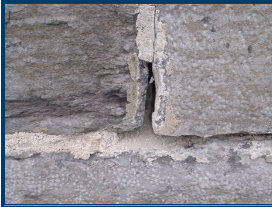
Photo 96: Joints de mortier des murs extérieurs en pierre (TPSGC-LENNOX-POUDRIERE-MUR-MORTIER PIERRE-2A-I) – ne contient pas d'amiante
