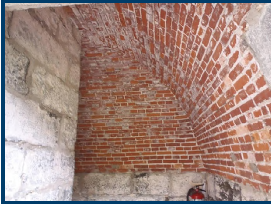
Photo 93: Entrée de la poudrière Murs en pierre et mortier (TPSGC-LENNOX-POUDRIERE-MUR-MORTIER PIERRE-2A-I) – ne contient pas d’amiante Murs en briques et mortier (TPSGC-LENNOX-POUDRIERE-MUR-MORTIER BRIQUE-1A-I) – ne contient pas d’amiante
