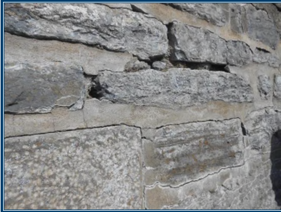
Photo 105: Mur en pierres et mortier (TPSGC-LENNOX-PASSAGE REDAN-MORTIER-1A-I) – ne contient pas d’amiante
