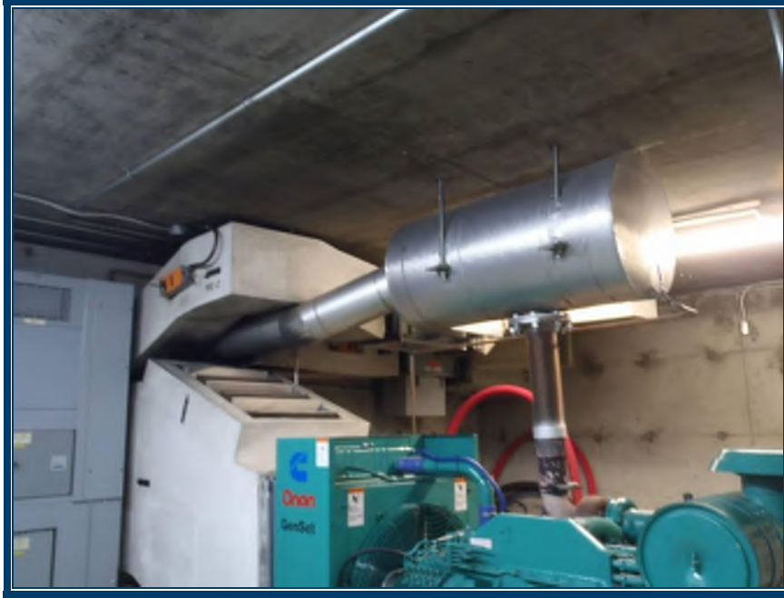
Photo 11: Salle électrique Plafond et murs en béton Conduits de ventilation isolés en laine de verre Conduit d'évacuation de la génératrice et réservoir – impossible de vérifier les matériaux (semble récent)
