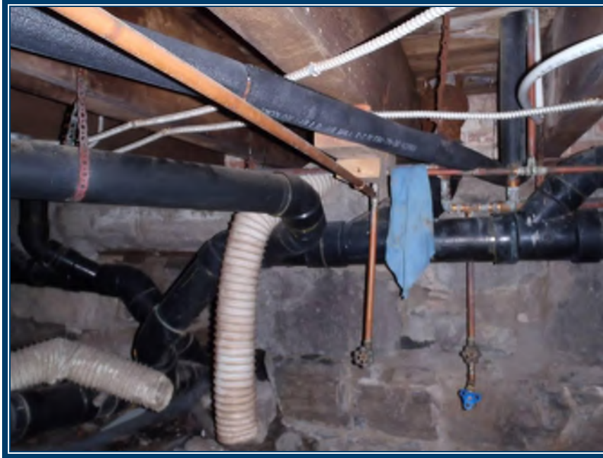
Photo 51: Vide sanitaire de la caserne Mortier de pierre (TPSGC-LENNOX-CASERNE-MUR-MORTIER INT-1A-I) – ne contient pas d’amiante Tuyauterie non isolée
