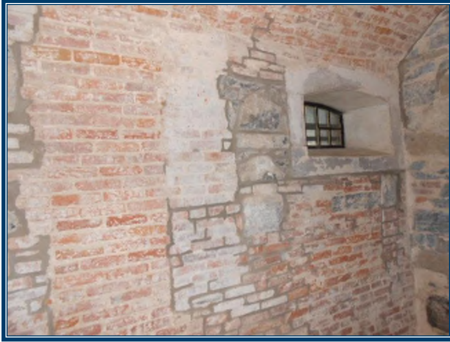
Photo 77: Murs en briques au rez-de-chaussée, secteur prison Mortier de brique (TPSGC-LENNOX-CORPS-RDC-MORTIER-BRIQUE-1A-I) – ne contient pas d’amiante
