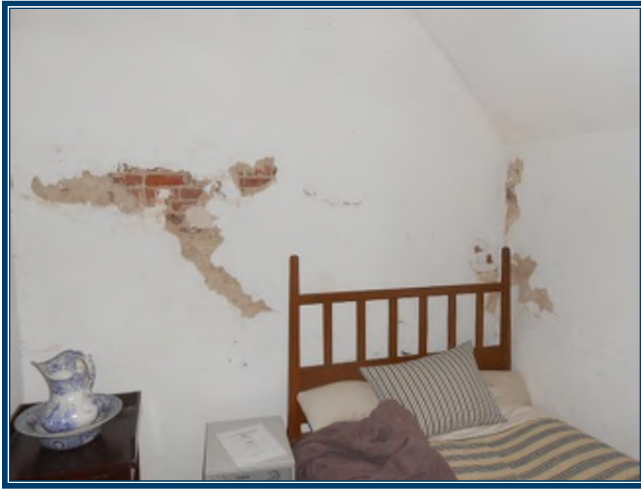
Photo 71: Murs en plâtre ciment sur briques au rez-de-chaussée Murs en plâtre ciment (TPSGC-LENNOX-CORPS-RDC-MUR-P/C-2G) – ne contiennent pas d’amiante Mortier de brique (TPSGC-LENNOX-CORPS-RDC-MORTIER-BRIQUE-1A-I) – ne contient pas d’amiante
