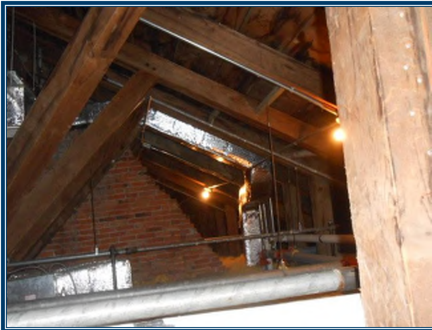
Photo 20: Grenier du bâtiment Structure et plafond en bois Tuyauterie non isolée Conduits de ventilation isolés en laine de verre Cheminée en brique et mortier (TPSGC-LENNOX-OFFICIERS-MUR-MORTIER BRIQUE-2A-I) – ne contient pas d'amiante
