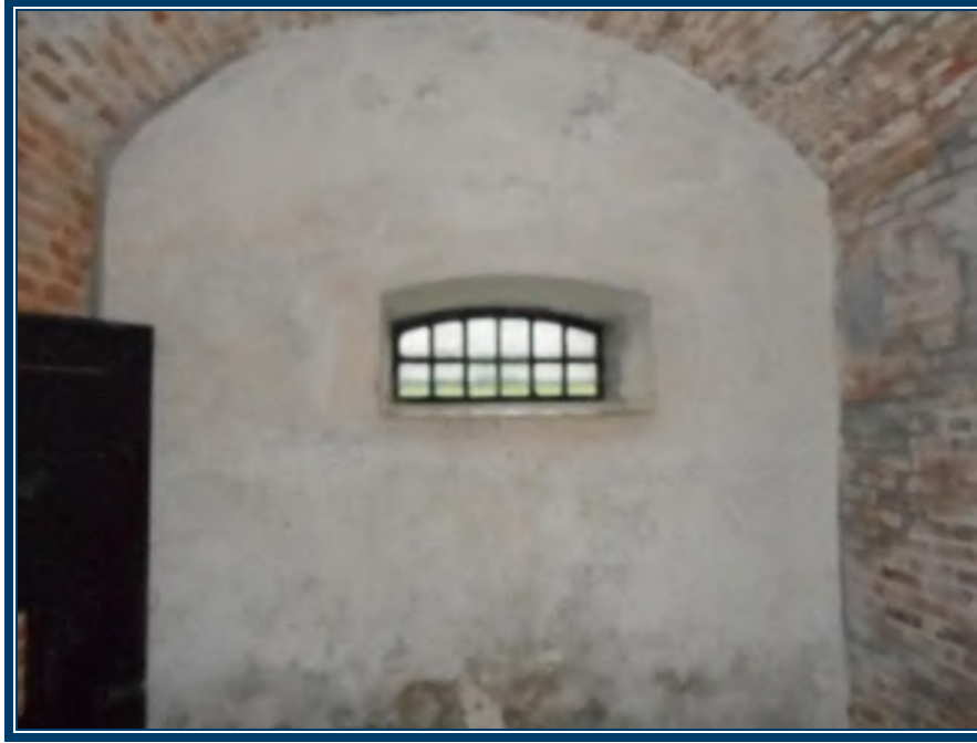
Photo 81: Murs en plâtre ciment sur briques au rez-de-chaussée, secteur prison Murs en plâtre ciment (TPSGC-LENNOX-CORPS-RDC-MUR-P/C-2G) – ne contiennent pas d’amiante Mortier de brique (TPSGC-LENNOX-CORPS-RDC-MORTIER-BRIQUE-1A-I) – ne contient pas d’amiante
