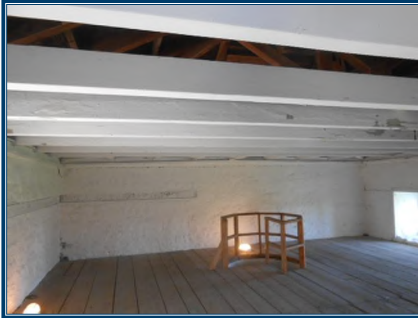
Photo 37: Étage Plâtre ciment appliqué sur pierre au niveau des murs Plâtre ciment (TPSGC-LENNOX-MAG SUD-ETAGE-P/C-3A-I) – ne contient pas d’amiante Mortier de pierre (réf. TPSGC-LENNOX-MAG NORD-EXT-MORTIER-5A-I) – ne contient pas d’amiante Plancher de bois Structure du plafond en bois
