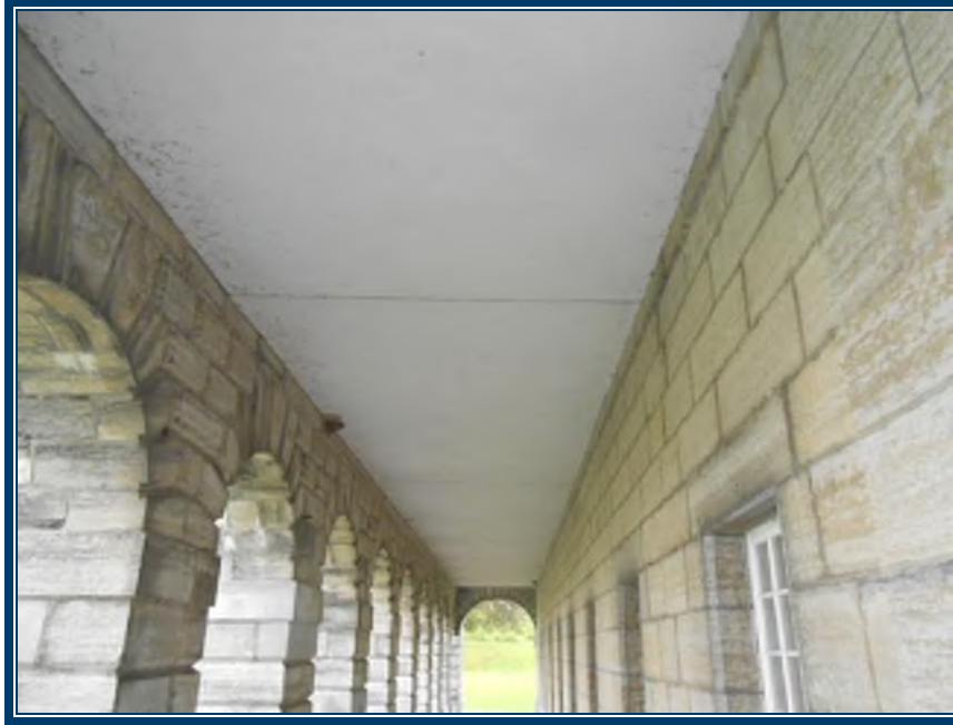
Photo 31: Extérieur Plafond en panneaux préfabriqués (TPSGC-LENNOX-OFFICIERS-EXT-PANNEAU PREFAB-10) – ne contient pas d’amiante
