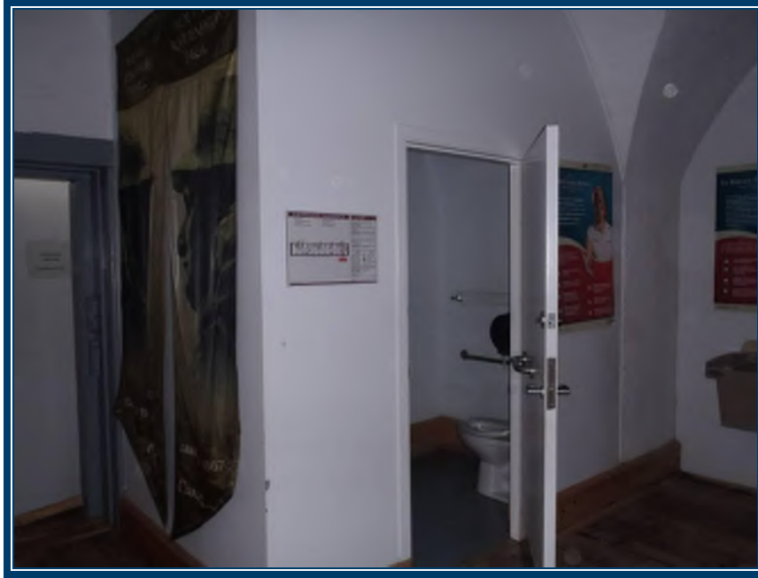
Photo 61: Rez-de-chaussée, toilette familiale Murs de division en panneaux de gypse (TPSGC-LENNOX-CASERNE-RDC-MUR-CJ+G-5) - ne contiennent pas d'amiante
