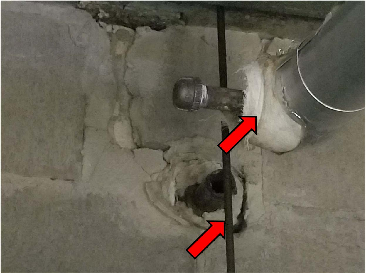
**Photographie 2:** Isolant sur les raccords de tuyauterie avec composé à base de ciment friable de couleur grise (mauvais état) illustré dans la pièce 064. Les analyses historiques de laboratoire ont confirmé que ce matériau renferme de 50 à >75 % d'amiante chrysotile (échantillons historiques prélevés par Oakhill portant les identifications M23A-02A et M23A-08A).
