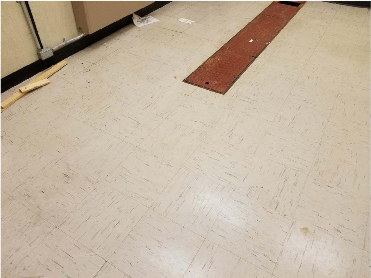
**Photographie 3:** Il a été confirmé que les carreaux de sol en vinyle de 12 po X12 po, de couleur blanc cassé avec rayures brunes, illustrés dans la pièce 064, renferment 2 % d'amiante chrysotile (échantillon de DST portant l'identification 31268-M23A-01A-C).
