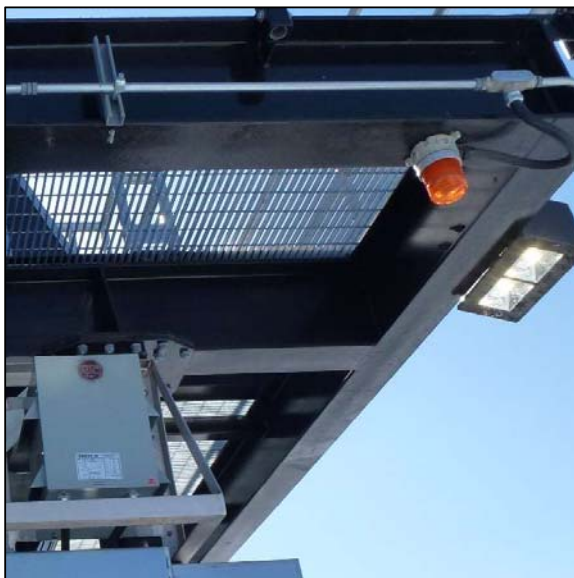
Figure 5 : Semelle inférieure de la poutre à laquelle les rails doivent être fixés.
