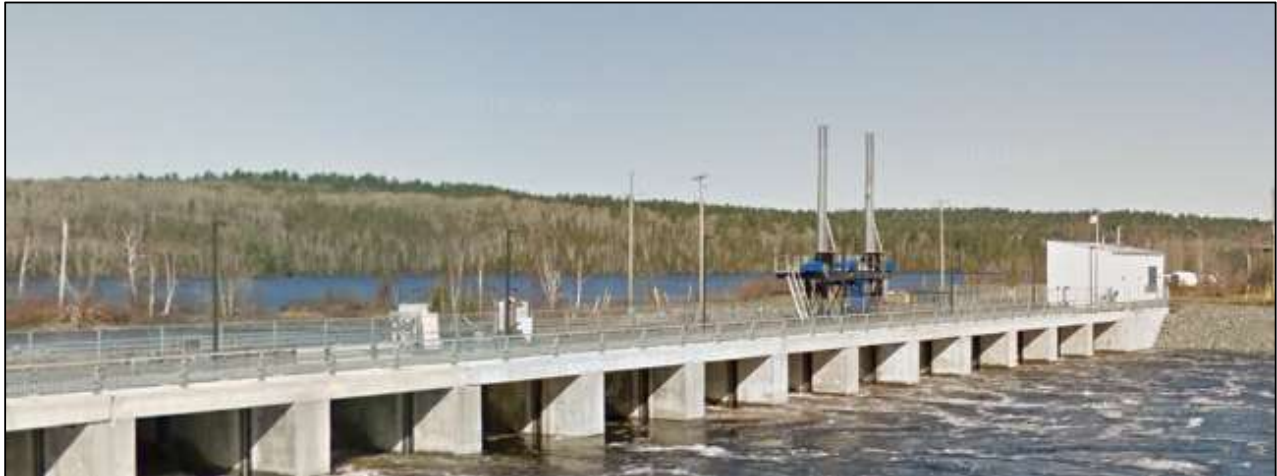
Figure 2 : Lève-poutrelle sur le barrage Latchford. Image de Google Street View.
