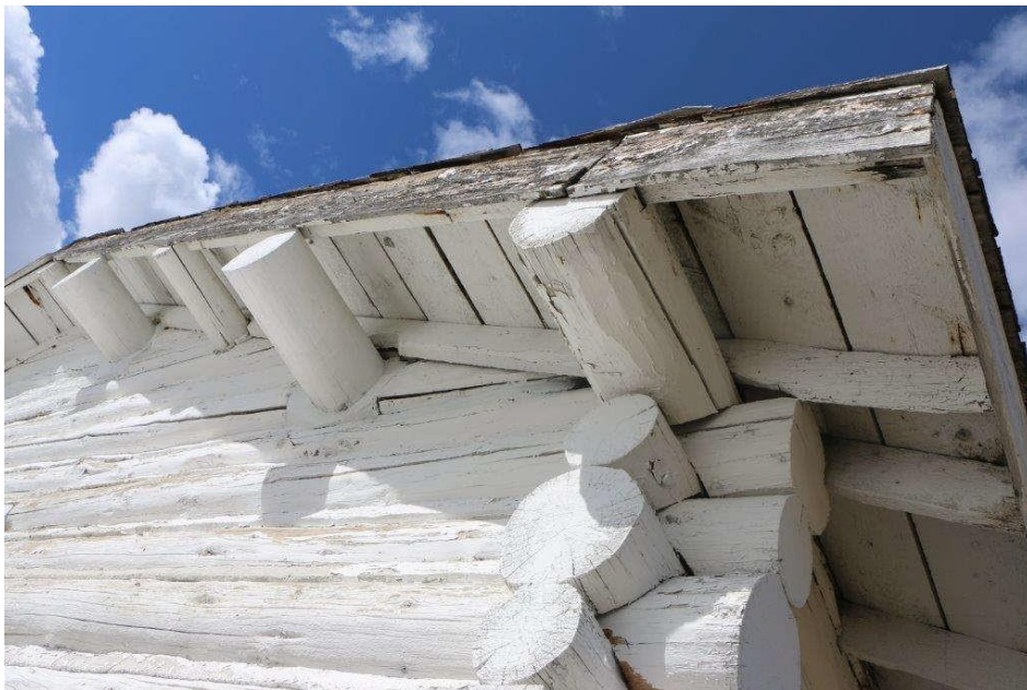
Écurie - Élévations extérieures et gros plan des soffites/fascia à l'extrémité du pignon. (mars 2019)
