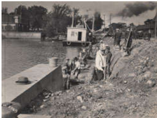
Photo 1 : Ouvriers travaillant à la réfection d'un quai, 1931 (archives nationales / PA-085845)
