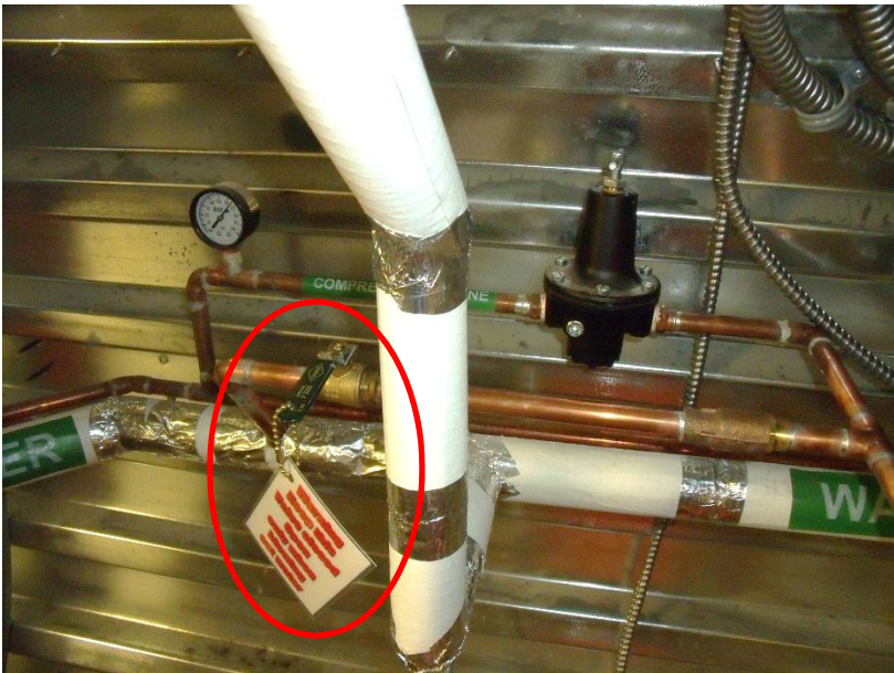
Robinet de la canalisation d'air raccordant la canalisation d'air à la canalisation d'eau
