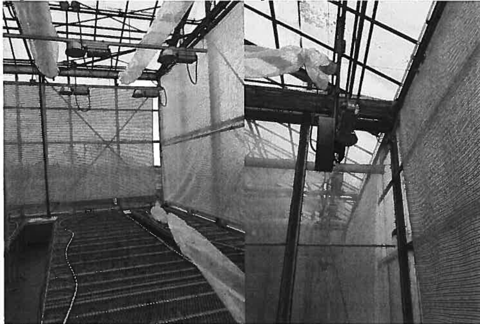
Vue de l'intérieur, vers le sud
