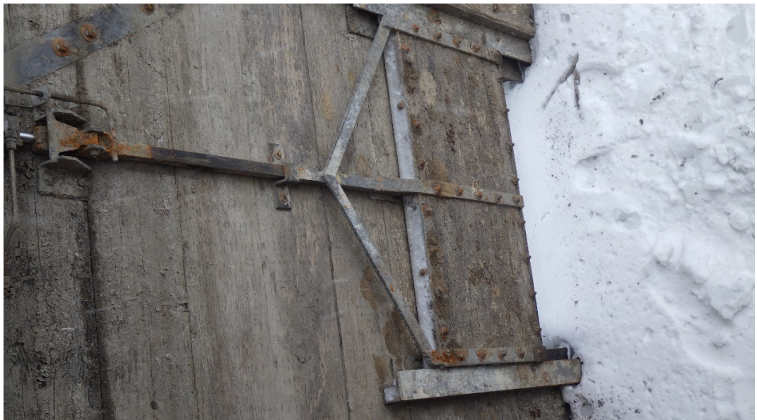
Photo n° 14 Porte #1 - Vanne guillotine (RIMG2894.jpg).
