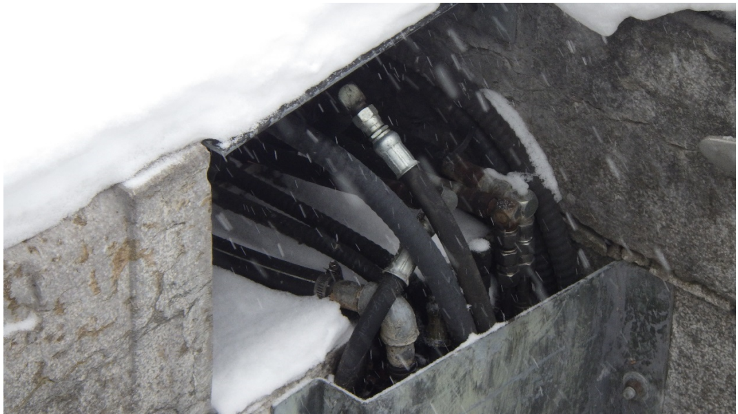
Photo n° 16 Porte #2 - Caniveau de conduites traversant le sas de l'écluse (RIMG2896.jpg).
