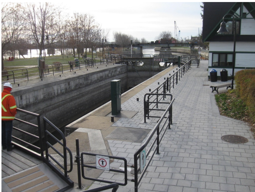
Photo n° 2 Vue vers l'amont de l'écluse #9 à partir de la rive gauche (IMG_1737.jpg).
