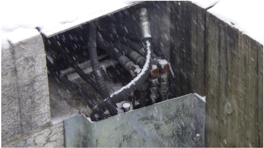
Photo n° 15 Porte #3 - Caniveau de conduites traversant le sas de l'écluse (RIMG2896.jpg).
