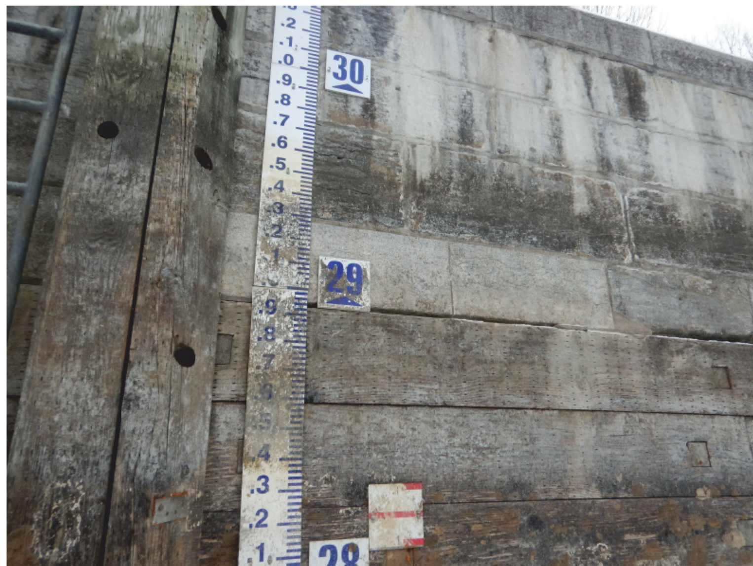
PHOTO 05-7206 MUR DROIT RIGHT WALL PICTURE
