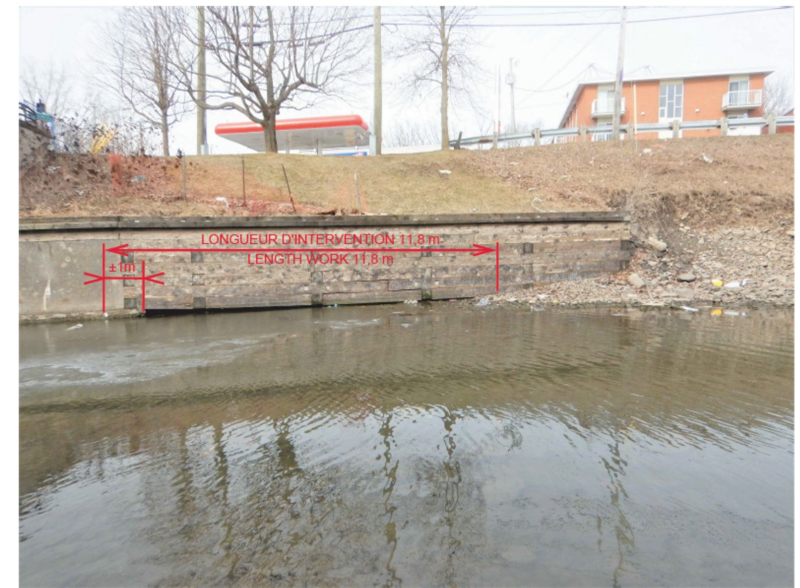
PHOTO 09-7845 MUR GAUCHE - AVAL PICTURE 09-7845 LEFT WALL - DOWNSTREAM
