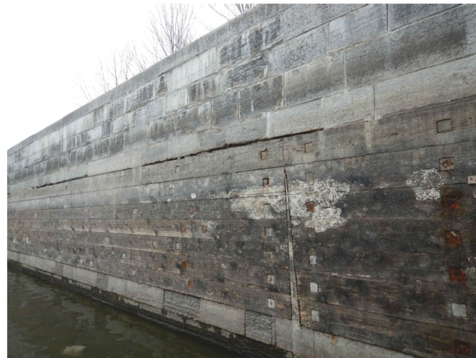
PHOTO 05-7965 MUR DROIT RIGHT WALL PICTURE
