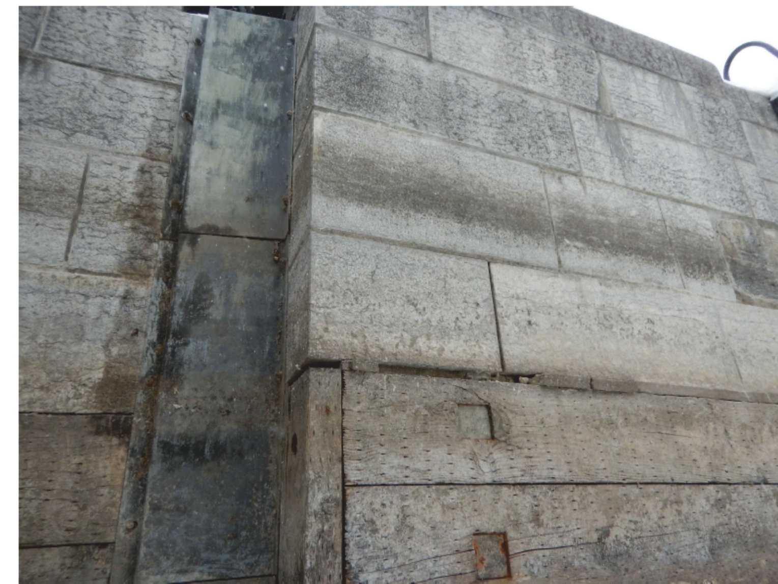
PHOTO 05-7200 MUR DROIT RIGHT WALL PICTURE
