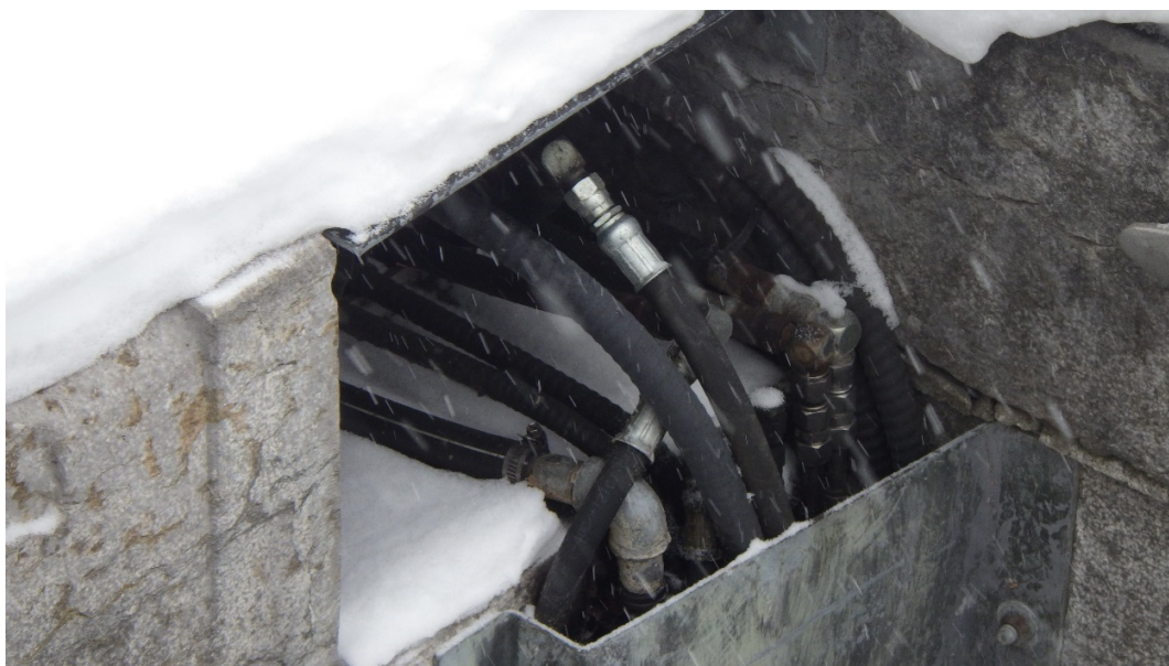
Photo n° 16 Porte #2 - Caniveau de conduites traversant le sas de l'écluse (RIMG2896.jpg).
