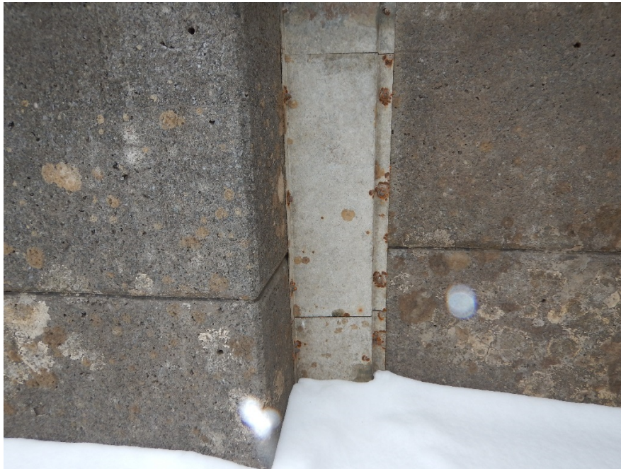
Photo n° 17 Porte #1 - Caniveau de conduites traversant le sas de l'écluse (DSCN7160.jpg).
