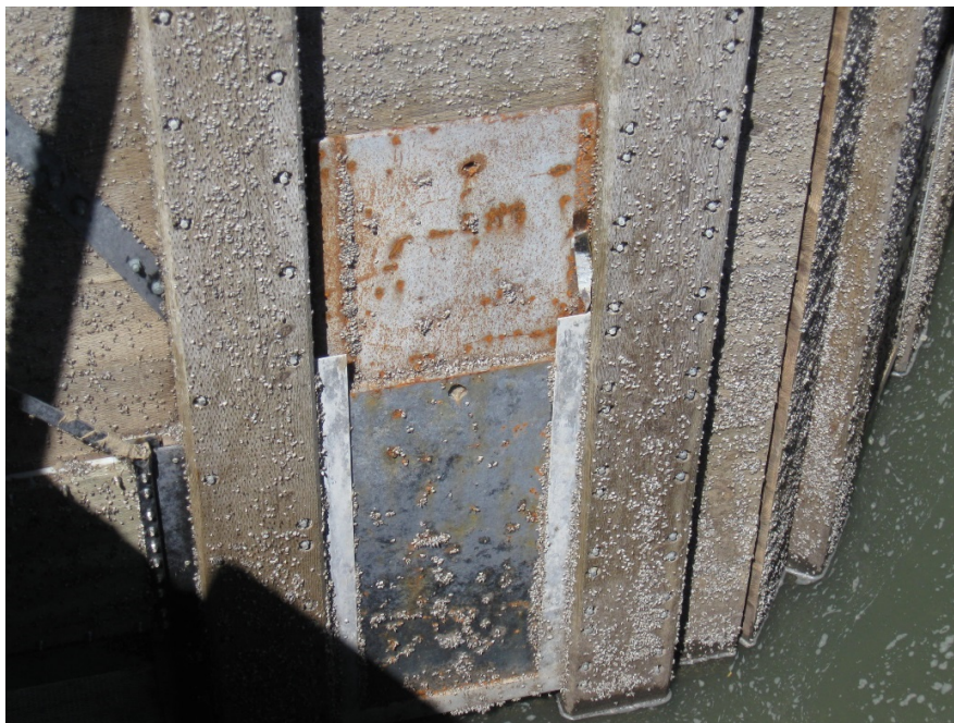
Photo n° 22 - Exemple de plaques en acier pour lester les portes amont de l'écluse #7 (IMG_2137.jpg).
