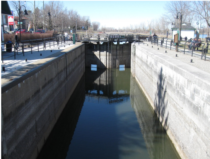
Photo n° 1 Vue vers l'aval de l'écluse #9 (IMG_2202.jpg).
