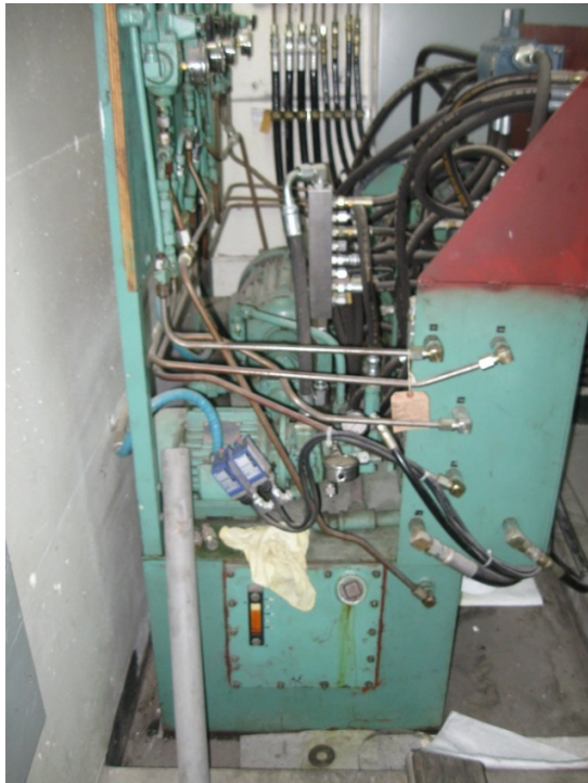
Photo n° 7 Salle Électrique de l'écluse #9 – vue vers l'Ouest (IMG_0502.jpg).
