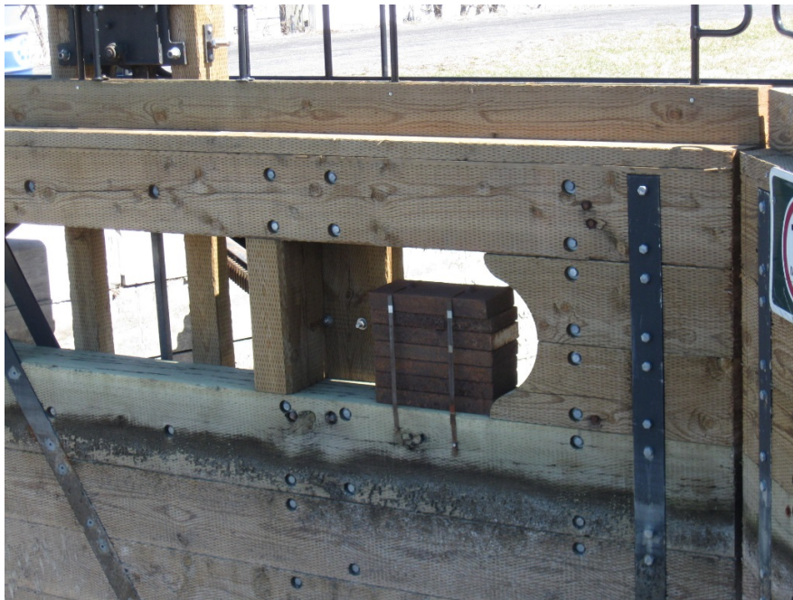
Photo n° 21 – Exemple de plaques en acier pour lester les portes amont de l'écluse #7 (IMG_2134.jpg).
