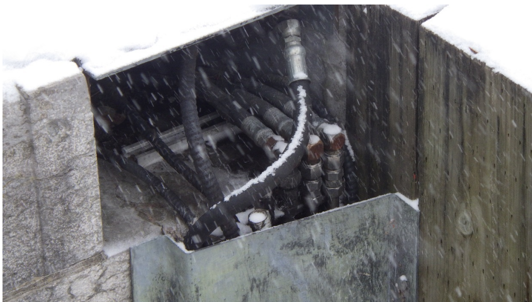
Photo n° 15 Porte #3 - Caniveau de conduites traversant le sas de l'écluse (RIMG2896.jpg).
