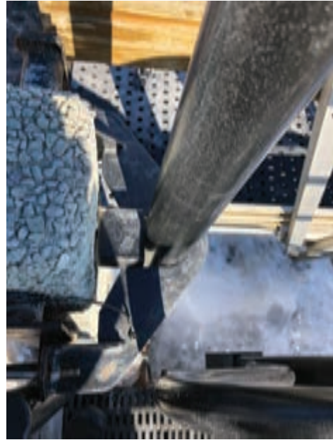
Square post with Railing Bracket Quincaillerie d'attache pour poteau carré
