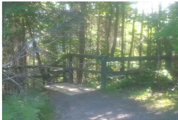
Structure de l'ancien escalier à démolir
