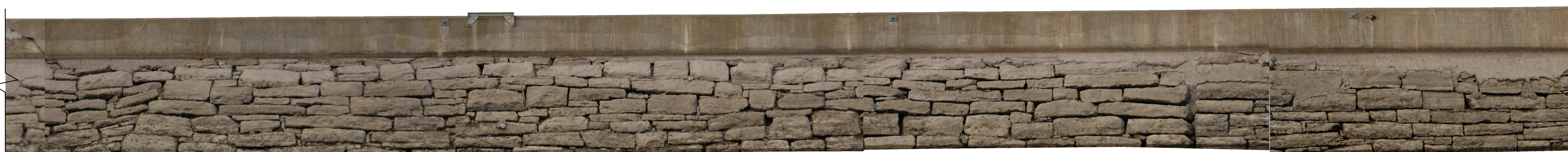
BIEF 4 - NORD - 47 - C
