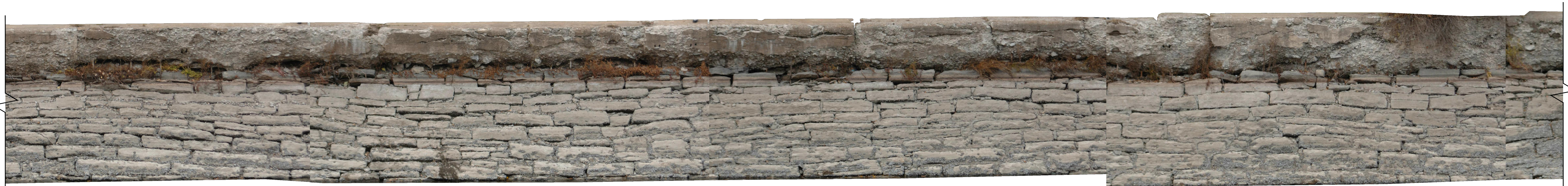
BIEF 4 - NORD - 46 - C
