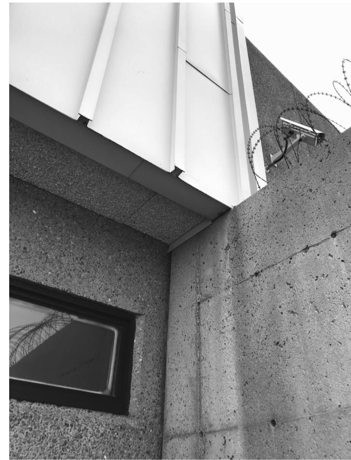
5 PHOTOS REVÊTEMENT EXISTANT EXISTING CLADDING PHOTO ÉCH. 1: 50
