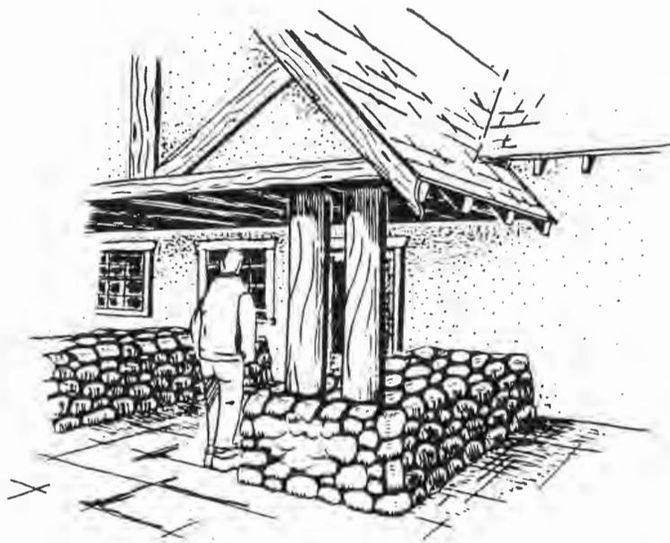
*Fig. 3.44. Les extrémités de bordure de rive taillées avec simplicité, les têtes de chevron apparentes et les colonnes simples en rondins écorcés sont des exemples de traitement rustique. On notera que les têtes de chevron apparentes ne devraient servir que là où le risque de feu de forêt est peu prononcé.*
