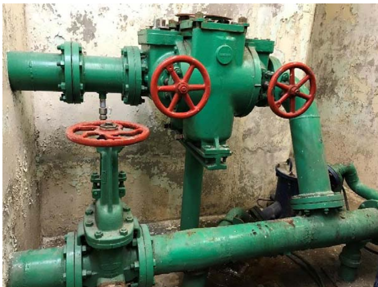
Photo 25 – Partie du système de remplissage de l'espace entre la chambre et la porte du bief
