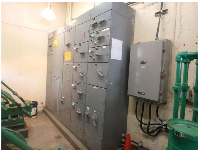
Photo 17 et 18 – Salle des pompes avec CCM et accumulateur d'huile de la porte d'amont
