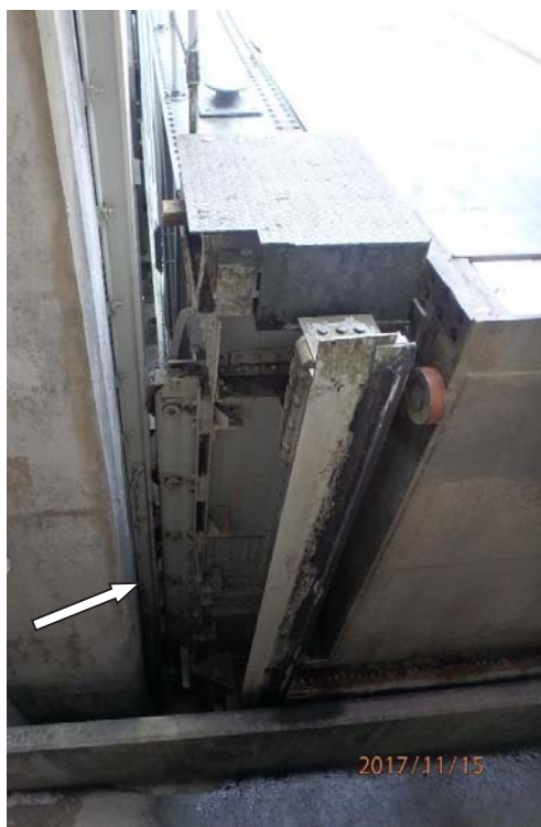
Photo 15 – Galets de guidage
