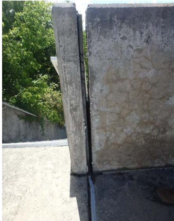
Photo 11 – Élargissement du joint entre les escaliers et la structure principale en béton, située en amont de la culée du bief amont
