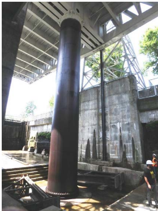
Photo 9 – Vérin et structure de support en saison de navigation
