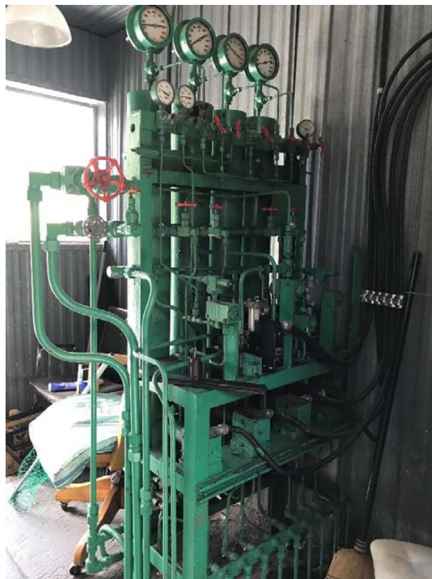
Photo 23 – Commandes hydrauliques des portes d'aval
