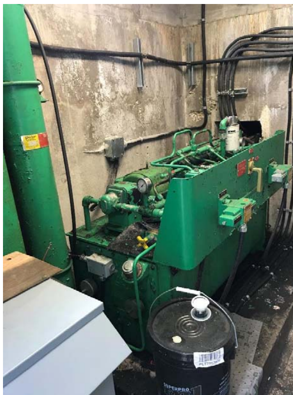
Photo 26 – Bloc hydraulique de la porte de garde
