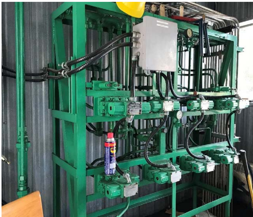
Photo 23 – Commandes hydrauliques des portes d'aval
