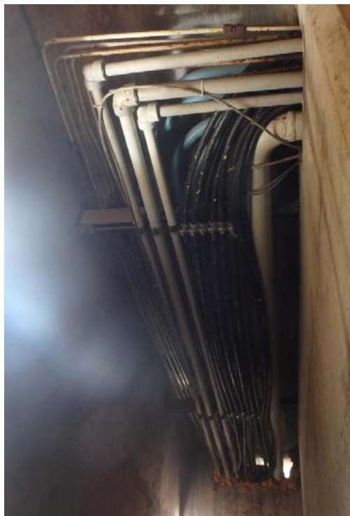
Photo 19 – Lignes électriques et mécaniques du puits de tuyaux et de conduits
