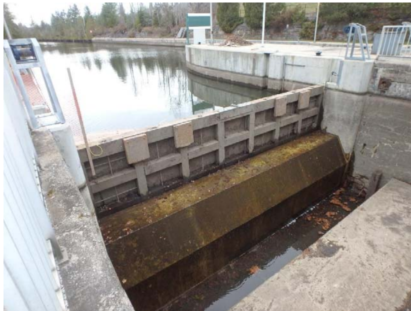
Photo 8 – Vue du bief aval et de l'enclave de porte montrant la porte de protection hivernale en position
