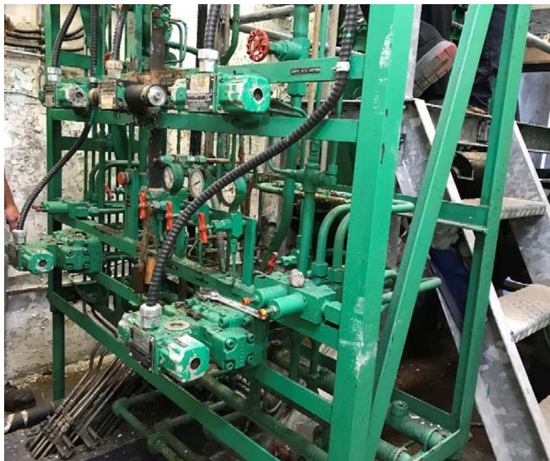
Photo 21 – Commandes hydrauliques de la porte d'amont
