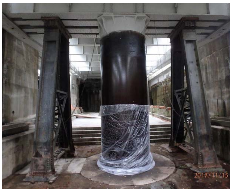
Photo 10 – Vérin et structure de support en position de support hivernal
