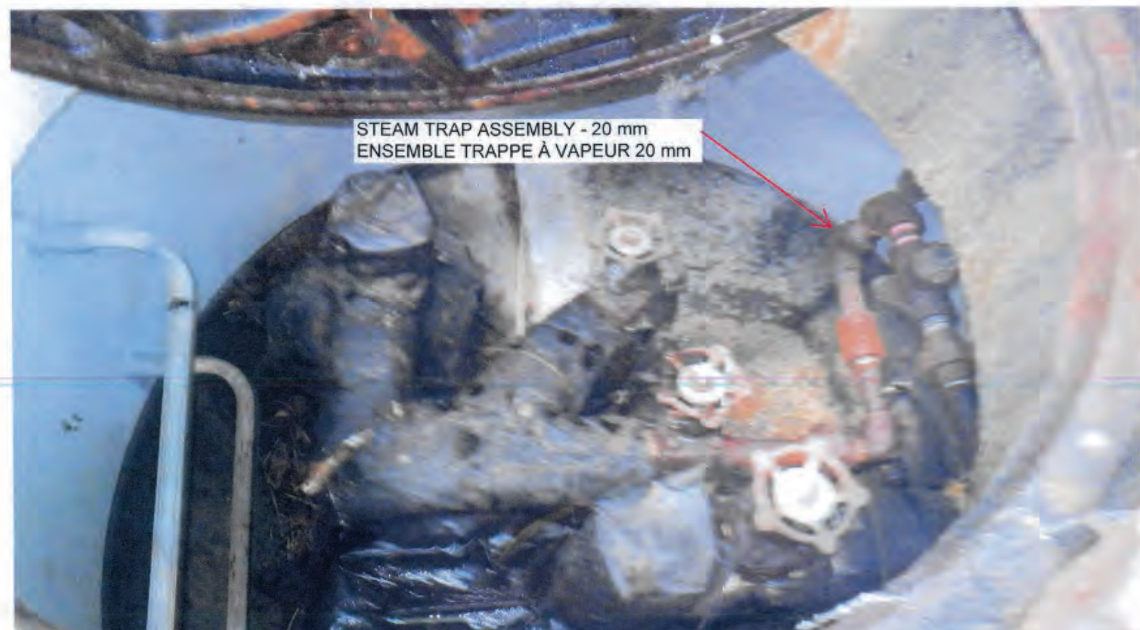
GREEN ISLAND VALVE BOX - REPLACE 20 mm STEAM TRAP ASSEMBLY PER 33 65 13 CHAMBRE DE VANNES - REMPLACER L'ENSEMBLE TRAPPE À VAPEUR 20 mm SELON 33 65 13
