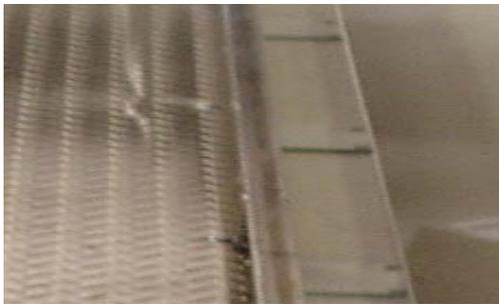
119. Un câble antichute doit être installé sur toute la longueur du toit et maintenu par deux points d'ancrage. Il doit satisfaire aux normes de contrainte du Code canadien du travail (CCT) de 5 000 lb minimum, DORS/86-304.
