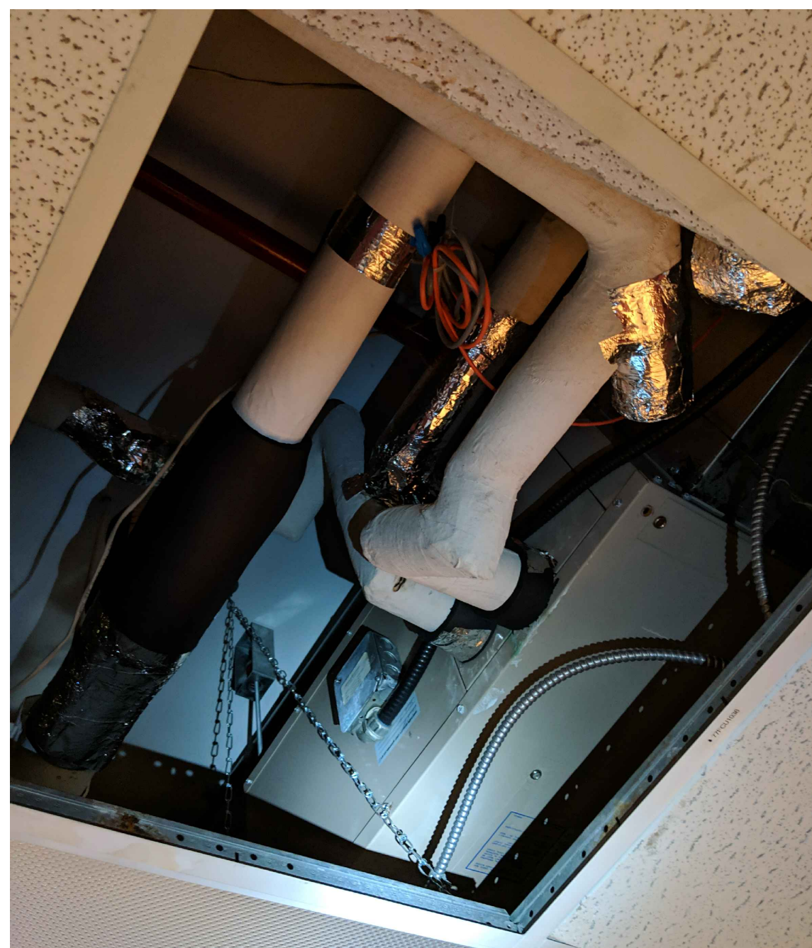
3 M109 1:50 ROOM 1036 - EXISTING FAN COIL UNIT VENTILO CONVECTEUR EXISTANTE
