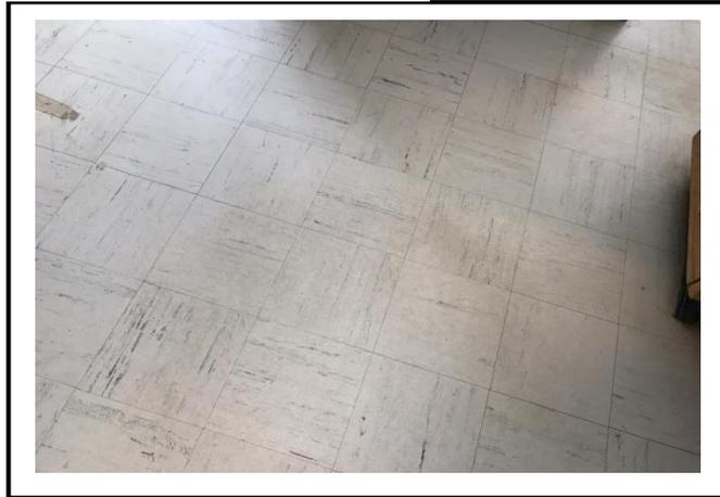
Photo 1: Tuiles en vinyle et masticque amianté dans les salles EW6, EW15 et EW16 – Building 50
