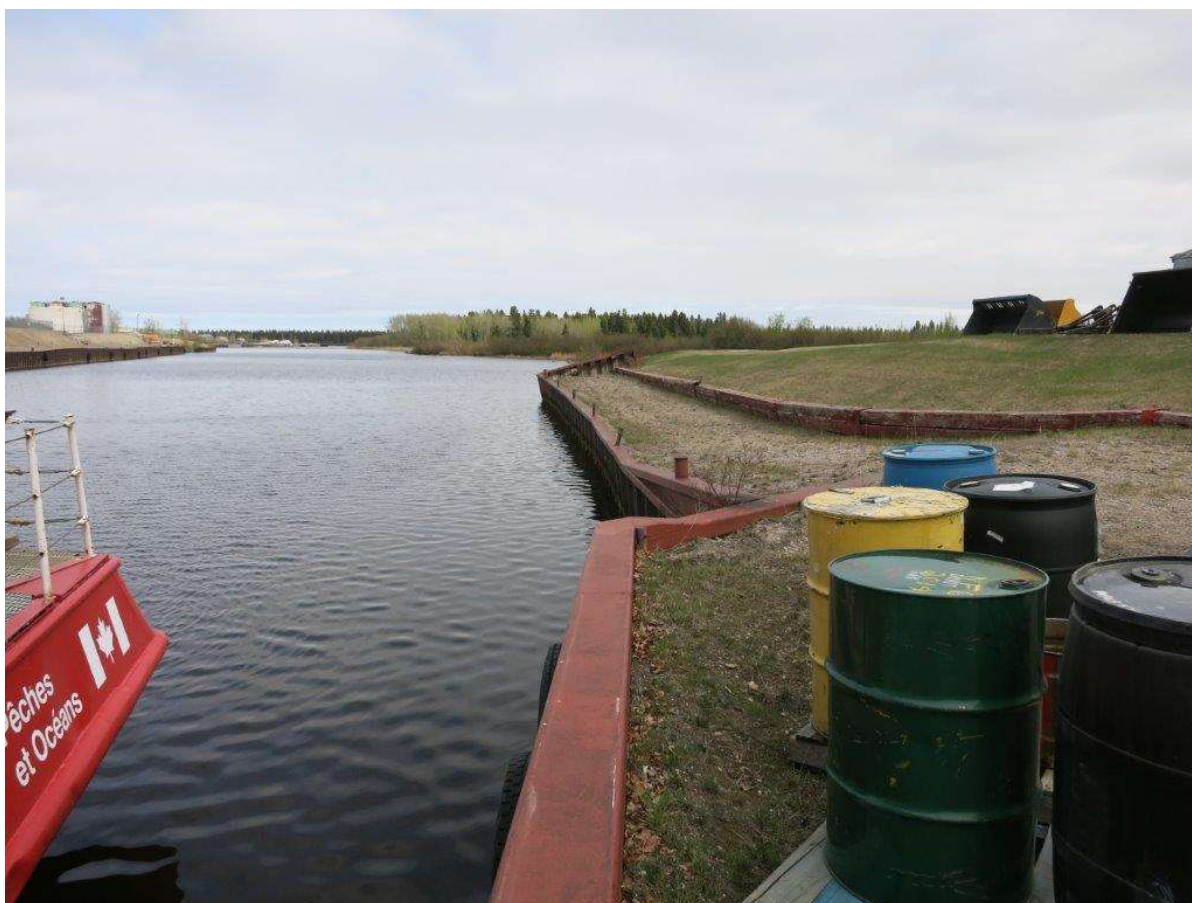
Photo 4 : Partie est du quai en palplanches, soit la partie qui est endommagée
