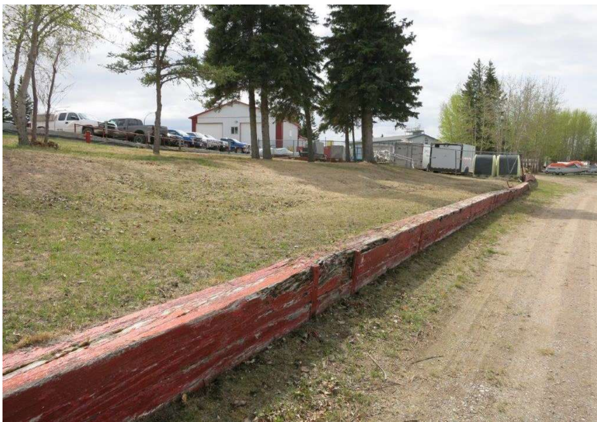
Photo 8 : Mur de soutènement en mauvais état
