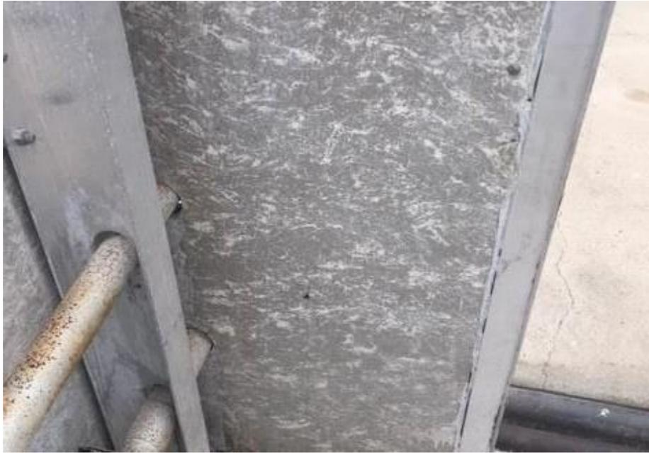
**Photo 1 :** *Échantillon NL6323-A01 – Panneaux d’amiante-ciment sur les murs*
