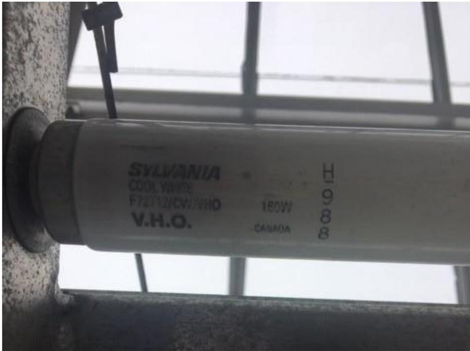
**Photo 3** : Exemple de tubes fluorescents contenant du mercure à l'intérieur du bâtiment.
