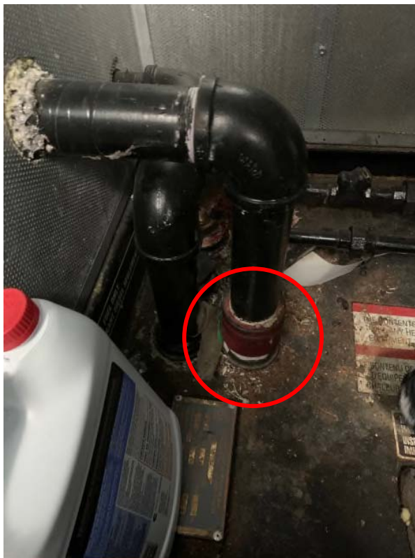
Photo 1: sifflet (encerclé) installé à l'intérieur du système de réservoir de stockage de carburant du bâtiment 91/T82F
