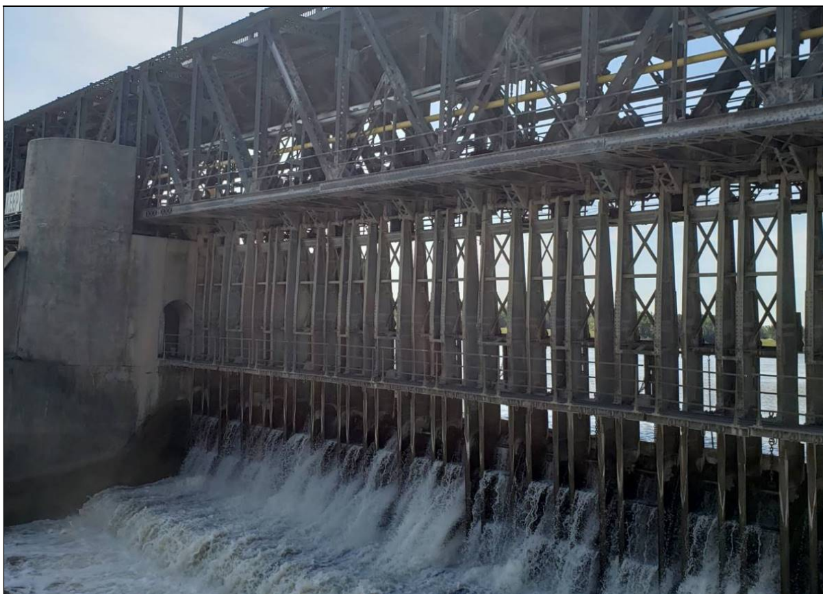
Figure 3 : Côté aval (nord) du barrage avec cadres et rideaux déployés
