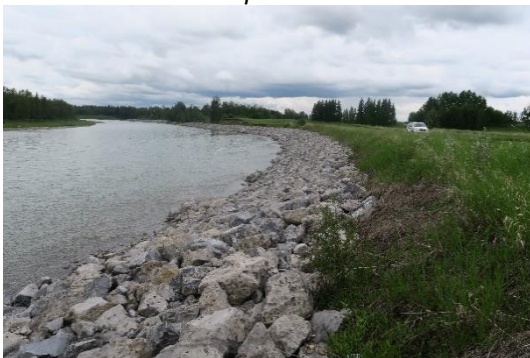
Vue sur l'ouest depuis l'extrémité nord-est
