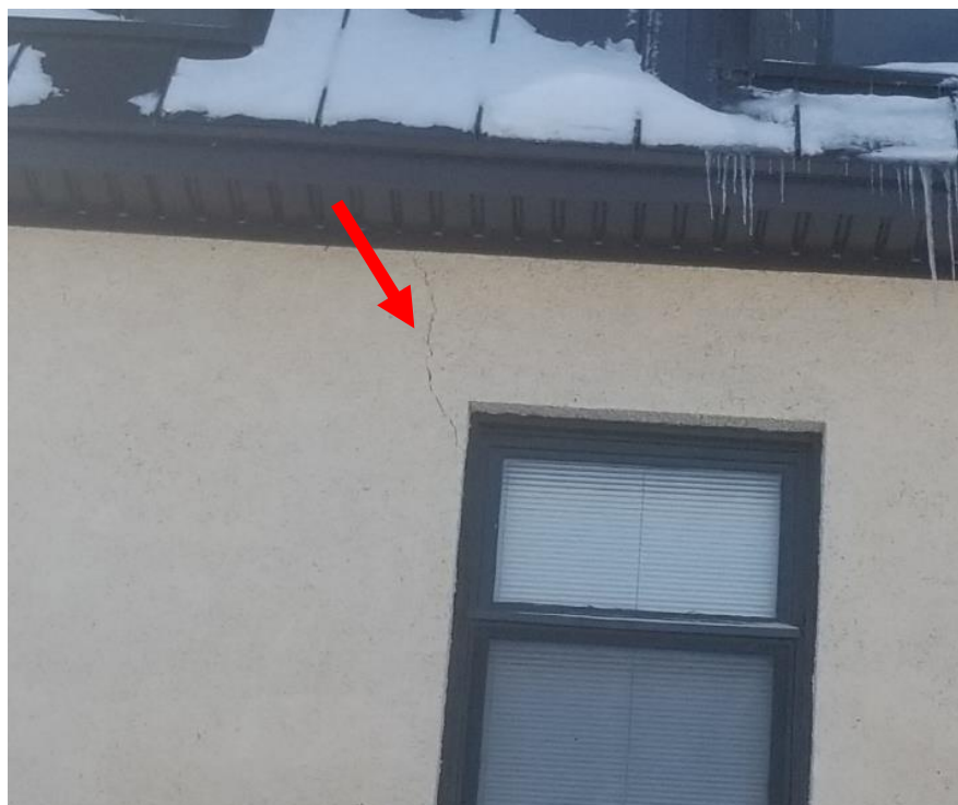
Photo 2. Extérieur, mur nord au-dessus de la cinquième fenêtre à partir de l'ouest, 1 mètre linéaire du mur en stuc dans un état passable.
