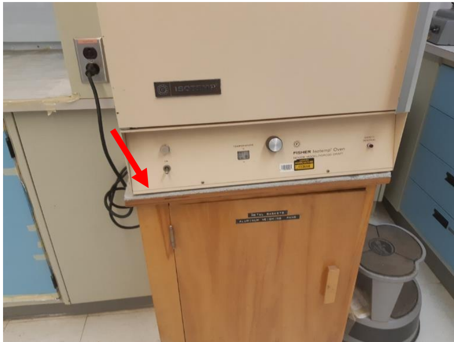
Photo 1. Rez-de-chaussée, pièce 9, dessus de comptoir, 2 mètres linéaires de fibrociment (Transite) dans un état passable.
