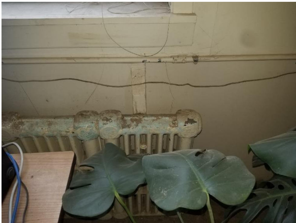
Photo 2. Rez-de-chaussée, bureau 103, sous la fenêtre nord, 1 mètre carré de cloison sèche dans un état passable.
