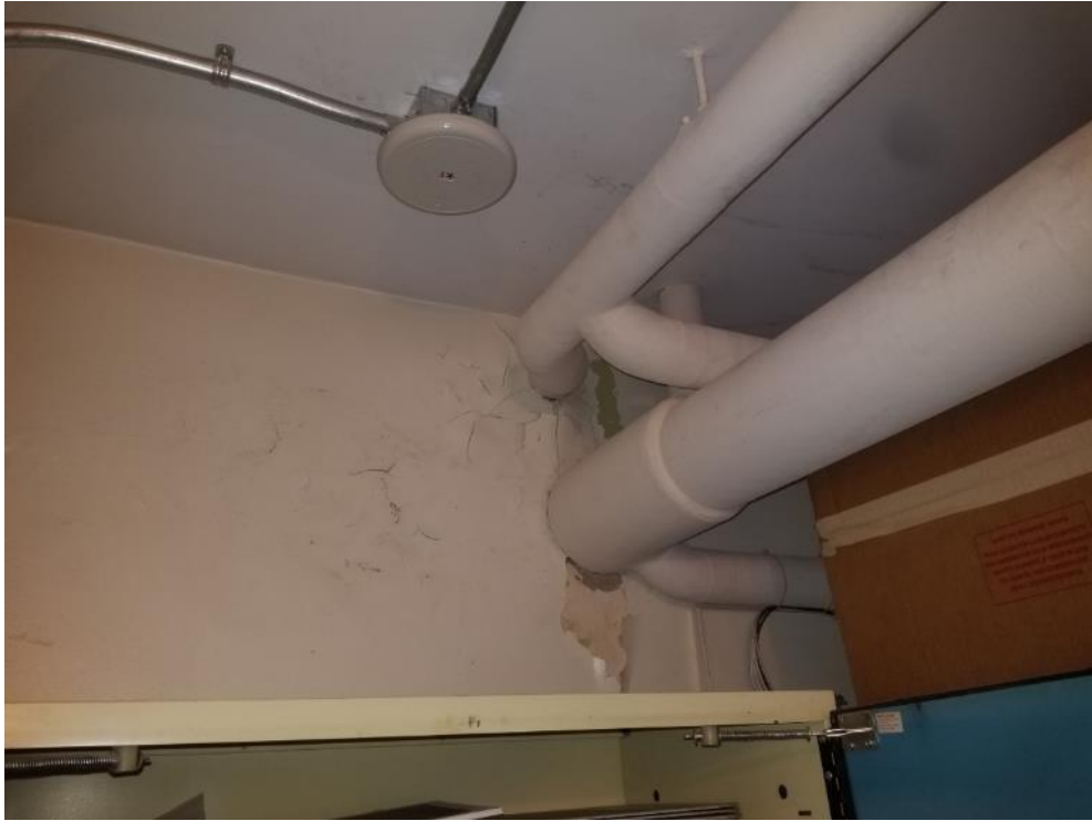
Photo 3. Sous-sol, B-02A, mur sud, 1 mètre carré de plâtre sur le mur dans un état passable.
