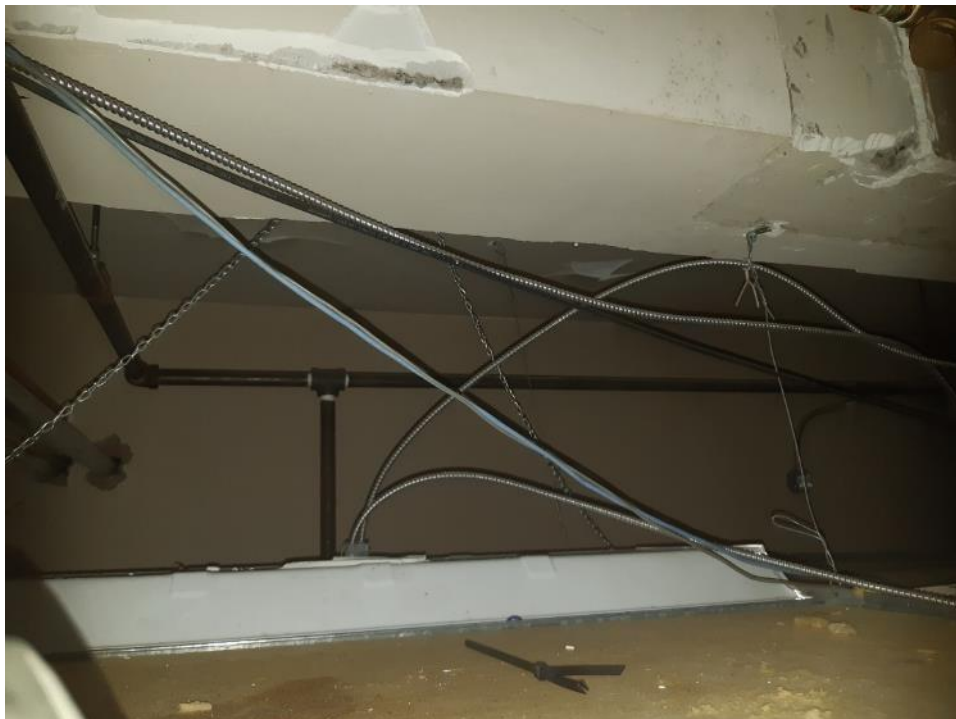
Photo 7. Sous-sol, local d'entreposage 110, ouest de la porte, 2 mètres carrés de plâtre au plafond en mauvais état et 4 mètres carrés de débris sur des carreaux de plafond.
