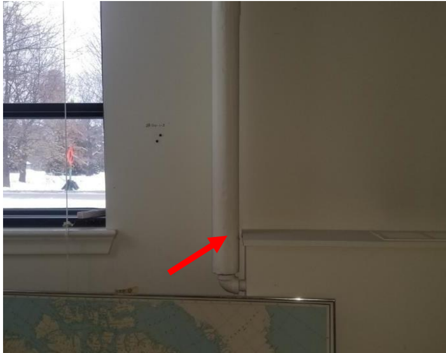
Photo 1. Rez-de-chaussée, salle principale, mur nord, <1 mètre carré d'isolant alvéolaire dans un état passable.
