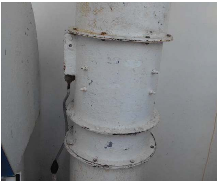
Figure 16: Photographie du ventilateur axial d'évacuation de la cuisine – installé sur le pont découvert
