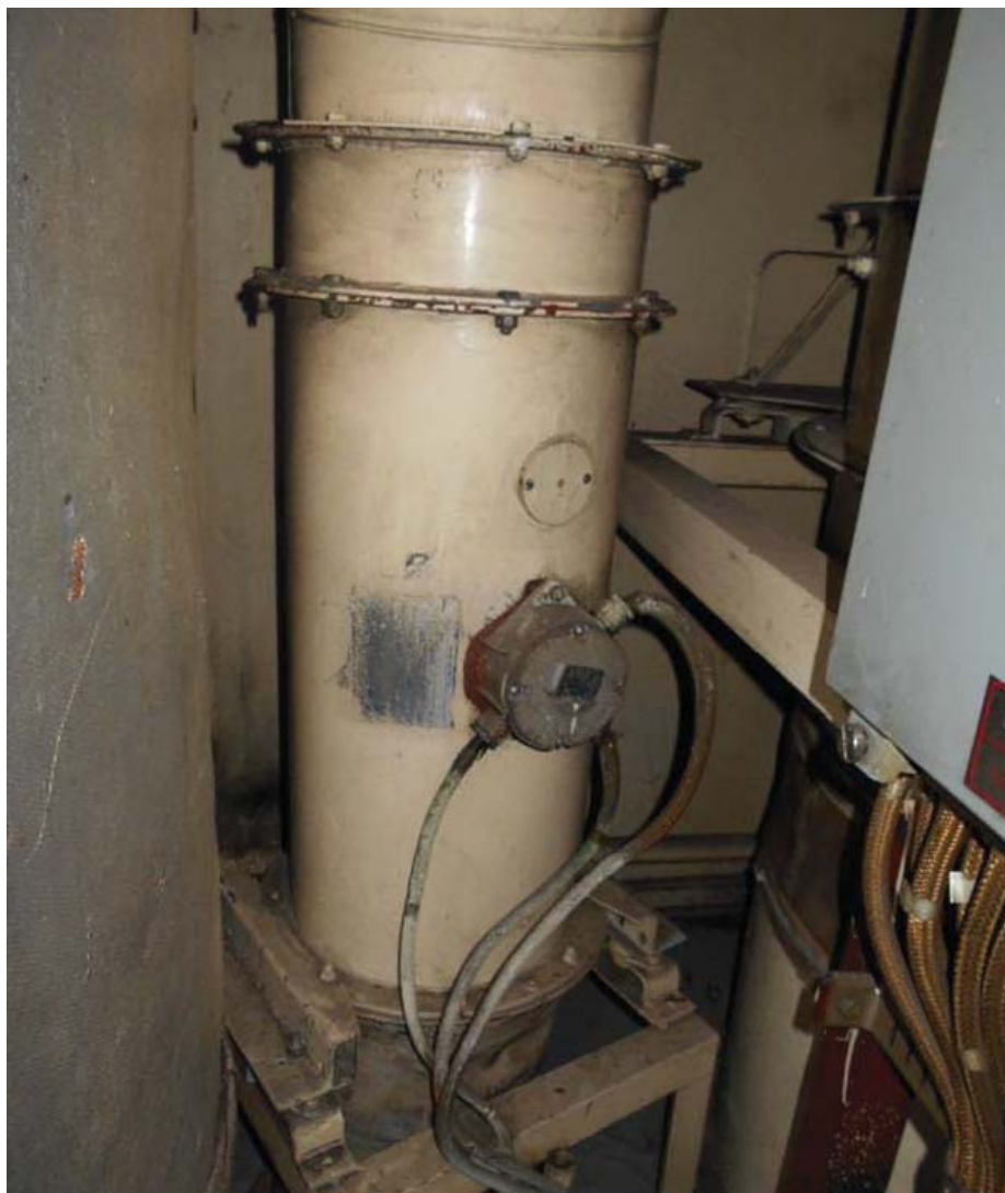
Figure 20: Photographie du ventilateur axial d'alimentation de la salle de commande des machines
