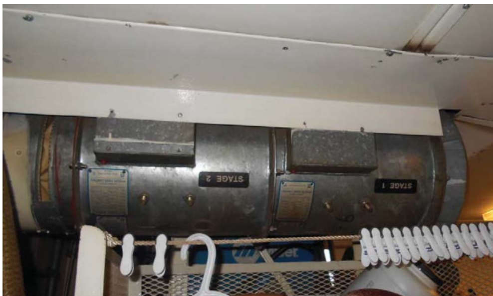
Figure 18: Photographie des ventilateurs axiaux d'alimentation de l'atelier du pont
