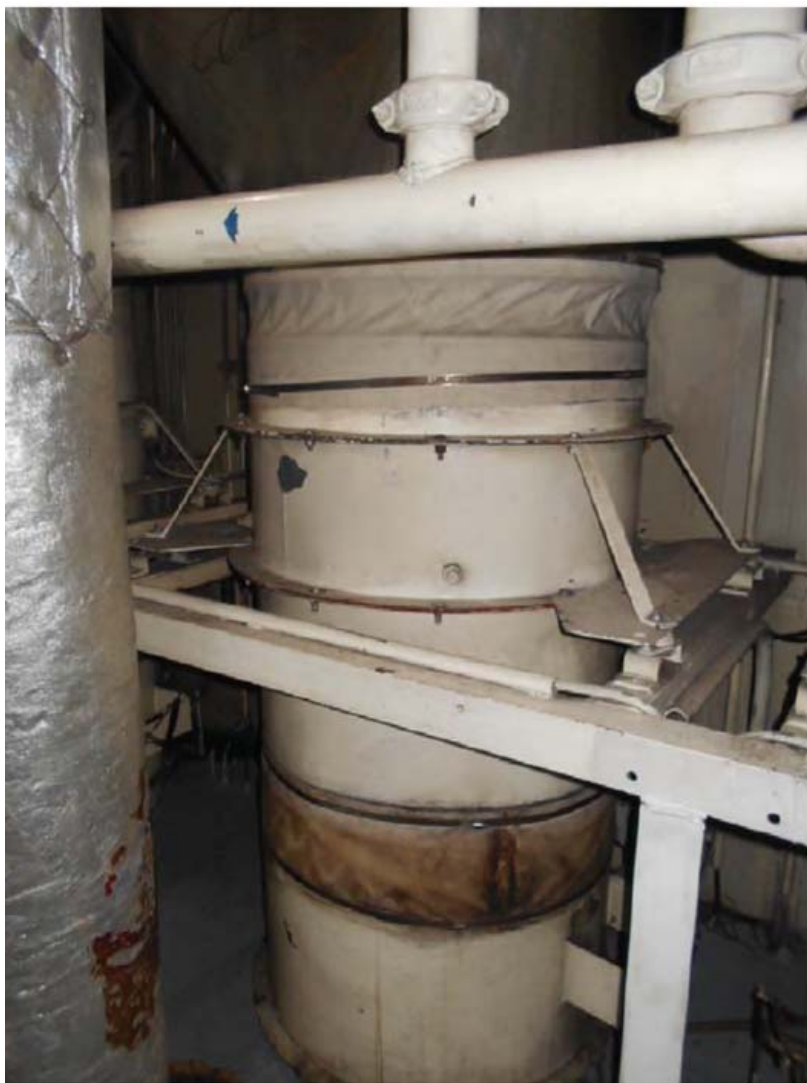
Figure 2: Photographie du ventilateur d'alimentation dans la salle des machines
