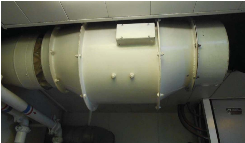
Figure 12: Photographie du ventilateur axial d'alimentation du groupe électrogène de secours
