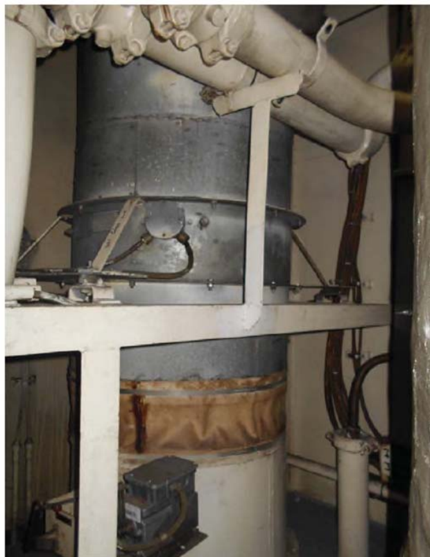
Figure 4: Photographie du ventilateur axial d'évacuation de la salle des machines
