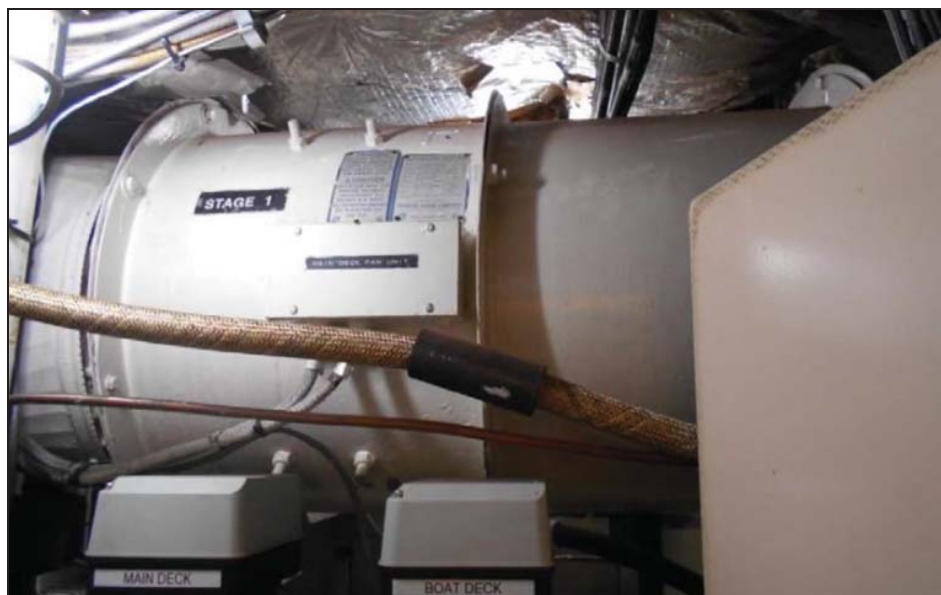
Figure 8: Photographie du ventilateur axial d'alimentation du pont principal
