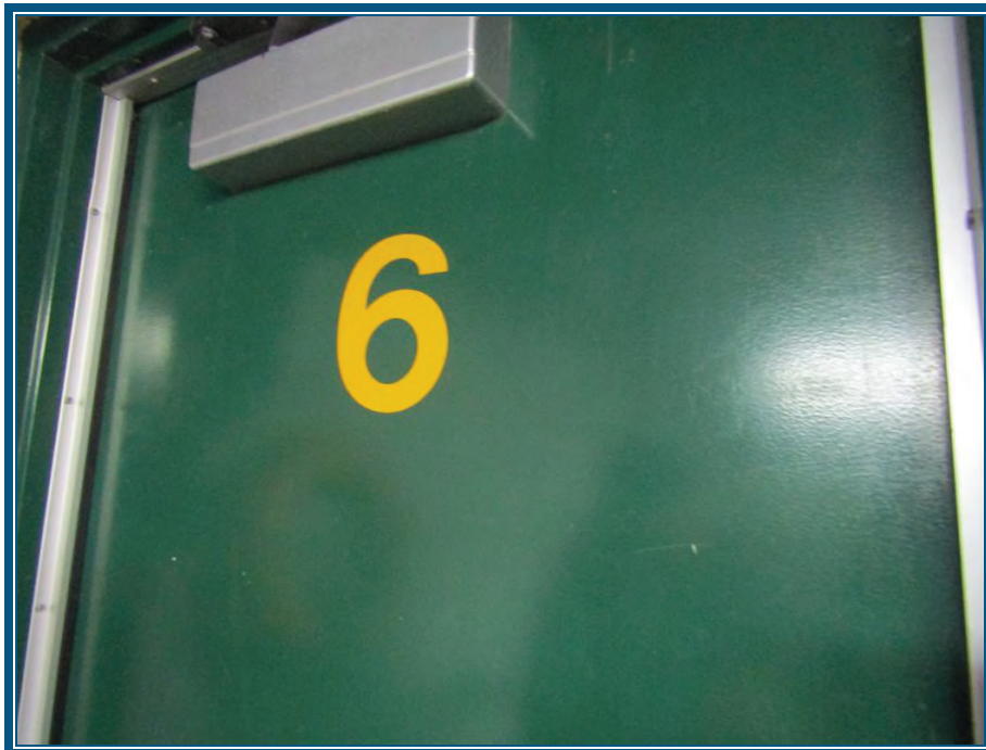
Photo 72: Porte d'entrée au pilier 6
