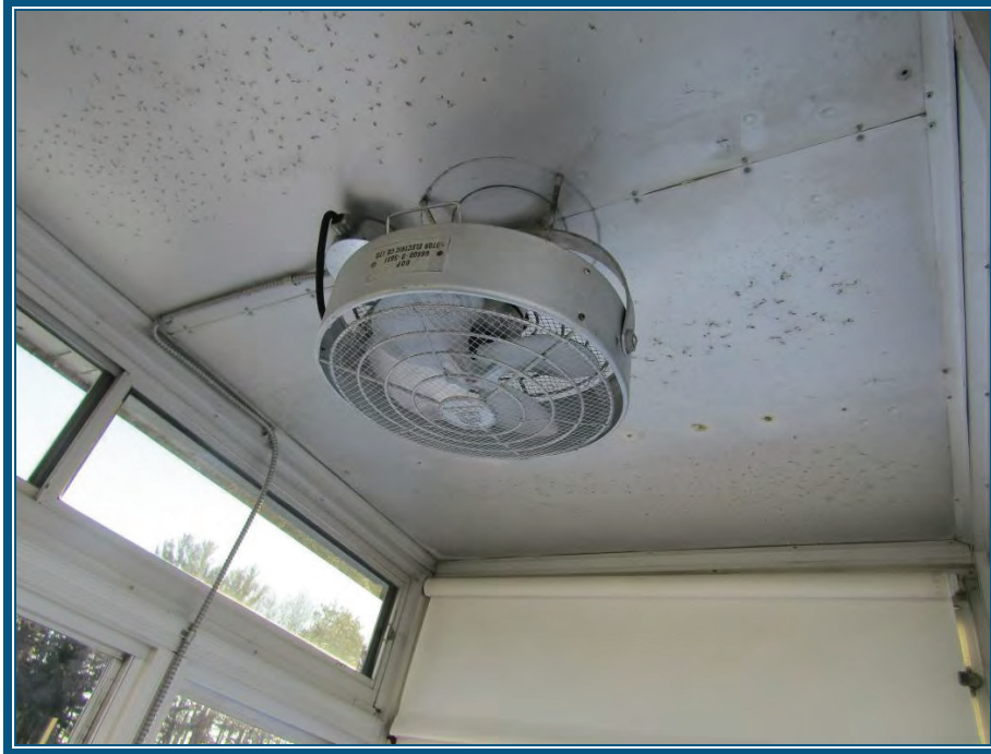
Photo 29 : Logette contrôle amont Plafond en métal
