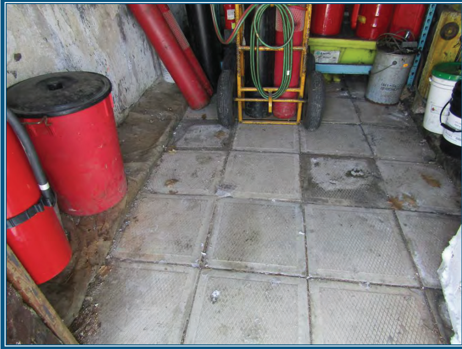
Photo 13: Vue de l'intérieur de l'entrepôt Plancher en carreaux de béton
