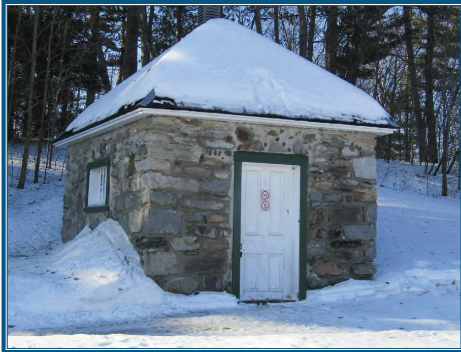
Photo 11: Vue de l'Entrepôt Murs extérieurs en pierres et mortier - le mortier ne contient pas d'amiante Peinture verte et blanche sur la porte et la fenêtre
