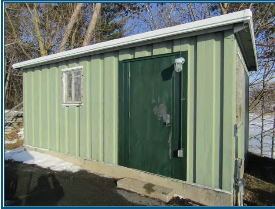
Photo 65: Vue de la façade principale
