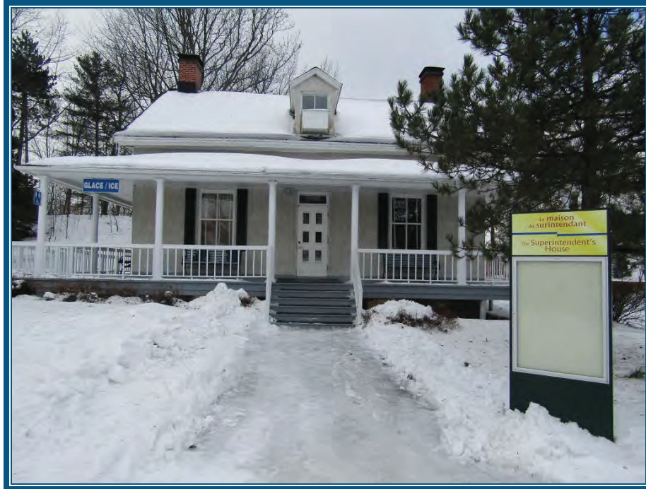
Photo 49: Vue de la façade principale de la maison du maître éclusier Le crépi de ciment avec agglomérats de pierre des murs extérieurs contiennent de l'amiante (phase fini décoratif)
