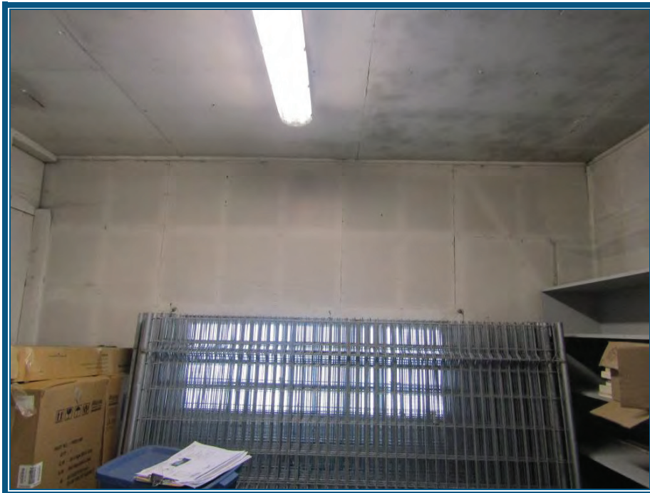
Photo 24: Vue de l'intérieur du garage Murs et plafond en béton
