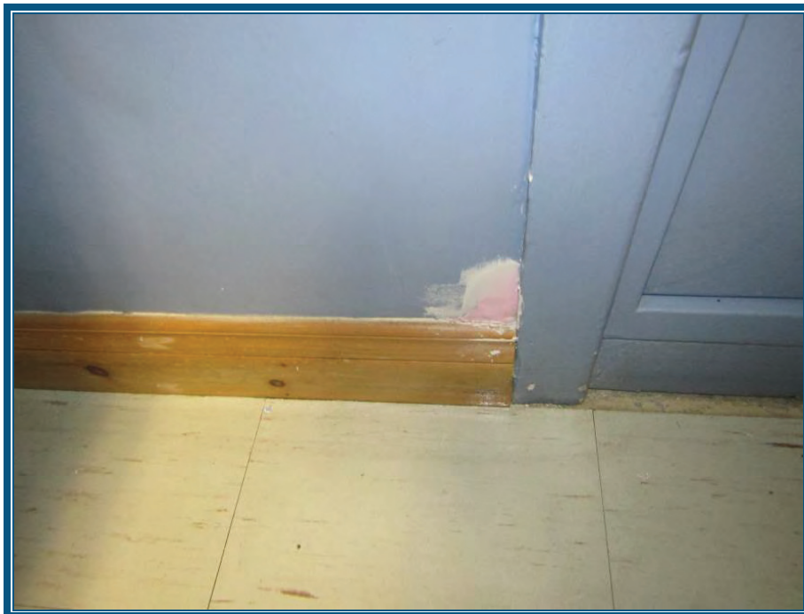
Photo 38: Le mur en gypse du bureau au rez-de-chaussée ne contient pas d'amiante
