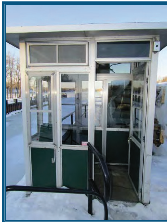
Photo 48: Plancher de béton Murs en structure de plastique et vitres
