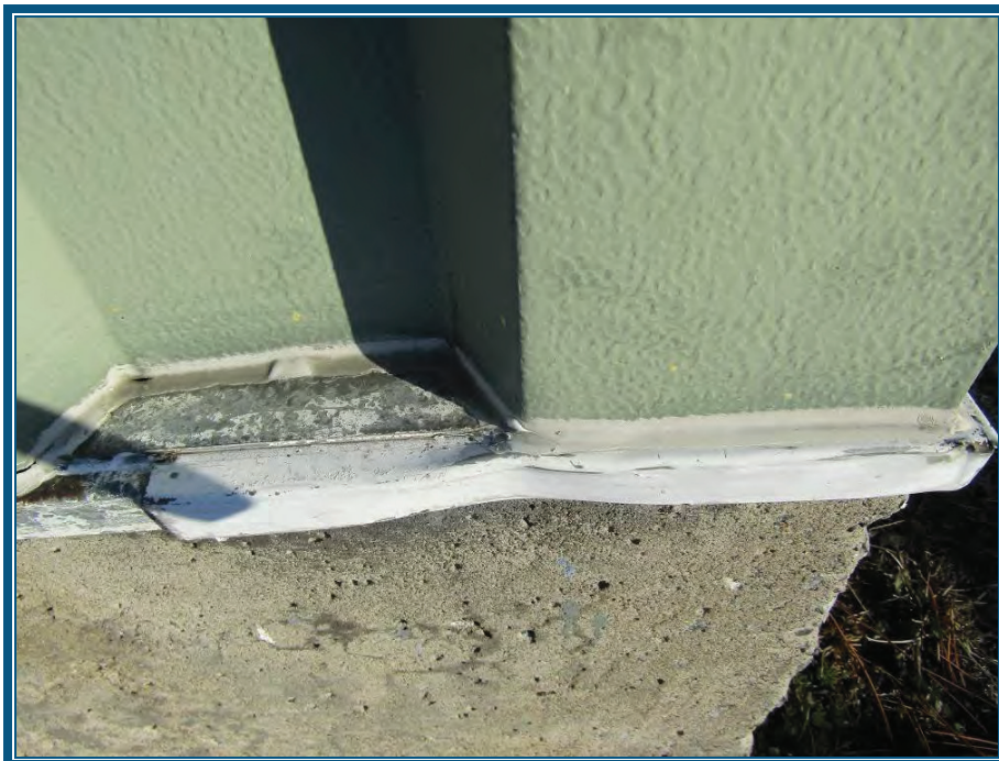
Photo 66: Joint d'étanchéité ne contient pas d'amiante
