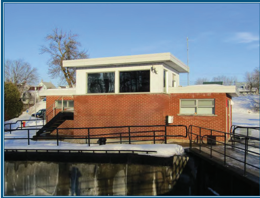
Photo 31: Vue de la logette de l'éclusier Mur en briques
