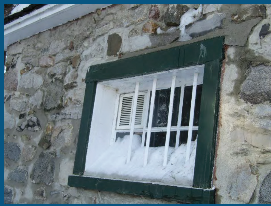
Photo 12: Vue d'une fenêtre de l'entrepôt Le joint d'étanchéité au pourtour extérieur de la fenêtre ne contient pas d'amiante
