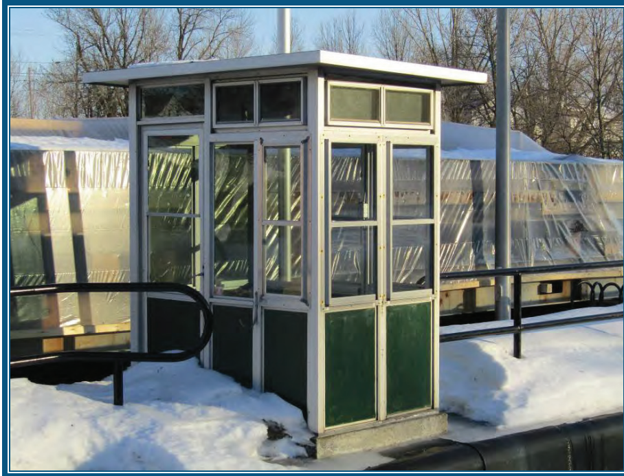
Photo 27: Vue de la logette de contrôle – amont Murs extérieurs en vitres et plastiques
