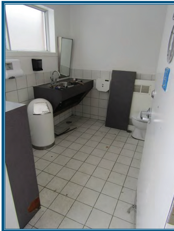
Photo 46 : Vue salles de bain façade principale Plancher et bas de mur en céramique, murs et plafond en gypse
