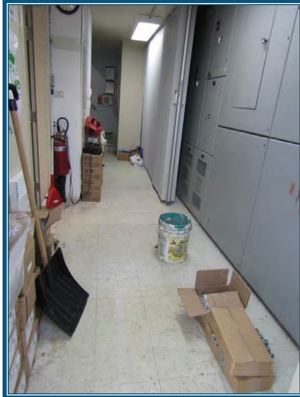
Photo 37: Les tuiles de vinyle au plancher du couloir ne contiennent pas d'amiante
