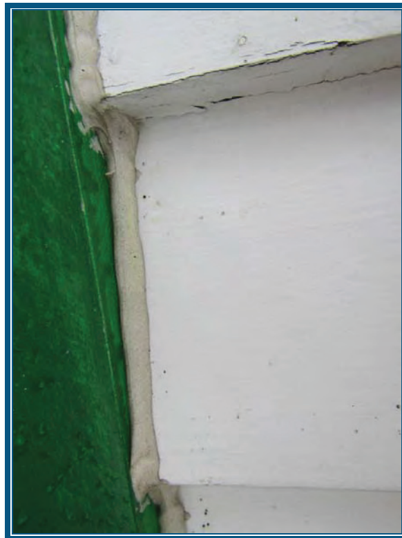
Photo 22: le joint d'étanchéité au pourtour de la porte du garage ne contient pas d'amiante
