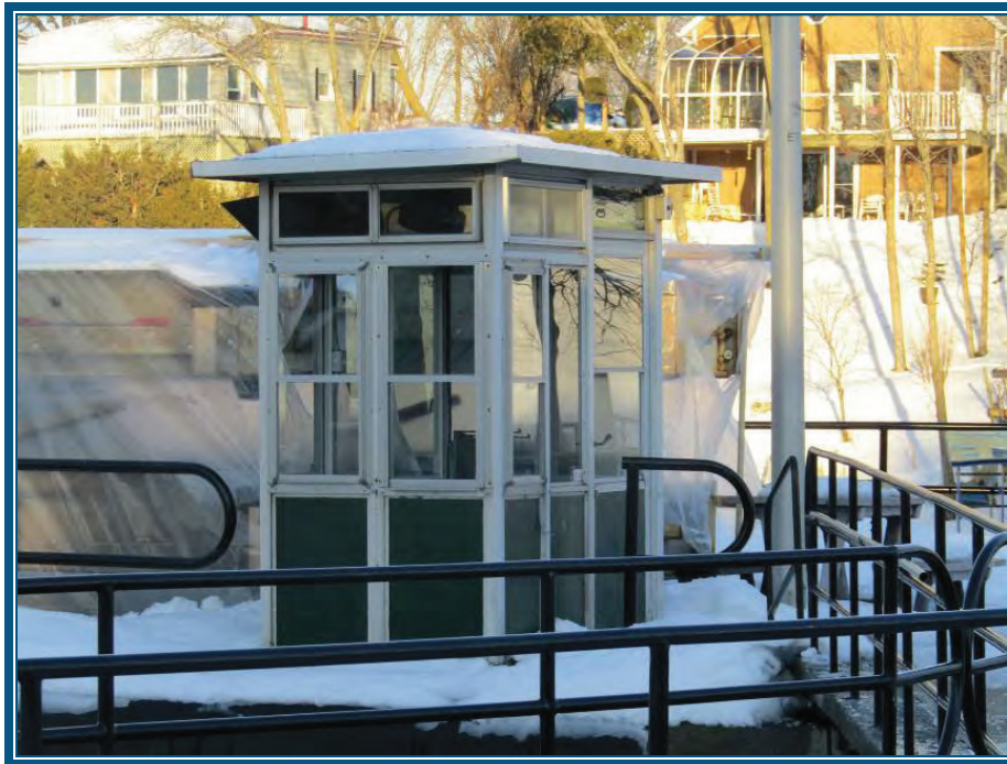
Photo 47: Vue de la logette de contrôle –aval
