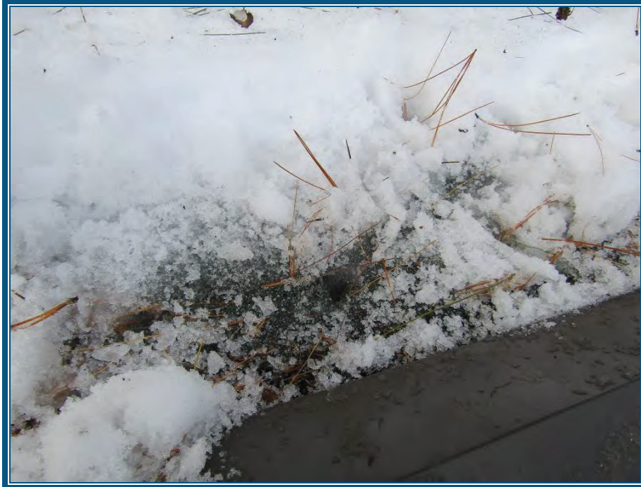
Photo 7: Toiture en asphalte ne contient pas d'amiante
