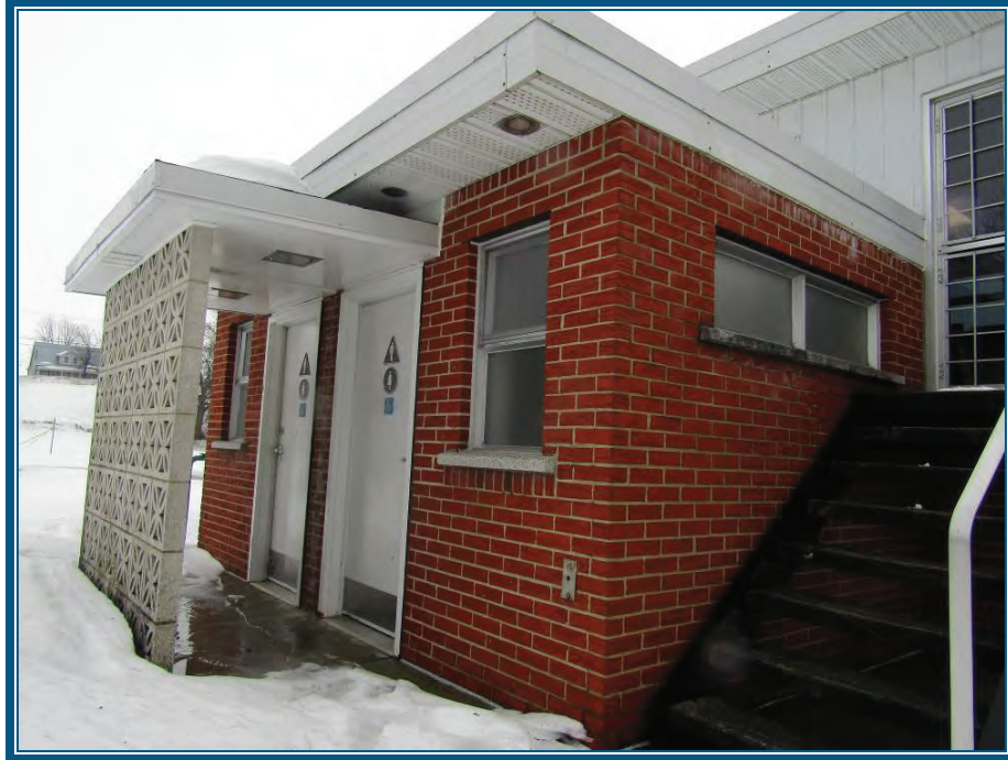
Photo 33: Façade principale de la logette de l'éclusier) le joint d'étanchéité au pourtour des portes ne contient pas d'amiante
