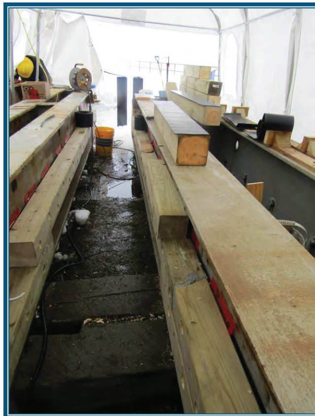
Photo 10: Poutrelles peintes en gris, entreposées dans des abris temporaires
