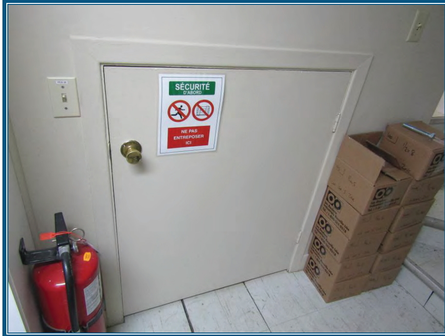
Photo 39: Trappe d'accès au local d'entreposage au rez-de-chaussée
