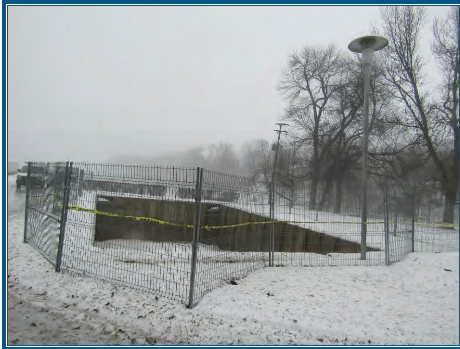
Photo 9: Vue de l'entrepôt à poutrelles clôturé
