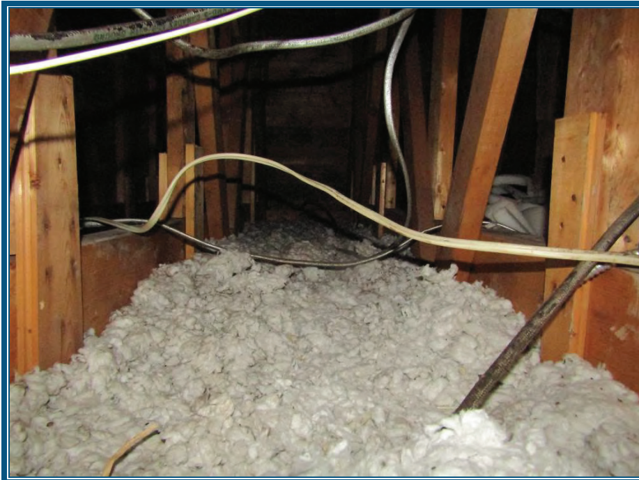
Photo 6: Flocage au plancher du grenier ne contient pas d'amiante
