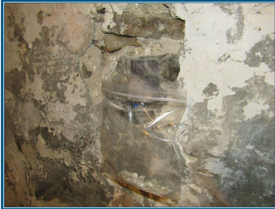
Photo 53: Le mortier de pierre au sous-sol ne contient pas d'amiante
