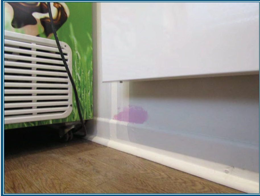
Photo 55: Rez-de-chaussée Mur en gypse ne contient pas d'amiante Plancher en bois
