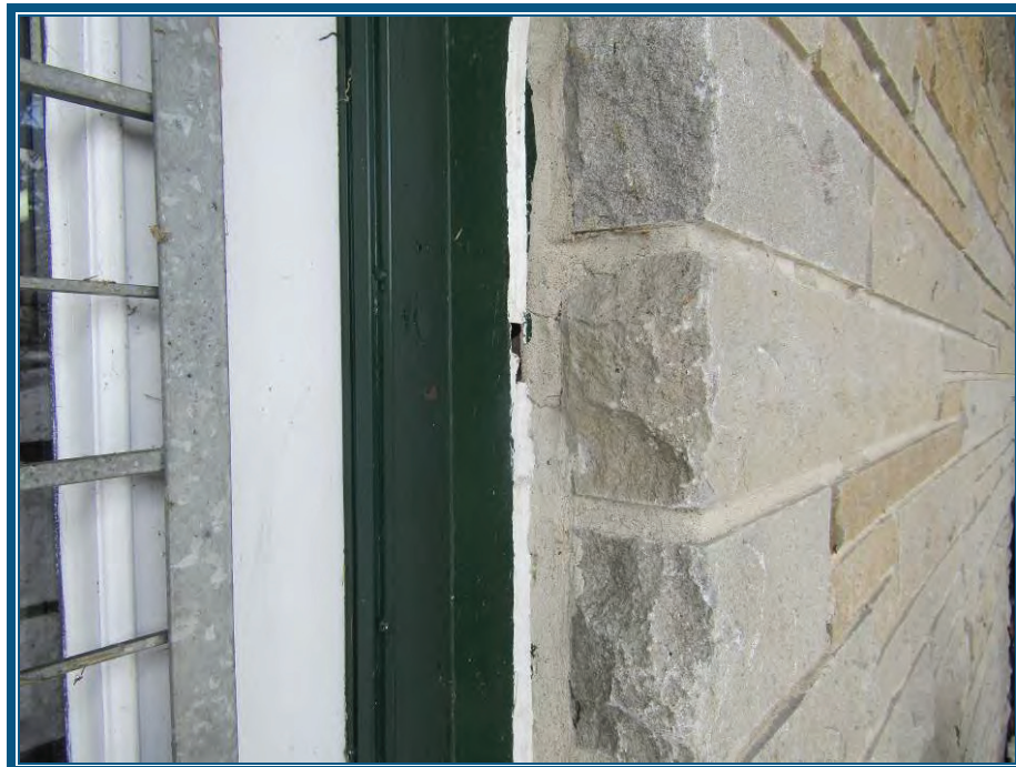
Photo 2: Joint d'étanchéité au pourtour de la porte d'entrée ne contient pas d'amiante
