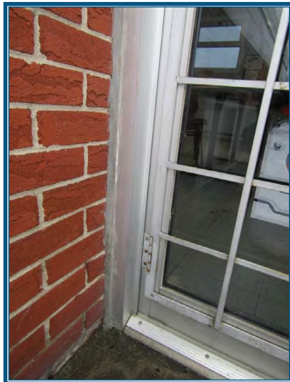
Photo 44: Porte de l'étage Le joint d'étanchéité au pourtour de la porte ne contient pas d'amiante
