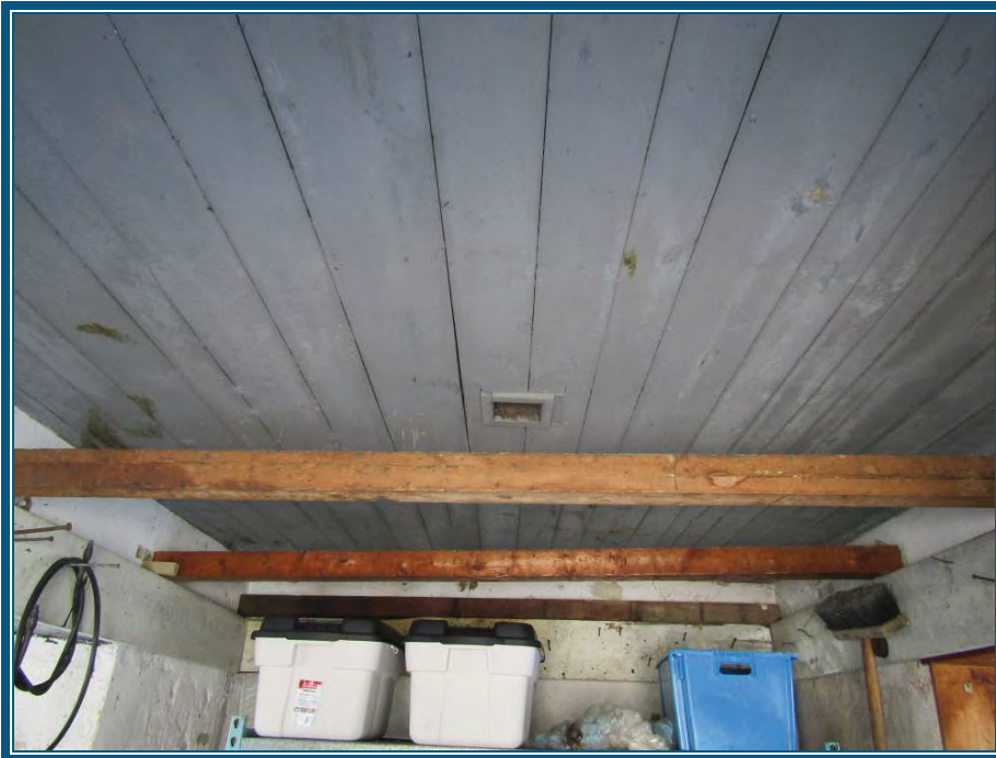
Photo 14: Vue de l'intérieur de l'entrepôt Plafond en bois
