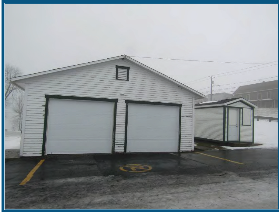
Photo 19: Vue du garage Mur extérieur en bois, peints en blanc Portes de garage peintes en blanc, cadres peints en vert
