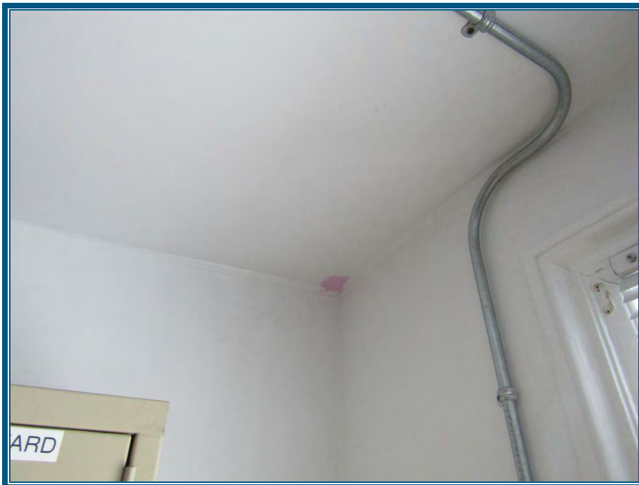
Photo 60: Murs et plafond de gypse dans le vestiaire à l'étage ne contiennent pas d'amiante
