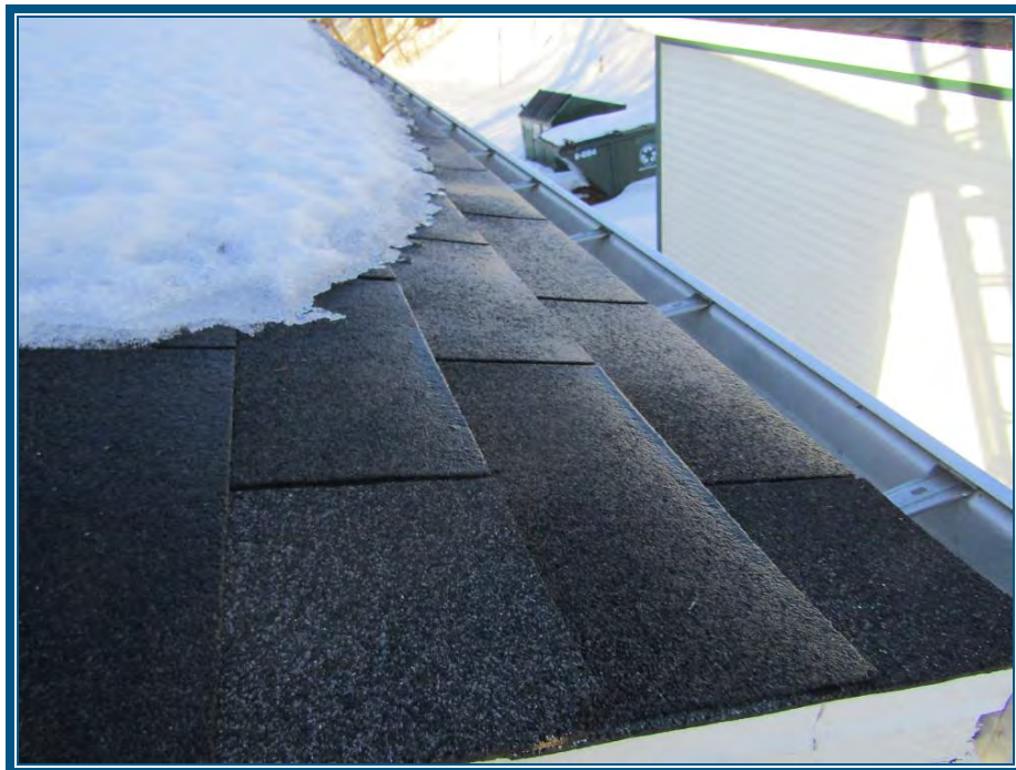
Photo 20: Toiture du garage les bardeaux d'asphalte ne contiennent pas d'amiante
