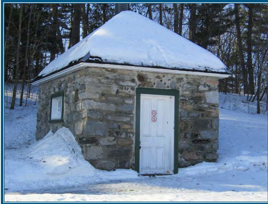
Photo 11: Vue de l'Entrepôt Murs extérieurs en pierres et mortier - le mortier ne contient pas d'amiante Peinture verte et blanche sur la porte et la fenêtre
