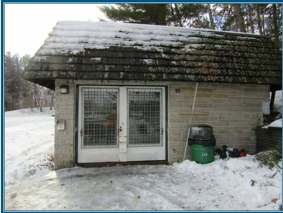
Photo 1: Extérieur, vue de la façade avant Joint de mortier de pierre ne contient pas d'amiante Peinture blanche sur la porte d'entrée
