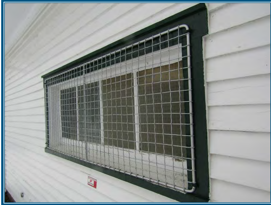
Photo 21: le joint d'étanchéité de fenêtre du garage ne contient pas d'amiante
