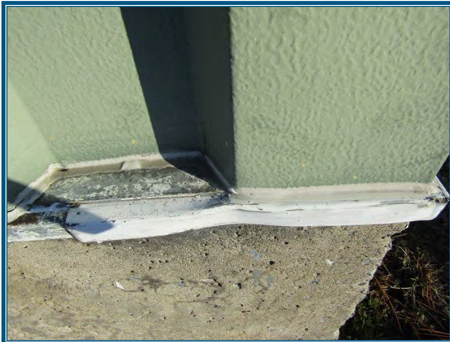
Photo 66: Joint d'étanchéité ne contient pas d'amiante
