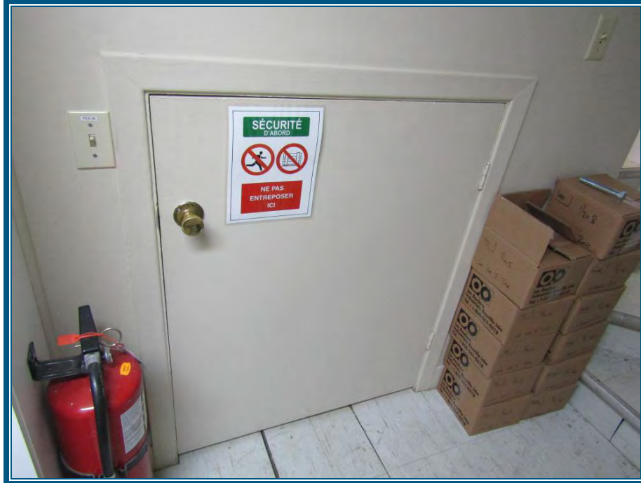
Photo 39: Trappe d'accès au local d'entreposage au rez-de-chaussée
