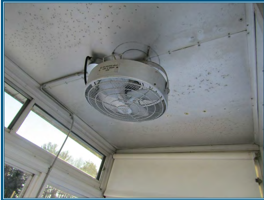
Photo 29 : Logette contrôle amont Plafond en métal
