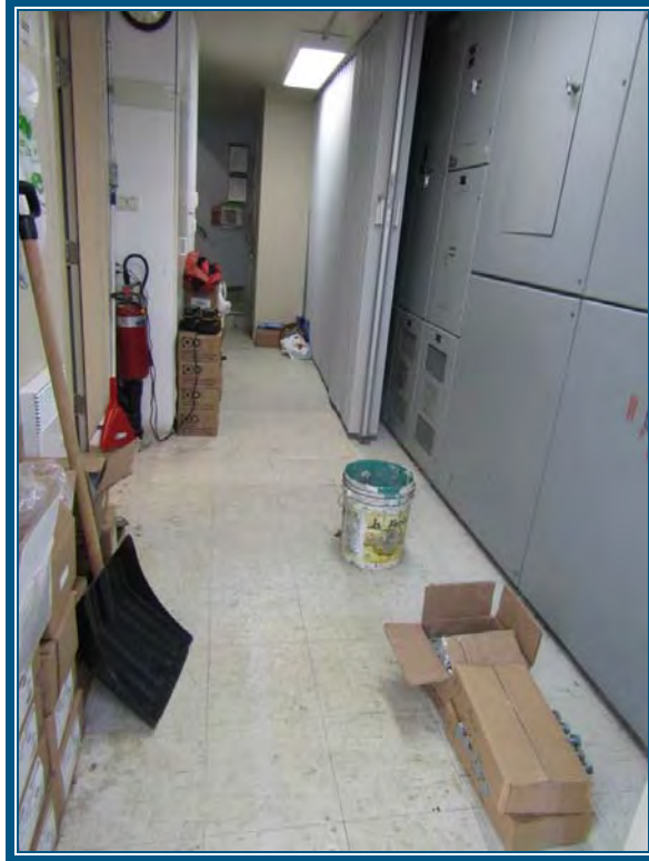
Photo 37: Les tuiles de vinyle au plancher du couloir ne contiennent pas d'amiante
