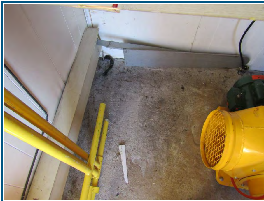
Photo 70: Vue de l'intérieur du poste de contrôle du niveau d'eau Plancher en béton Mur en préfinis
