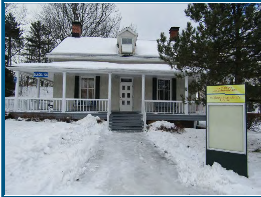
Photo 49: Vue de la façade principale de la maison du maître éclusier Le crépi de ciment avec agglomérats de pierre des murs extérieurs contiennent de l'amiante (phase fini décoratif)
