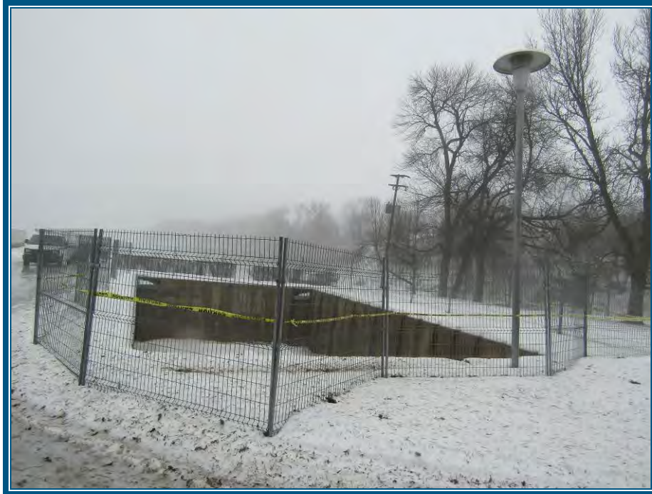
Photo 9: Vue de l'entrepôt à poutrelles clôturé
