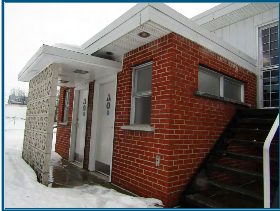
Photo 33: Façade principale de la logette de l'éclusier) le joint d'étanchéité au pourtour des portes ne contient pas d'amiante
