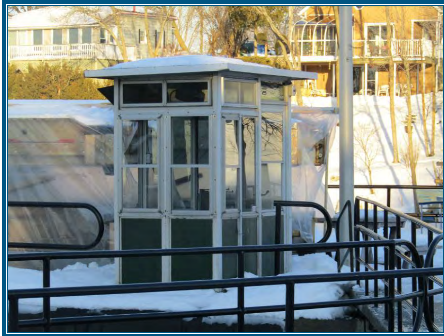
Photo 47: Vue de la logette de contrôle –aval
