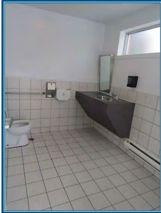
Photo 45: Vue salles de bain façade principale Plancher et bas de mur en céramique, murs et plafond en gypse
