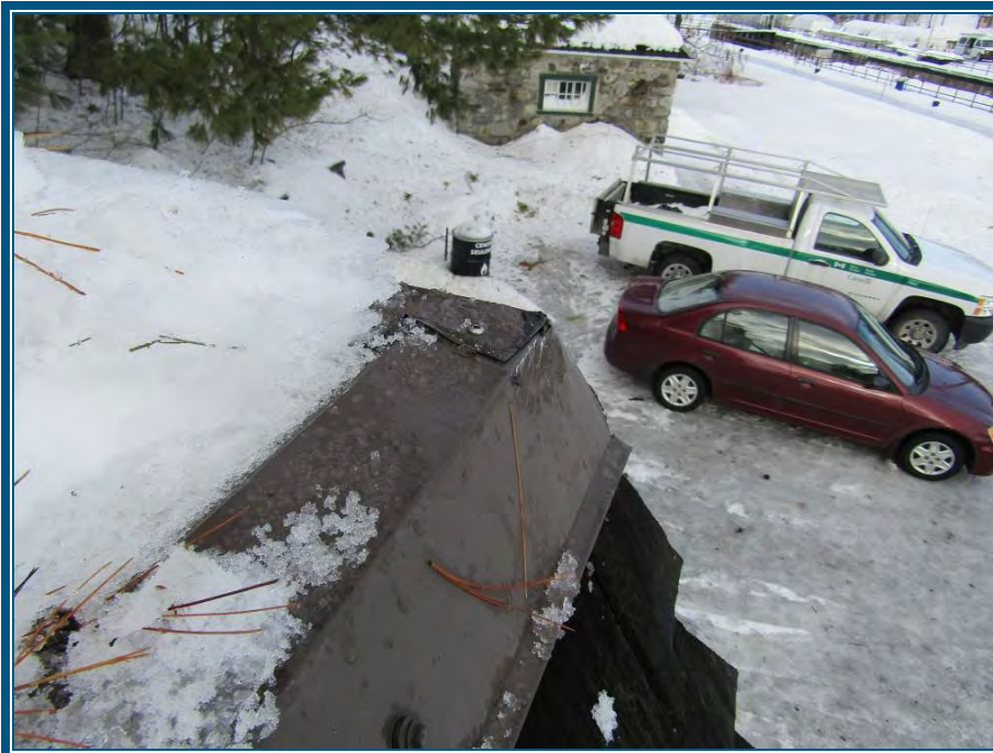
Photo 8: Joint d'étanchéité de toiture ne contient pas d'amiante
