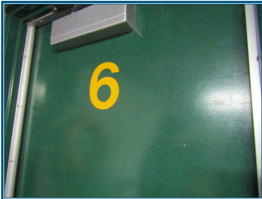
Photo 72: Porte d'entrée au pilier 6
