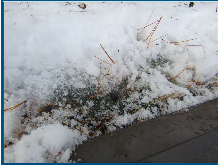
Photo 7: Toiture en asphalte ne contient pas d'amiante
