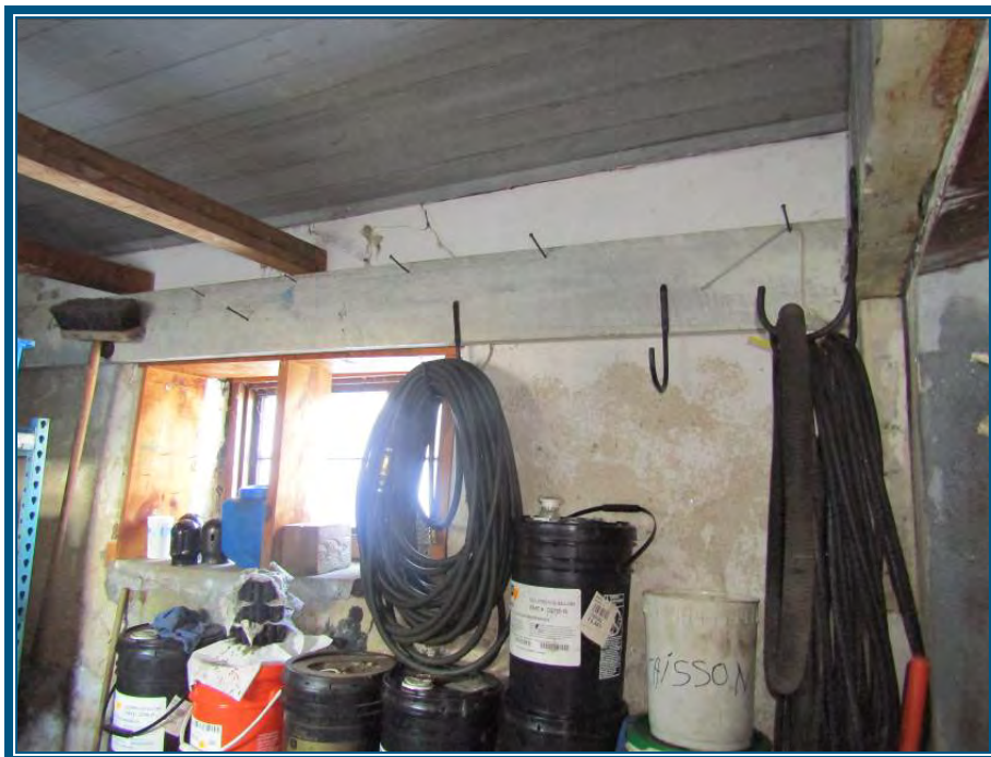
Photo 16: Mur de l'entrepôt Le plâtre-ciment des murs périphériques ne contiennent pas d'amiante
