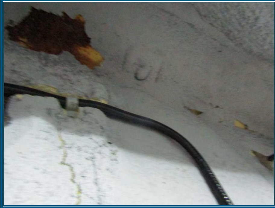
Photo 73: Murs isolés avec du polyuréthane
