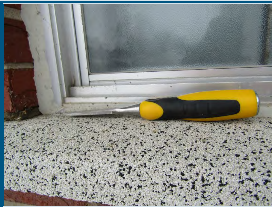
Photo 32: Logette de l'éclusier Le joint d'étanchéité au pourtour des fenêtres ne contient pas d'amiante
