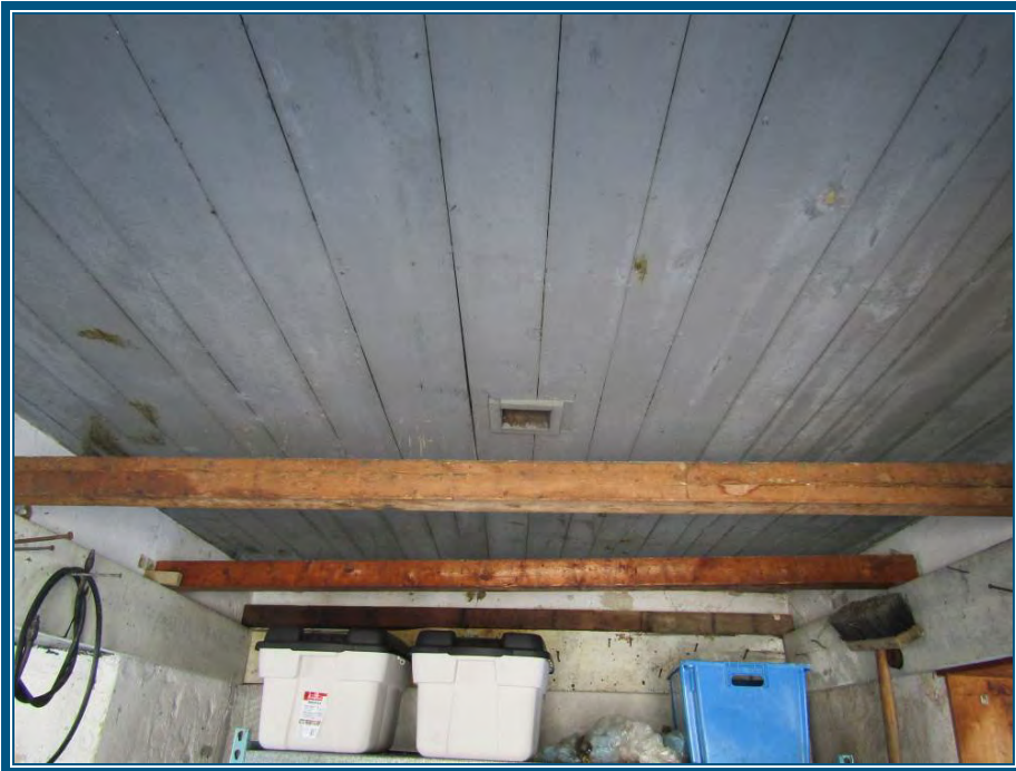
Photo 14: Vue de l'intérieur de l'entrepôt Plafond en bois
