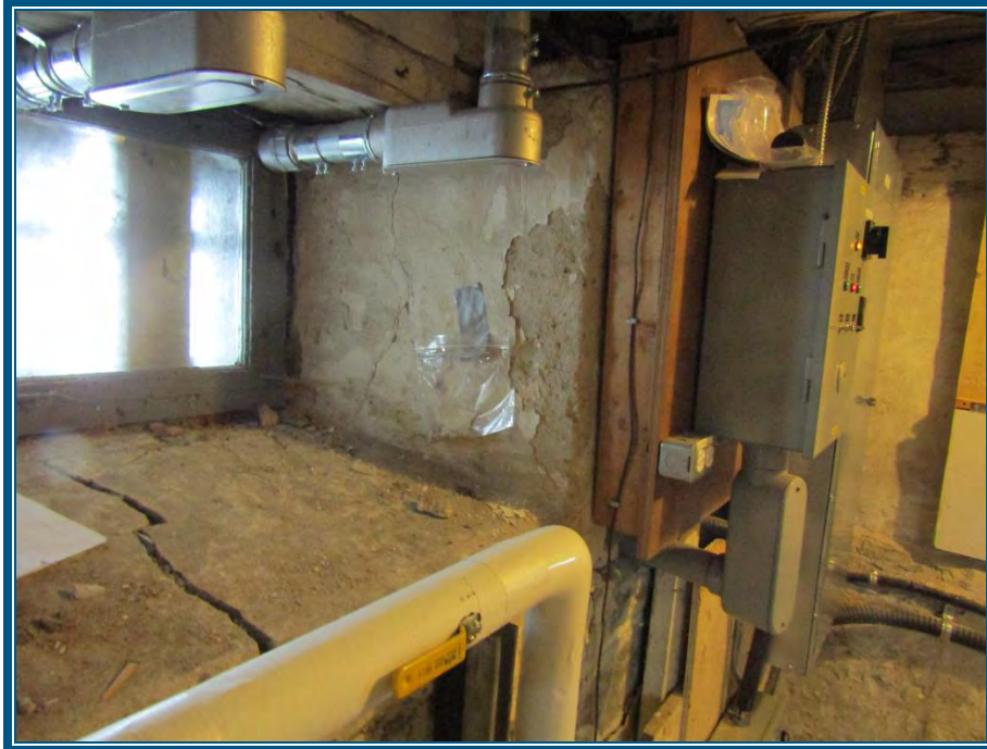
Photo 51: Vue du sous-sol Mur en plâtre-ciment ne contient pas d'amiante
