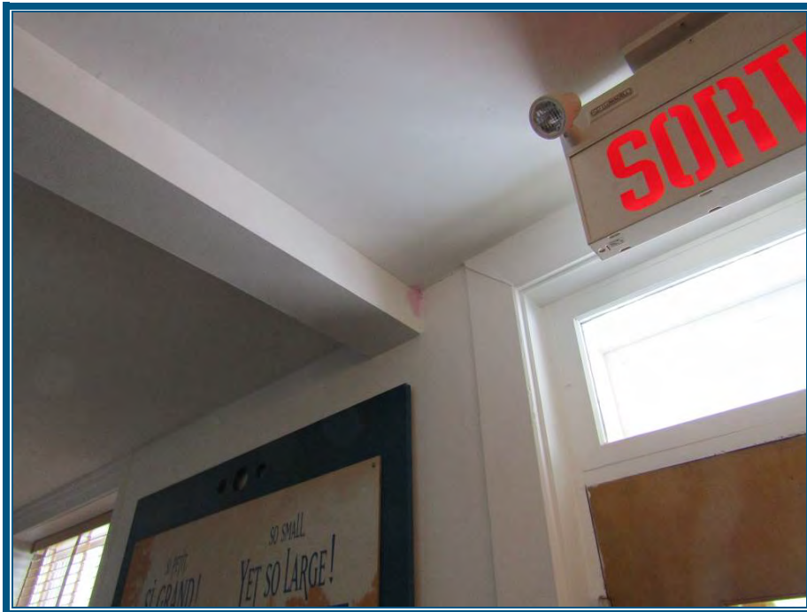
Photo 56: Rez-de-chaussée plafond en gypse ne contient pas d'amiante
