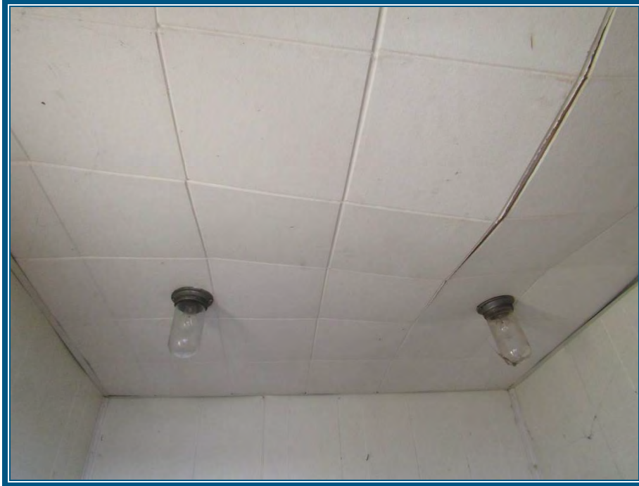
Photo 71: Vue de l'intérieur du poste de contrôle du niveau d'eau Plafond en tuiles acoustiques ne contient pas d'amiante
