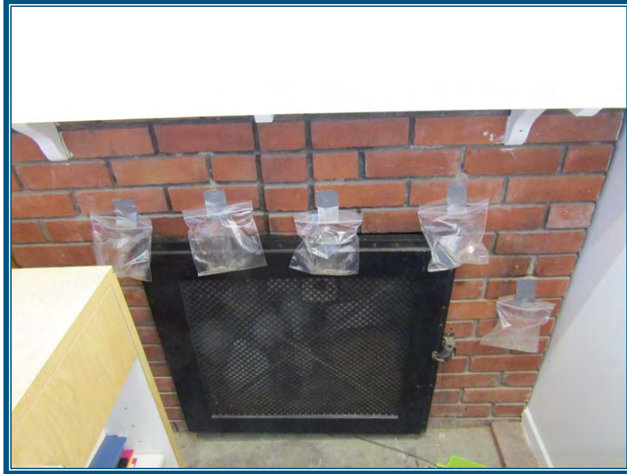
Photo 57: Rez-de-chaussée Le mortier de brique de la cheminée ne contient pas d'amiante
