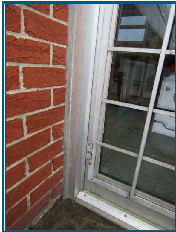
Photo 44: Porte de l'étage Le joint d'étanchéité au pourtour de la porte ne contient pas d'amiante
