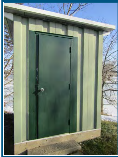
Photo 69: Vue du poste de contrôle du niveau d'eau Joint d'étanchéité au bas du mur extérieur ne contient pas d'amiante
