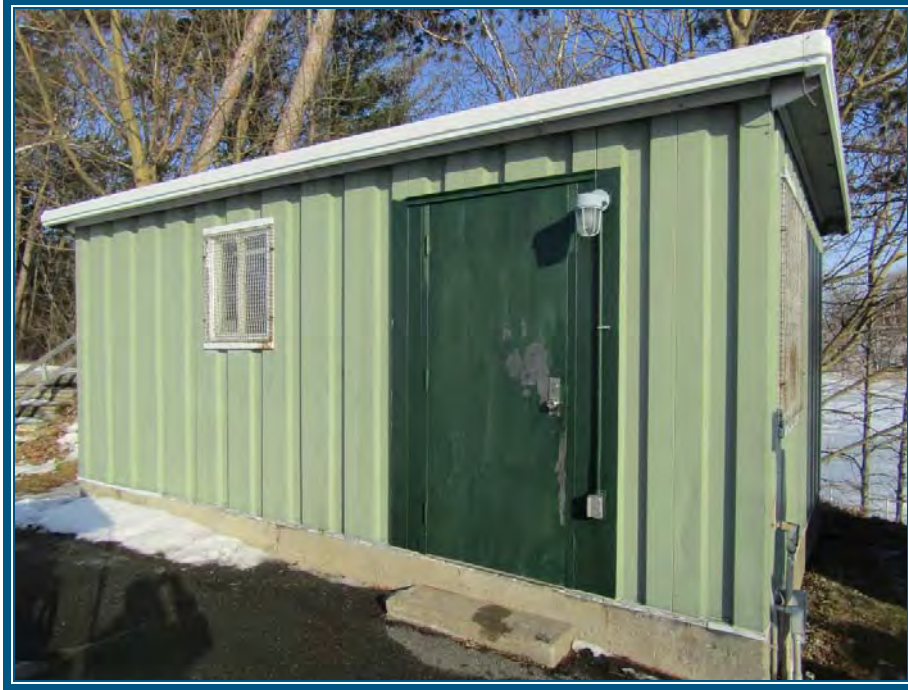
Photo 65: Vue de la façade principale
