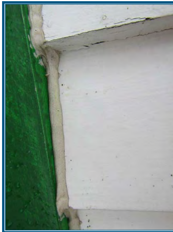
Photo 22: le joint d'étanchéité au pourtour de la porte du garage ne contient pas d'amiante
