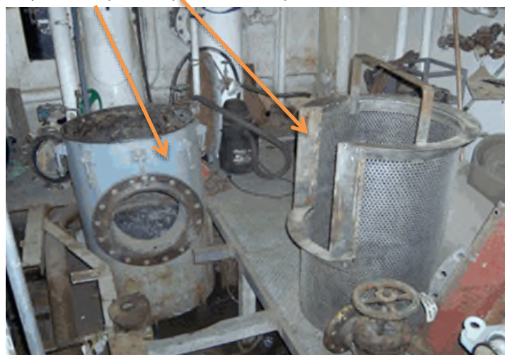
Figure 1.1 Corps de crépine et panier de crépine interne
