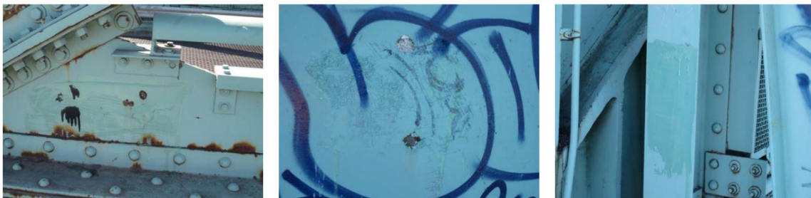
Échantillon avant prélèvement (pont ave. St-Pierre/ave. Dollard direction nord) pris depuis les plaques de renfort et une colonne
