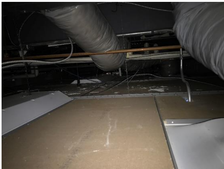
Photos 2 et 3 : Salles B577-B59, plâtre en mauvais état et débris au-dessus des carreaux de plafond
