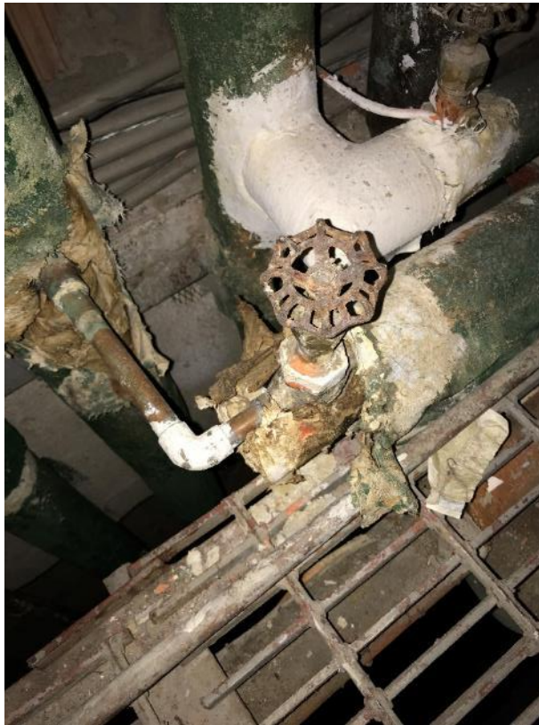
Photo 39 : Châsse 2022-2024, raccords de tuyauterie et calorifuge à alvéoles d'air en mauvais état au niveau du caillebotis de plancher
