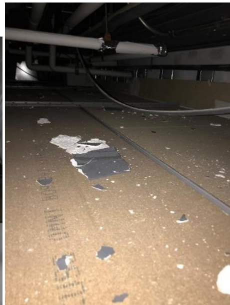
Photos 2 et 3 : Salles B577-B59, plâtre en mauvais état et débris au-dessus des carreaux de plafond
