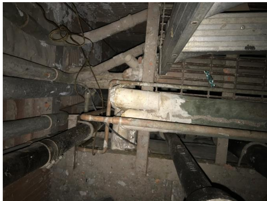
Photo 39 : Châsse 2022-2024, raccords de tuyauterie et calorifuge à alvéoles d'air en mauvais état au niveau du caillebotis de plancher
