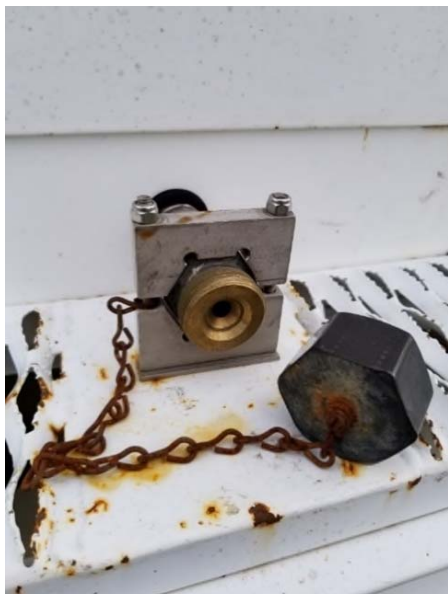
Valve de remplissage
