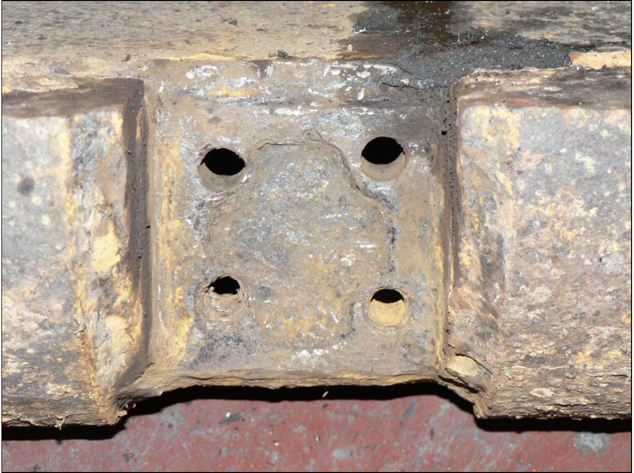
Figure 9 : Semelle de rideau existante, détail au centre montrant les trous pour le raccordement de la charnière
