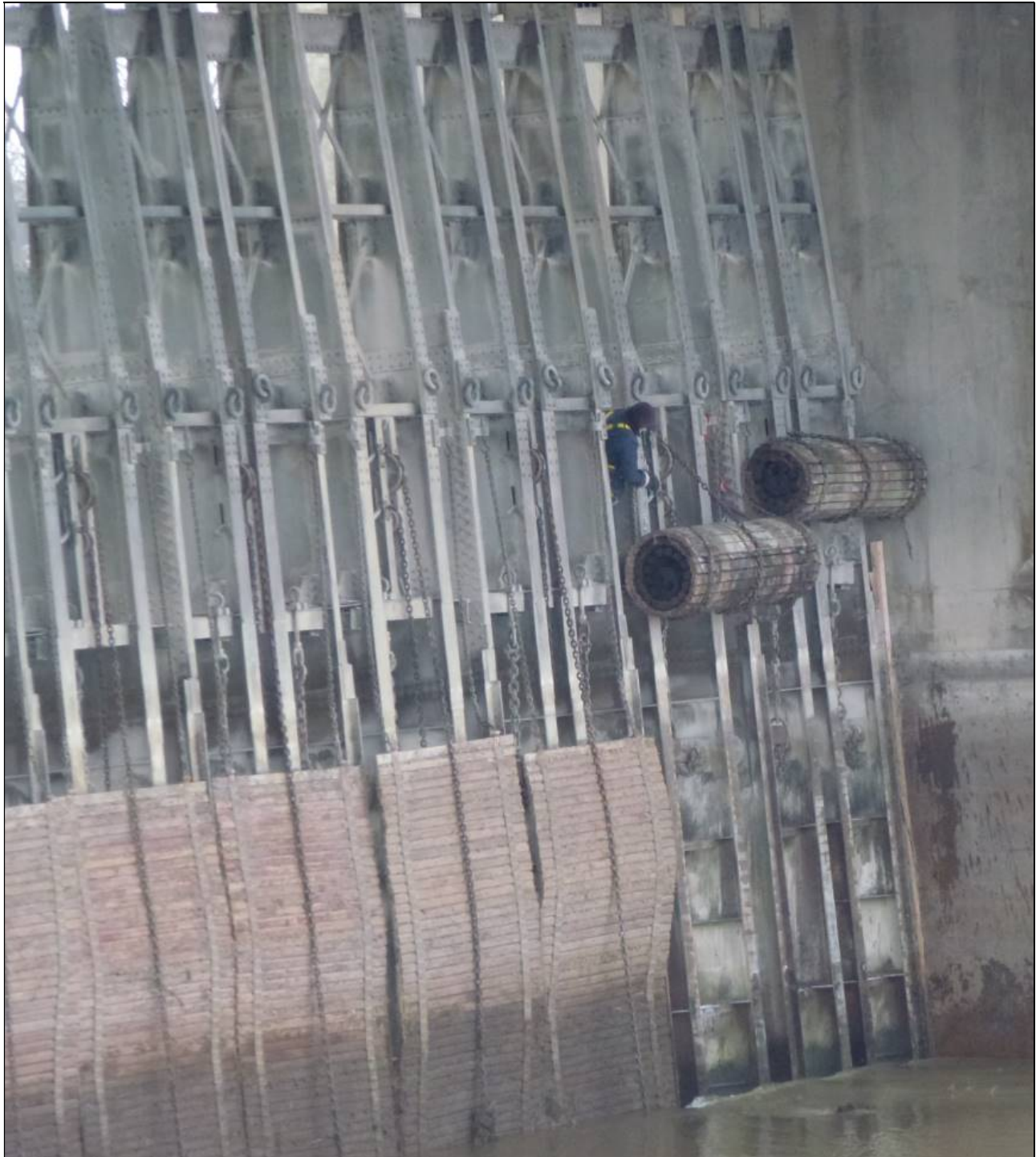
Figure 4 : Côté amont (sud) des cadres. Rideaux déployés à gauche et enroulés à droite L'extrémité de la semelle de rideau est visible au centre de chacun des deux rideaux enroulés.
