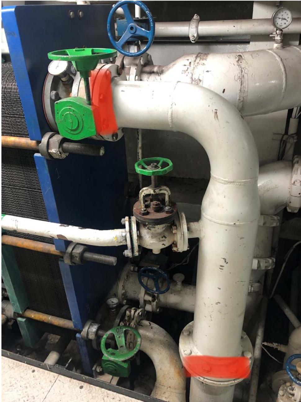
Tuyau du bas 22" entre la bride de sortie du cooler jusqu'à la bride qui mène au collecteur, avec réducteur
