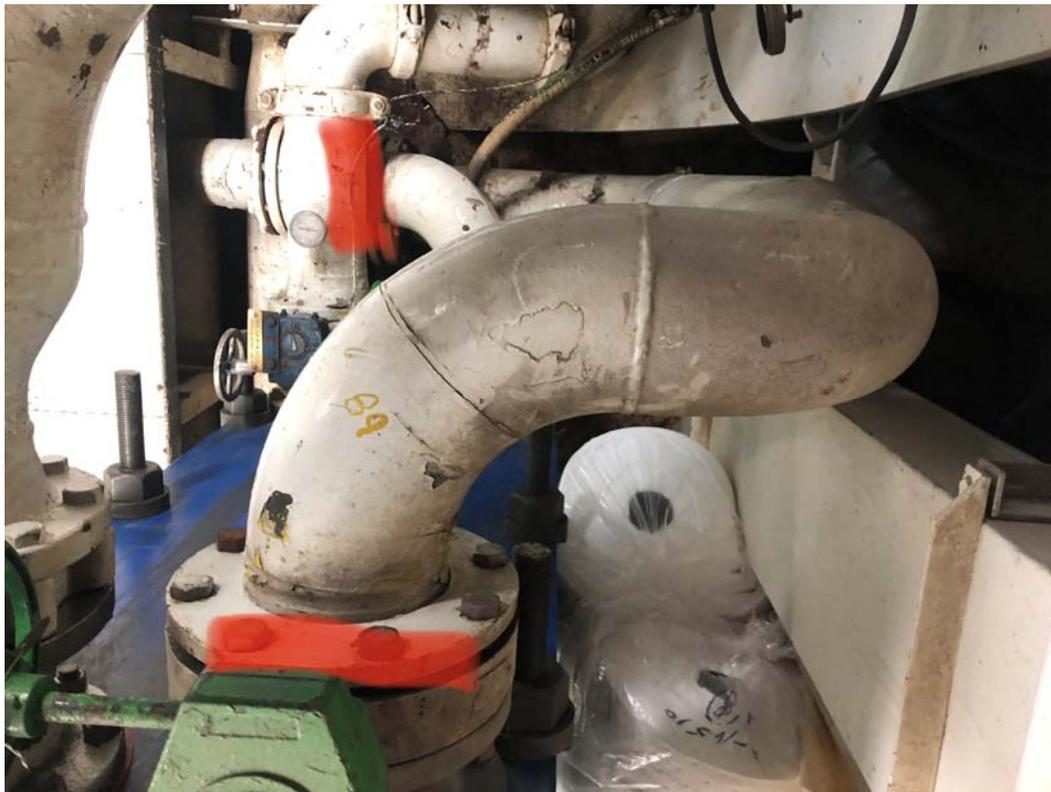
Tuyau du bas 30'' entre la bride de sortie du refroidisseur jusqu'à la bride qui mène au collecteur
