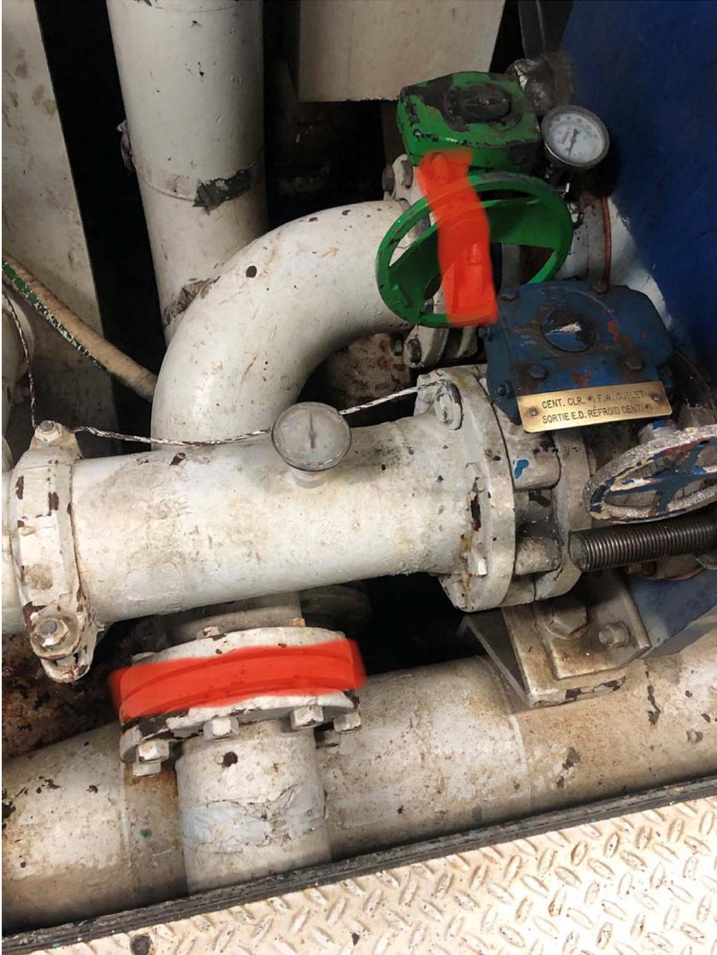
Refroidisseur arrière : Tuyau du haut 60'' entre la bride de sortie du refroidisseur jusqu'à la bride qui mène au collecteur, avec réducteur et dérivation de 2''
