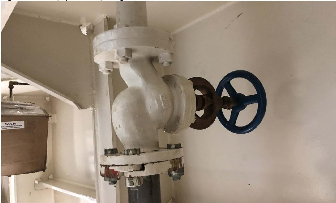
1 gate 2" = soupape pour sonde de niveau (note : très difficile d'accès sur le côté bâbord; voir photo)
