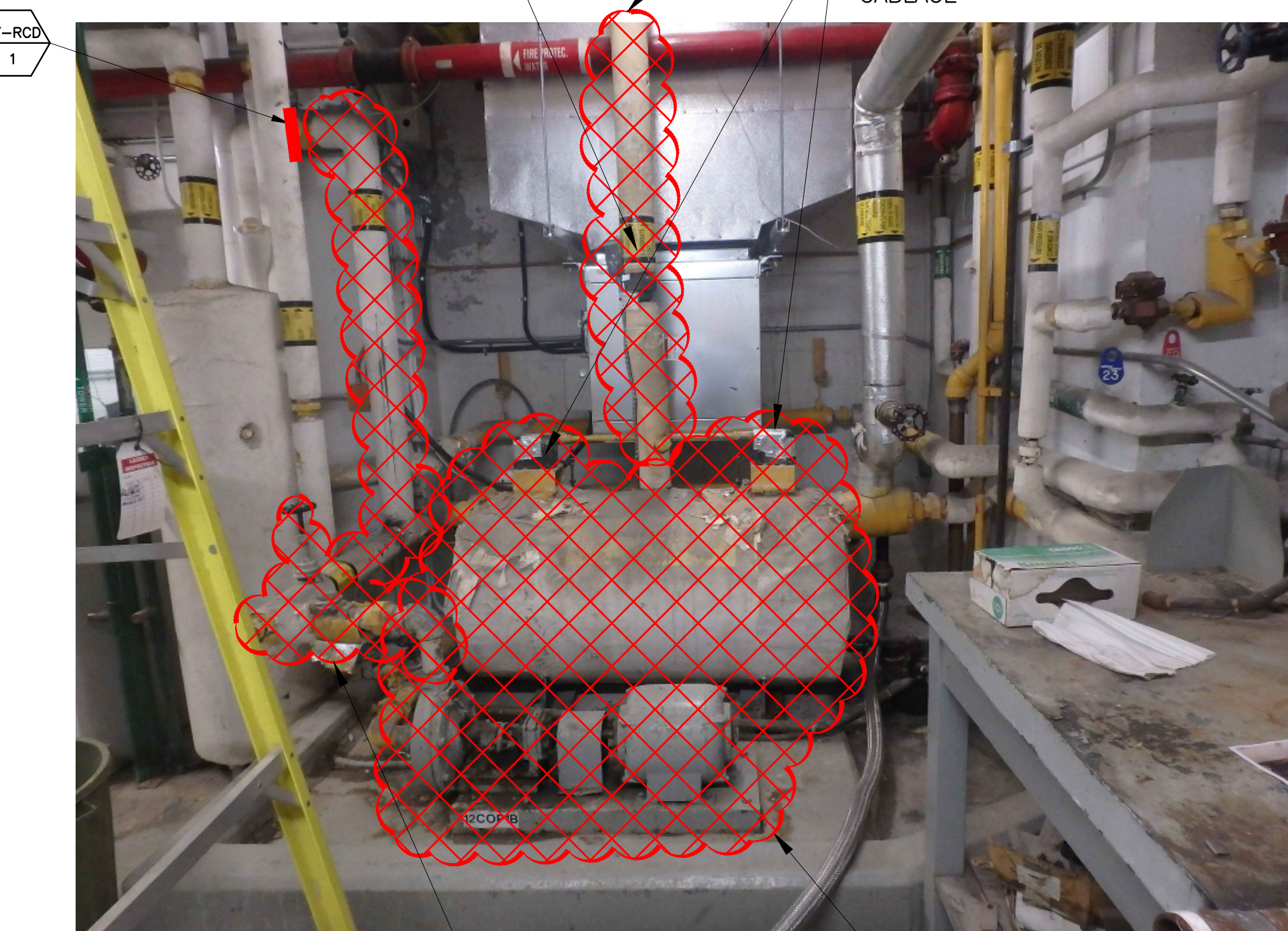
DÉMOLIR LA TUYAUTERIE DE DÉCHARGE EXISTANTE DE LA POMPE À CONDENSAT JUSQU'À L'EMPLACEMENT DU POINT 1
