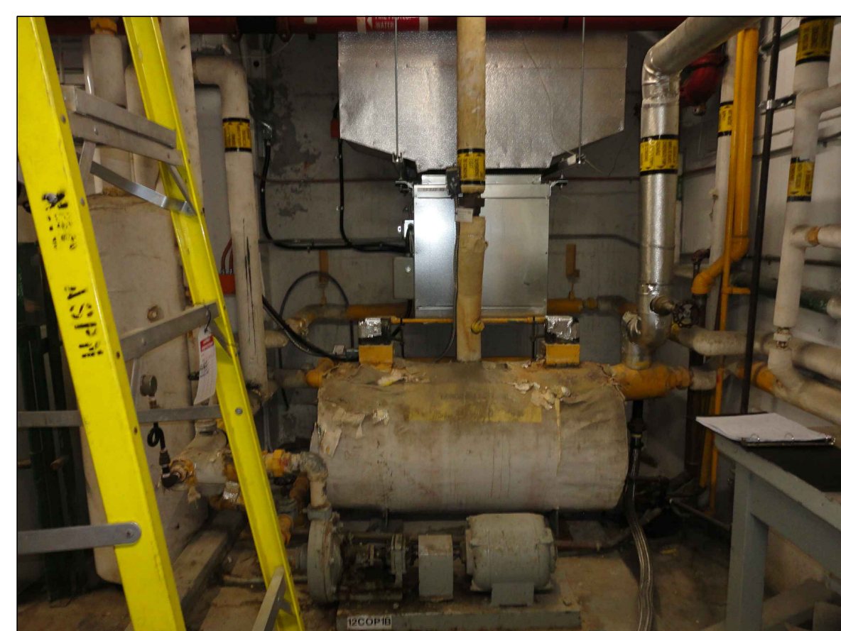
E02/1 RÉSERVOIR DE CONDENSAT EXISTANT N.T.S.
