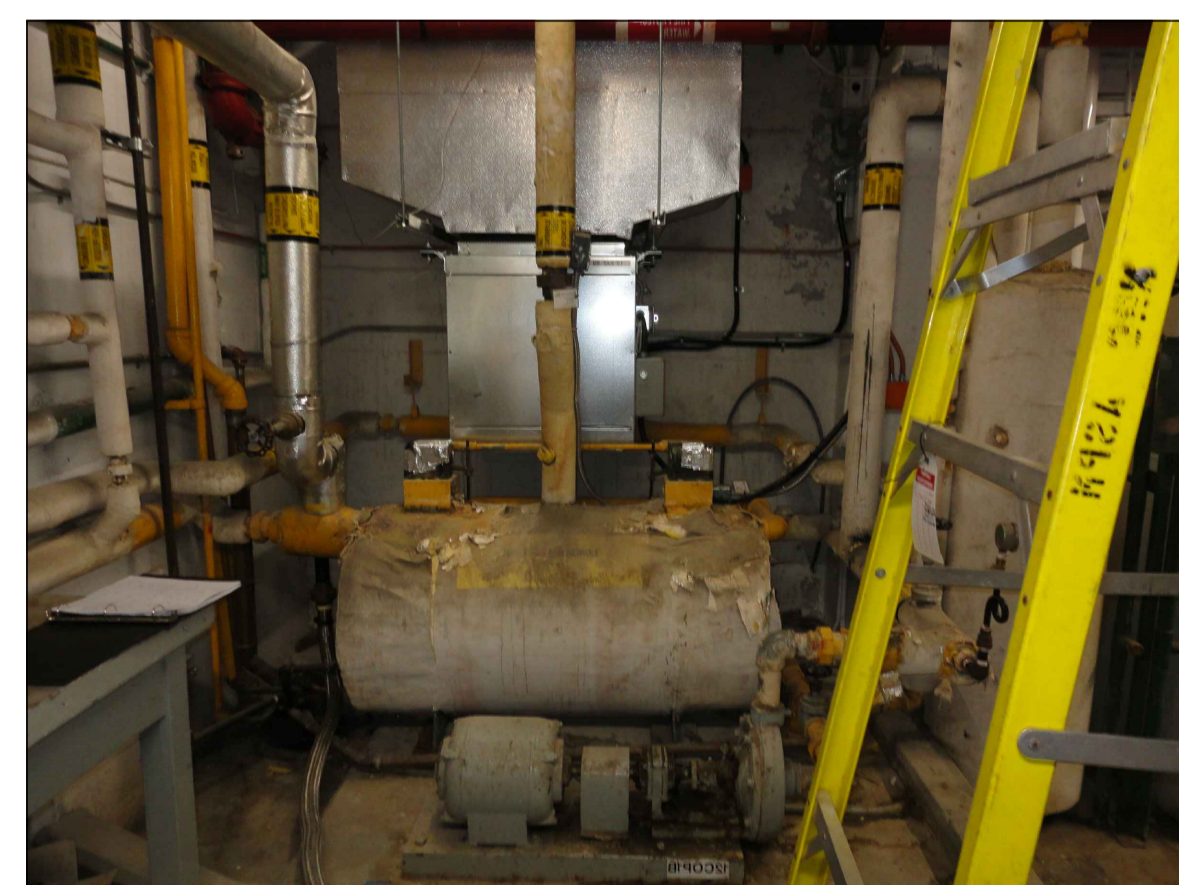
E02 1 EXISTING CONDENSATE TANK N.T.S.
