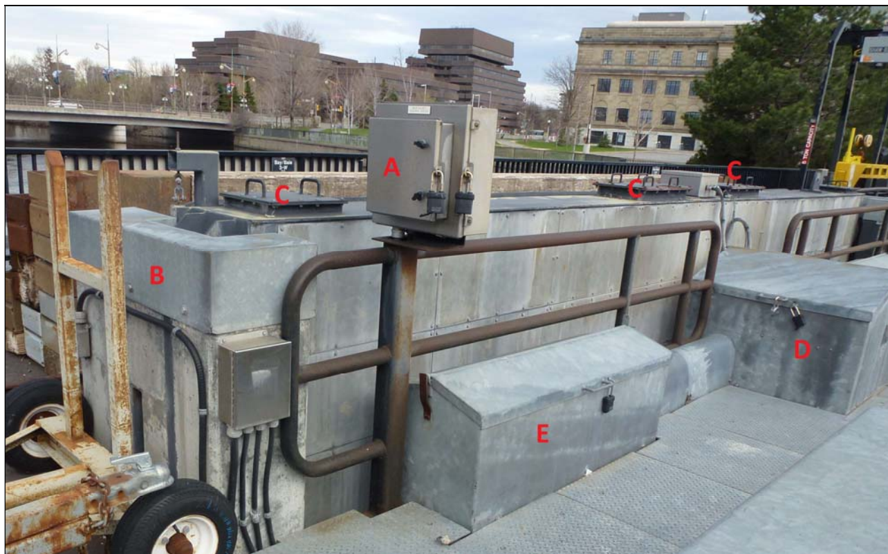
Figure 6 : Identification des composantes des vannes verticales au barrage de l'ouest
