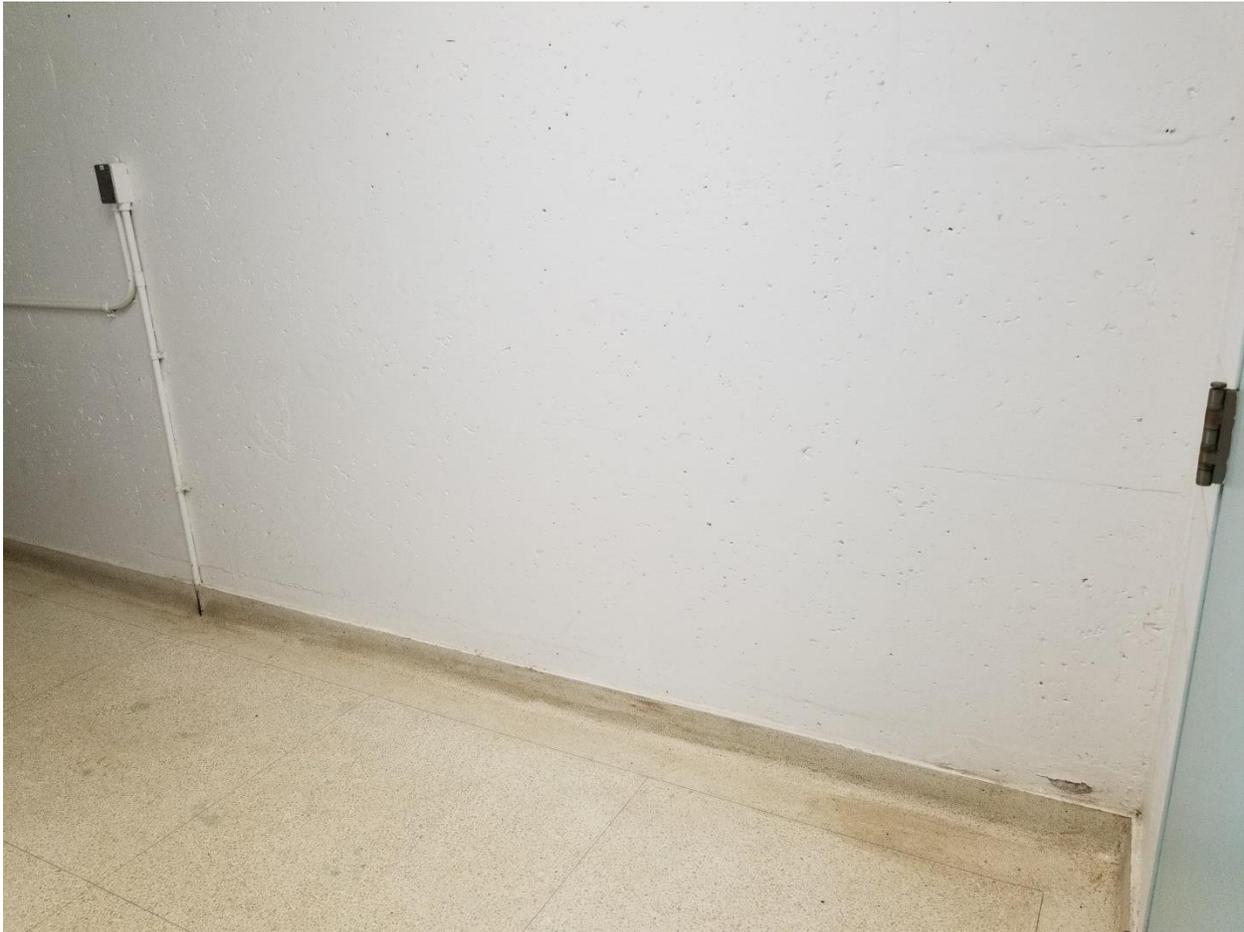
**Photographie 3** : Peinture blanche, appliquée sur les murs dans la cage d'escalier du sud-est; cette peinture renferme 557 ppm de plomb (Échantillon DST LP-03).
