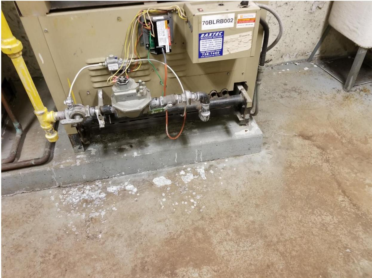
**Photographie 1** :- Peinture grise, appliquée sur le plancher de la chaufferie; cette peinture renferme 949 ppm de plomb (Échantillon DST LP-01).
