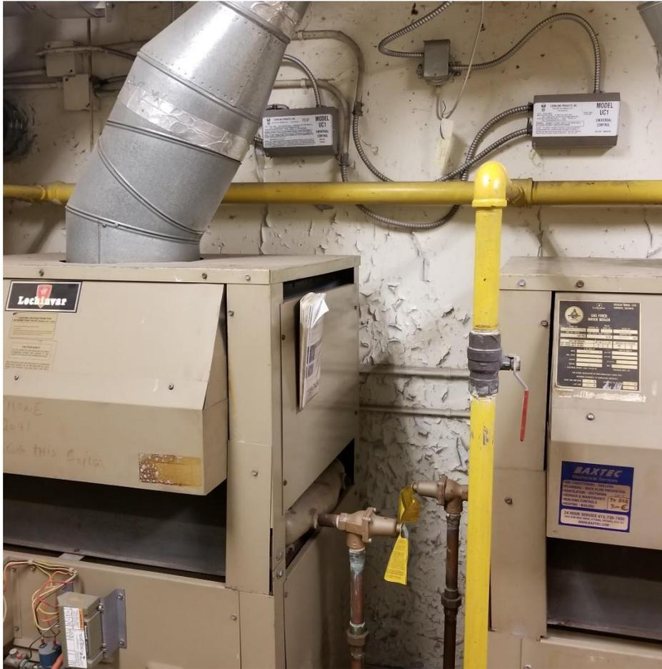
**Photographie 2** : Peinture beige, appliquée sur les murs de la chaufferie; cette peinture renferme 1 320 ppm de plomb (Échantillon DST LP-02).
