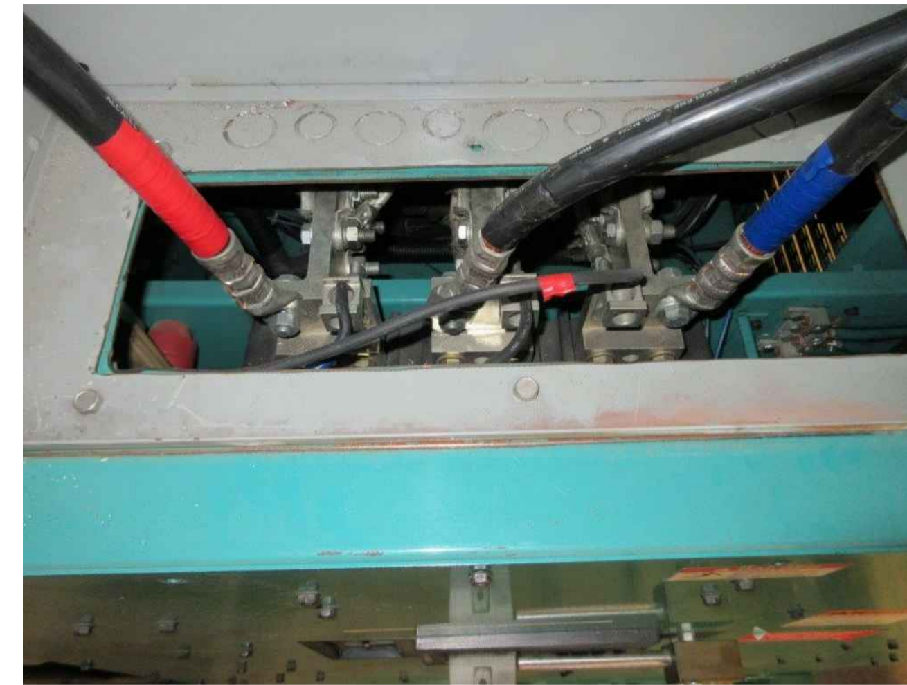
2 E5 GENERATOR PULLBOX Scale: N.T.S.
